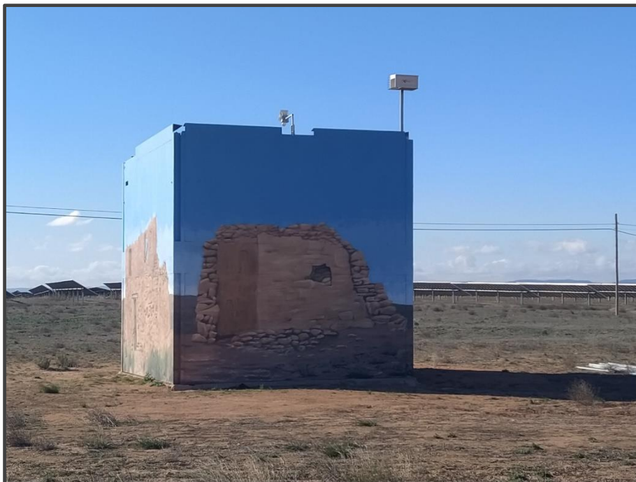
Fotografía 17. Exterior del primillar, pintado.
