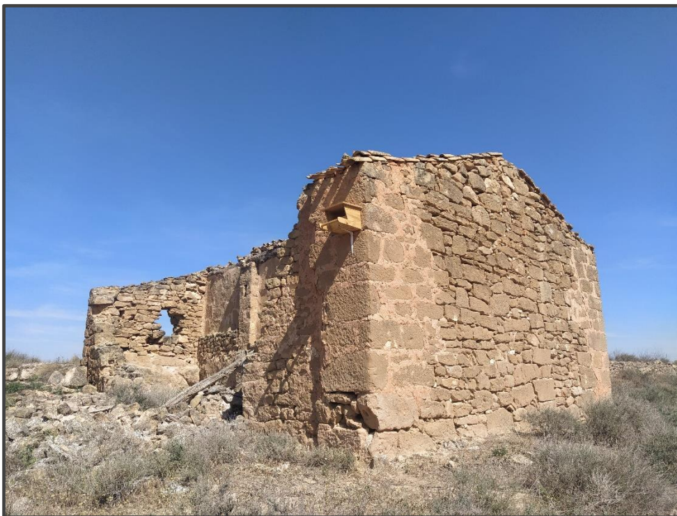
Fotografía 36. Caja para rapaces, sobre muro.
