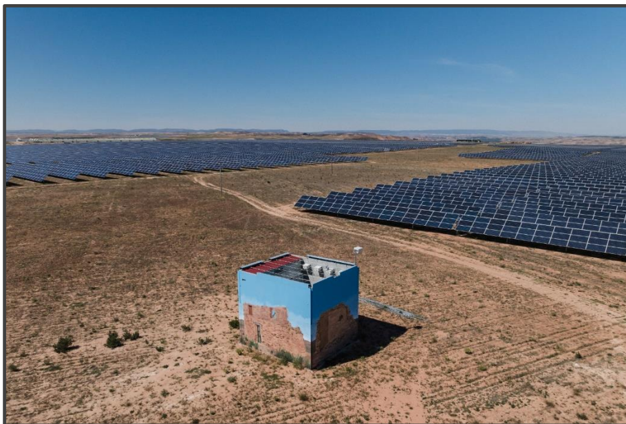
Fotografía 18. Exterior del primillar, pintado.
