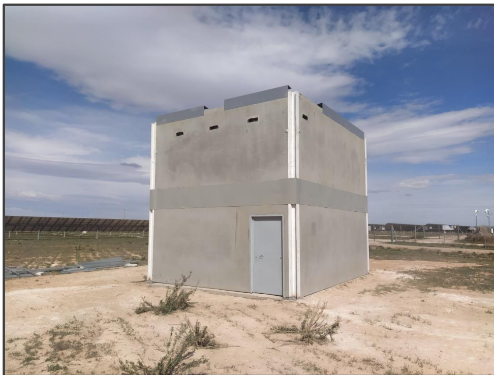
Fotografía 15. Exterior del primillar de nueva construcción.
