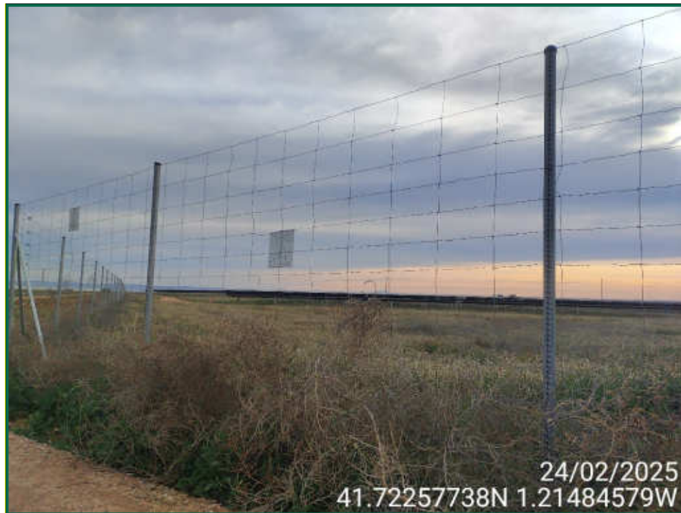
Fotografía 22. Placas anticollisión y vallado perimetral.
