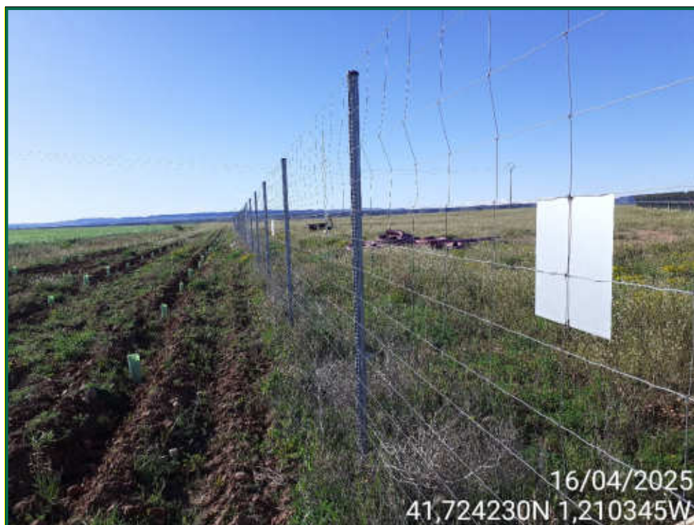
Fotografía 21. Placas anticollisión y vallado perimetral.
