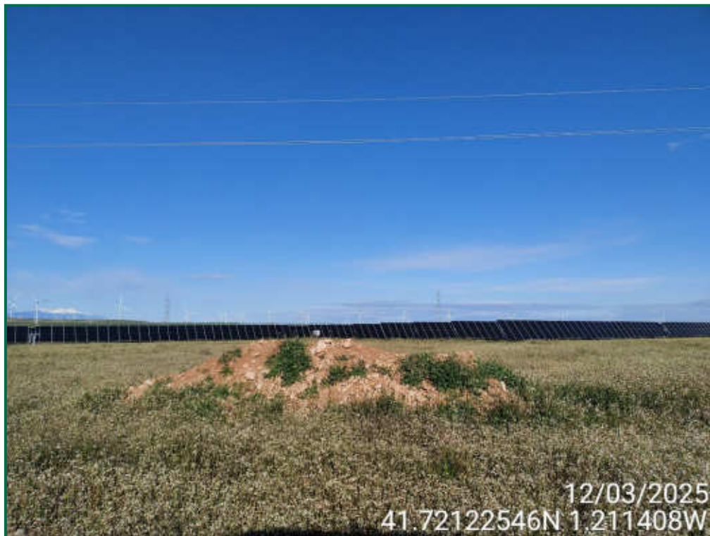
Fotografía 2. Zona de acumulación de tierra dentro de la PFV.
