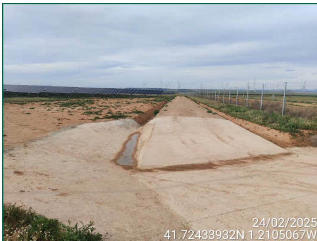
Fotografía 6. Viales y cunetas dentro de la PFV.
