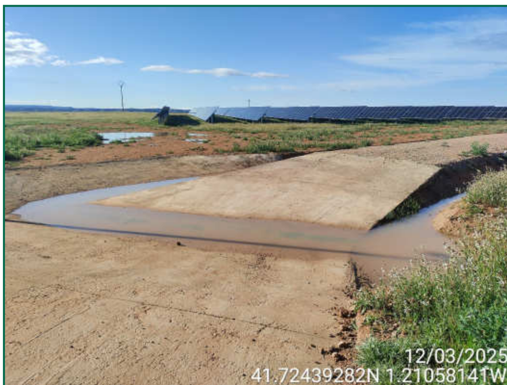
Fotografía 7. Viales y cunetas dentro de la PFV.
