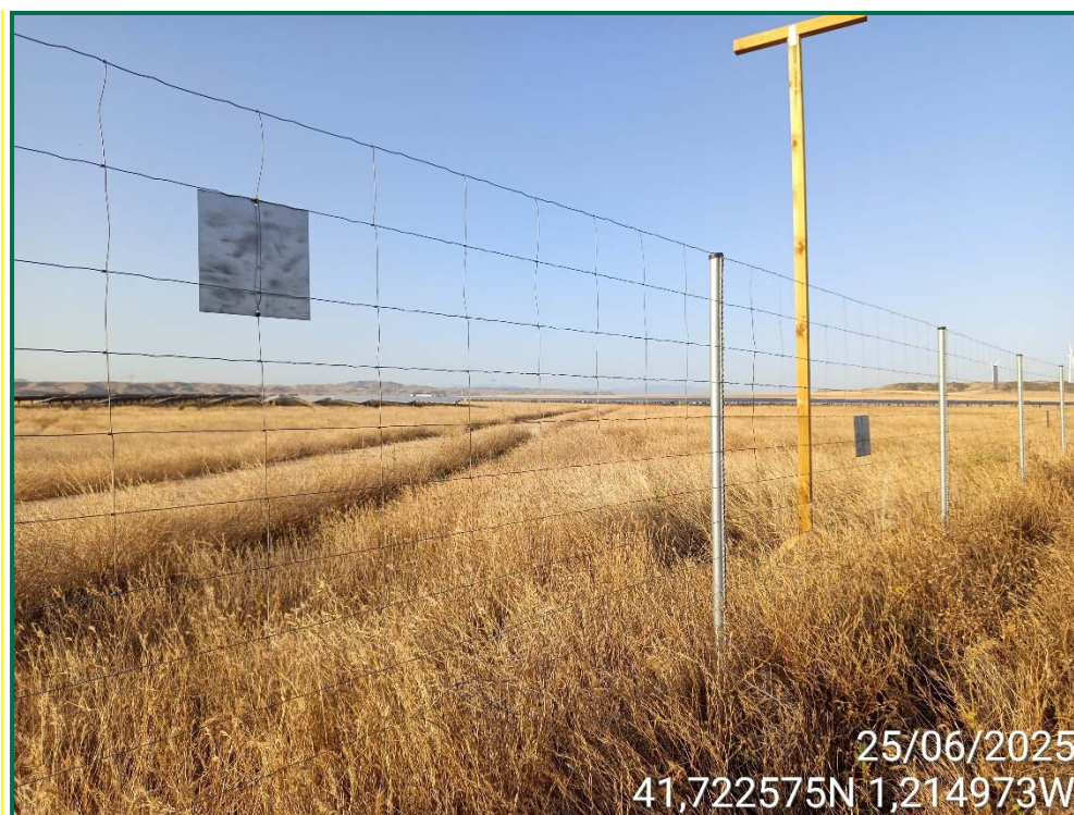
Fotografía 22. Placas anticolisión y vallado perimetral.
