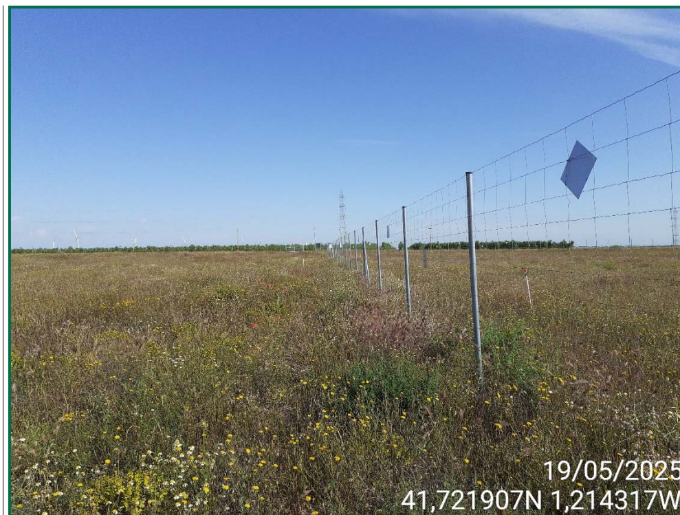
Fotografía 21. Placas anticollisión y vallado perimetral.
