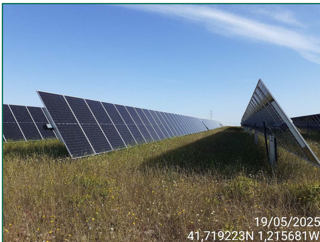
Fotografía 13. Vegetación herbácea entre seguidores.
