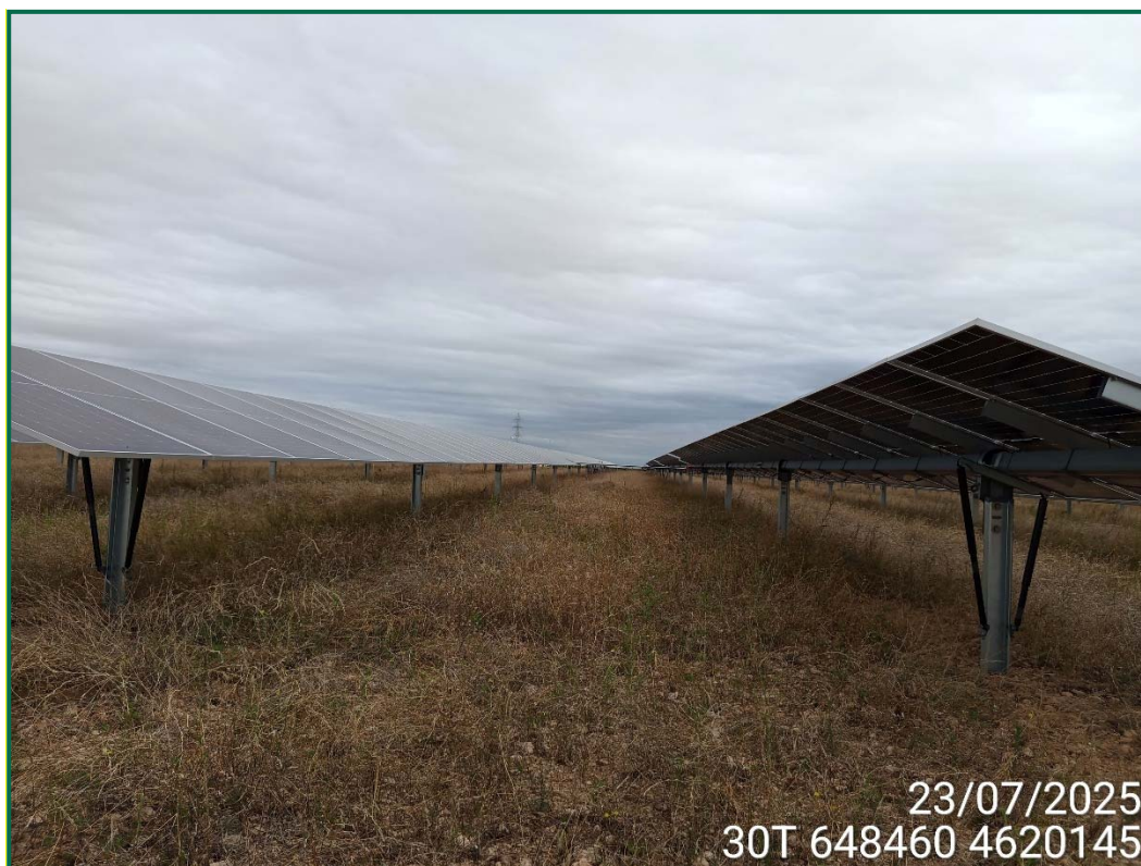
Fotografía 12. Vegetación herbácea entre seguidores.
