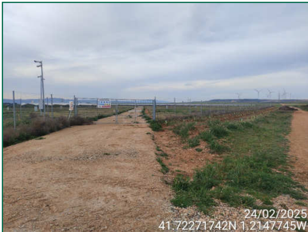
Fotografía 2. Entrada a la PFV.
