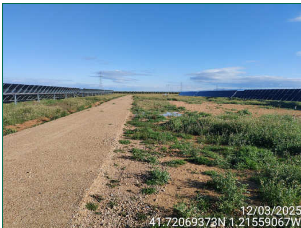
Fotografía 4. Viales y cunetas dentro de la PFV.
