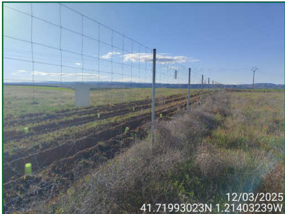
Fotografía 20. Placas anticolidión y vallado perimetral.
