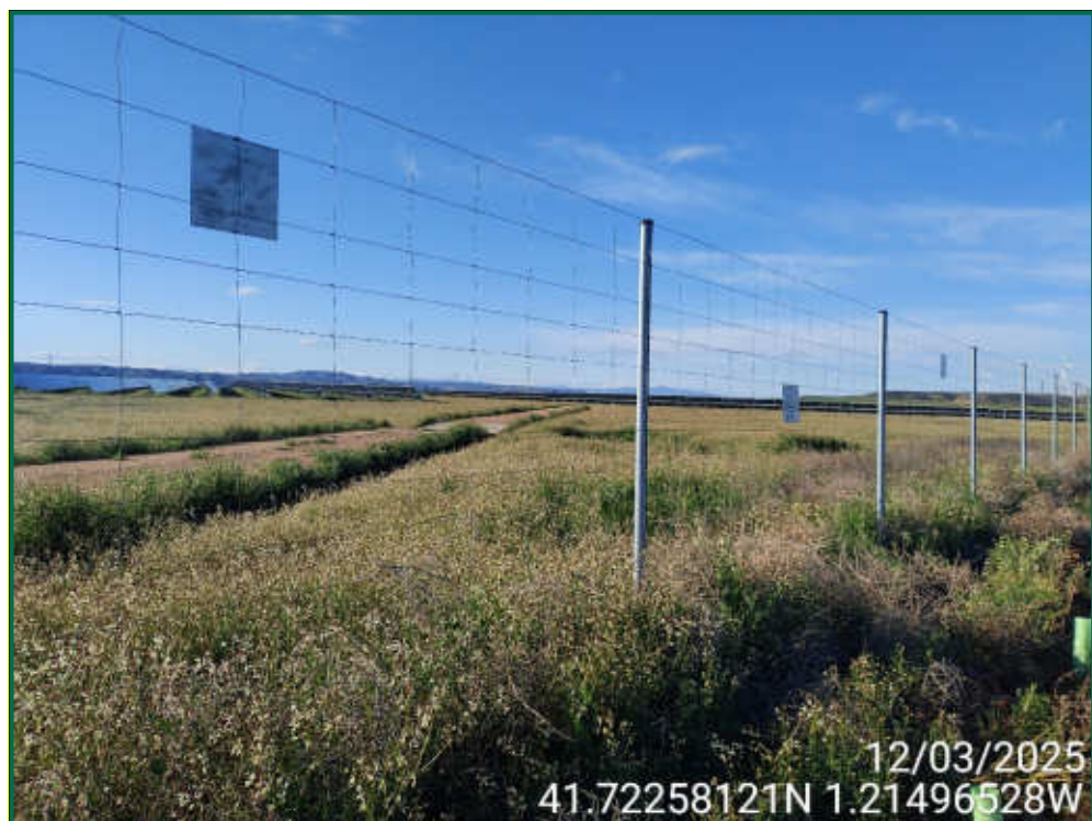
Fotografía 21. Placas anticolidión y vallado perimetral.
