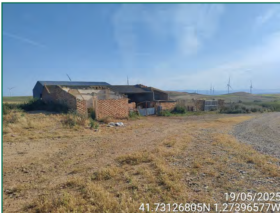
Fotografía 46. Edificación “La paridera de cabanillas”.
