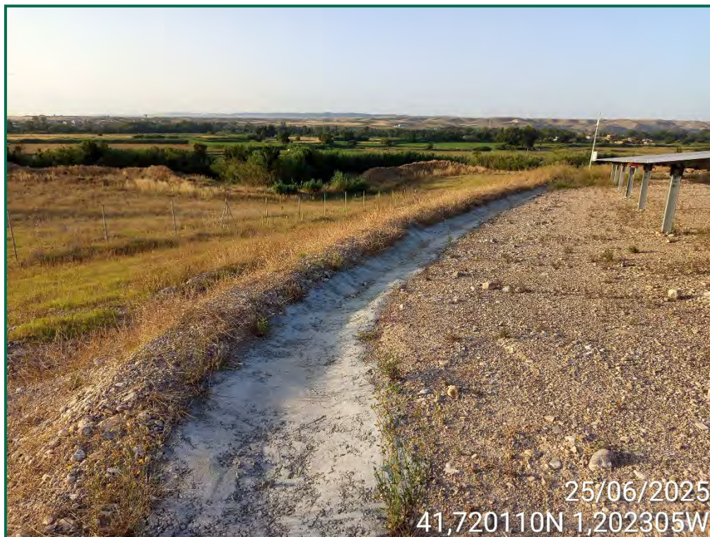
Fotografía 10. Cuneta de evacuación de agua.
