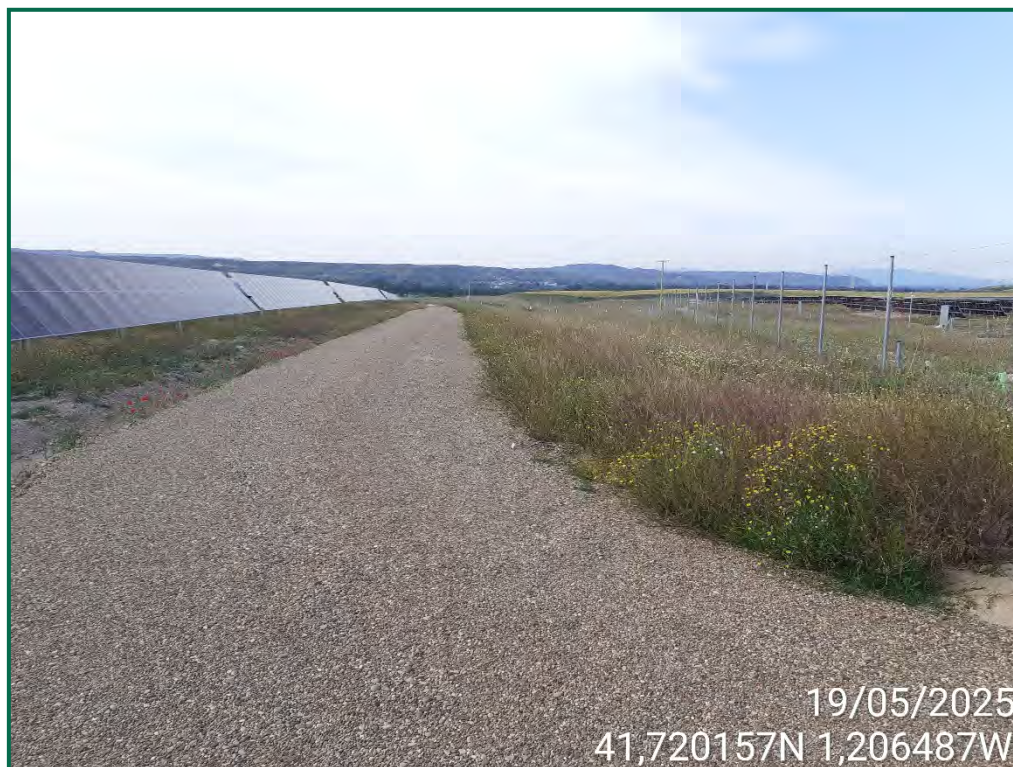
Fotografía 9. Viales y cunetas dentro de la PFV.
