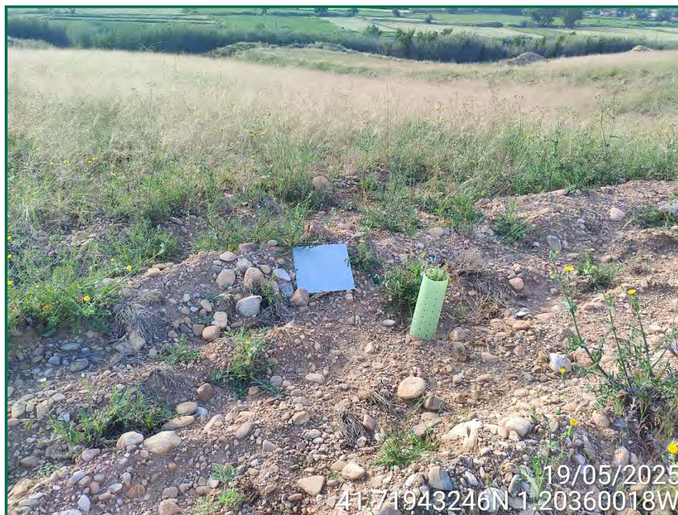
Fotografía 30. Placa anticolidión desprendida.
