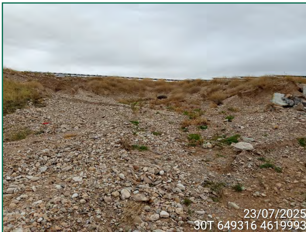
Fotografía 4. Zona de nivelado de tierra dentro de la PFV después del temporal.
