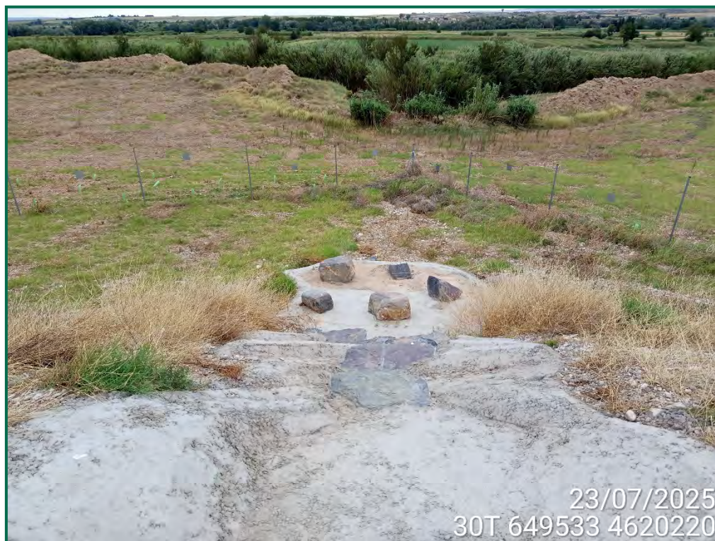
Fotografía 13. Zonas de acumulación de agua por escorrentía sin daños tras el temporal.
