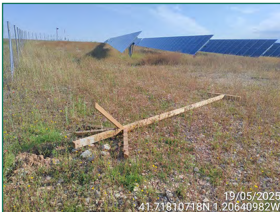
Fotografía 33. Posadero para rapaces desprendido en mayo.
