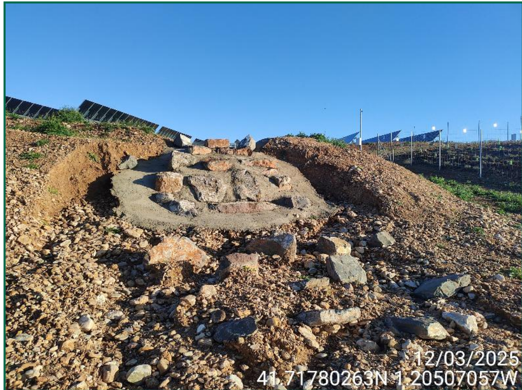
Fotografía 5. Zonas de acumulación de agua por escorrentía.
