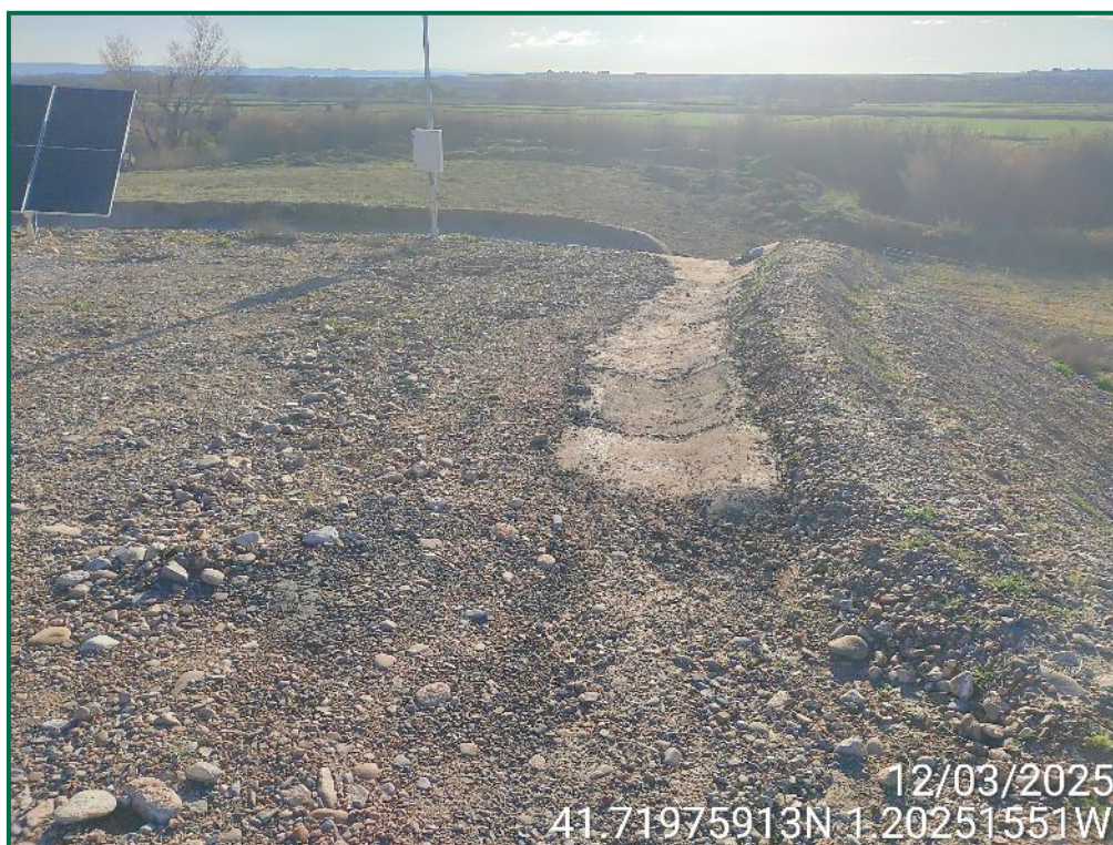
Fotografía 7. Cuneta de evacuación de agua.
