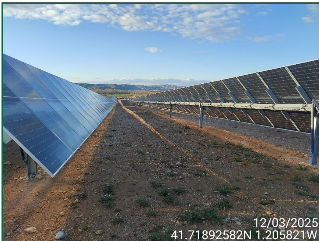
Fotografía 10. Vegetación herbácea entre seguidores.
