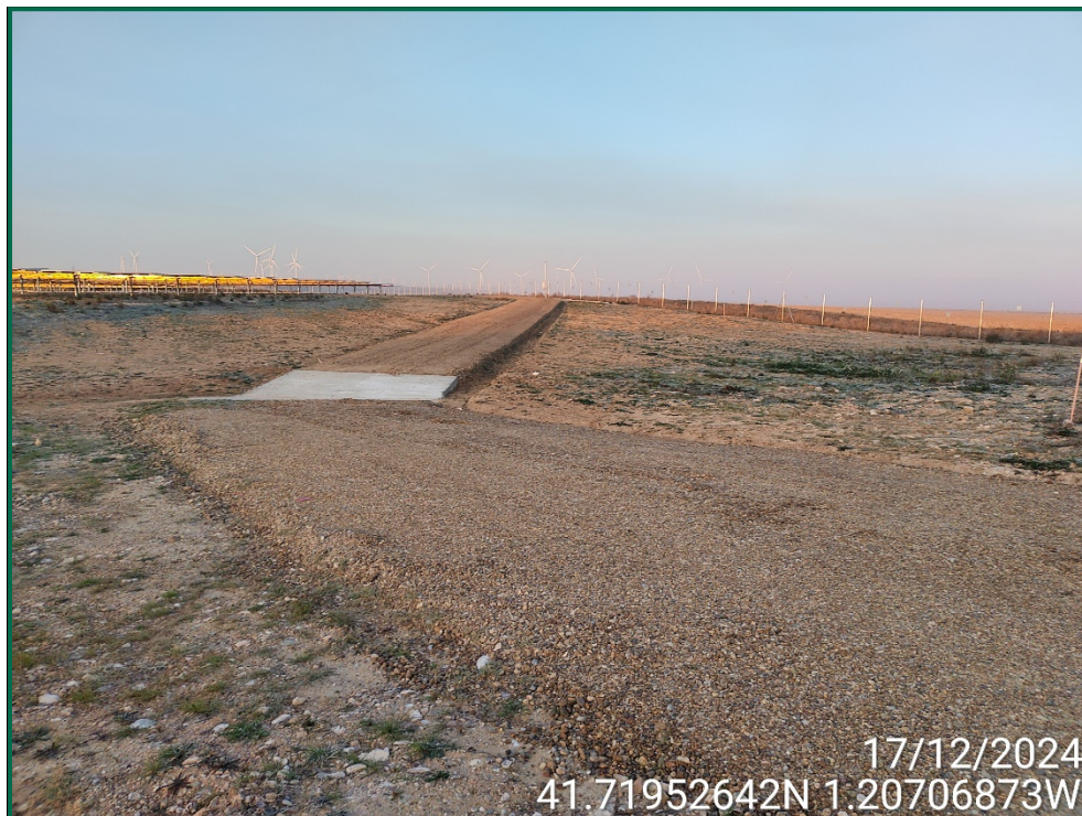
Fotografía 3. Habilitación de viales y cunetas.
