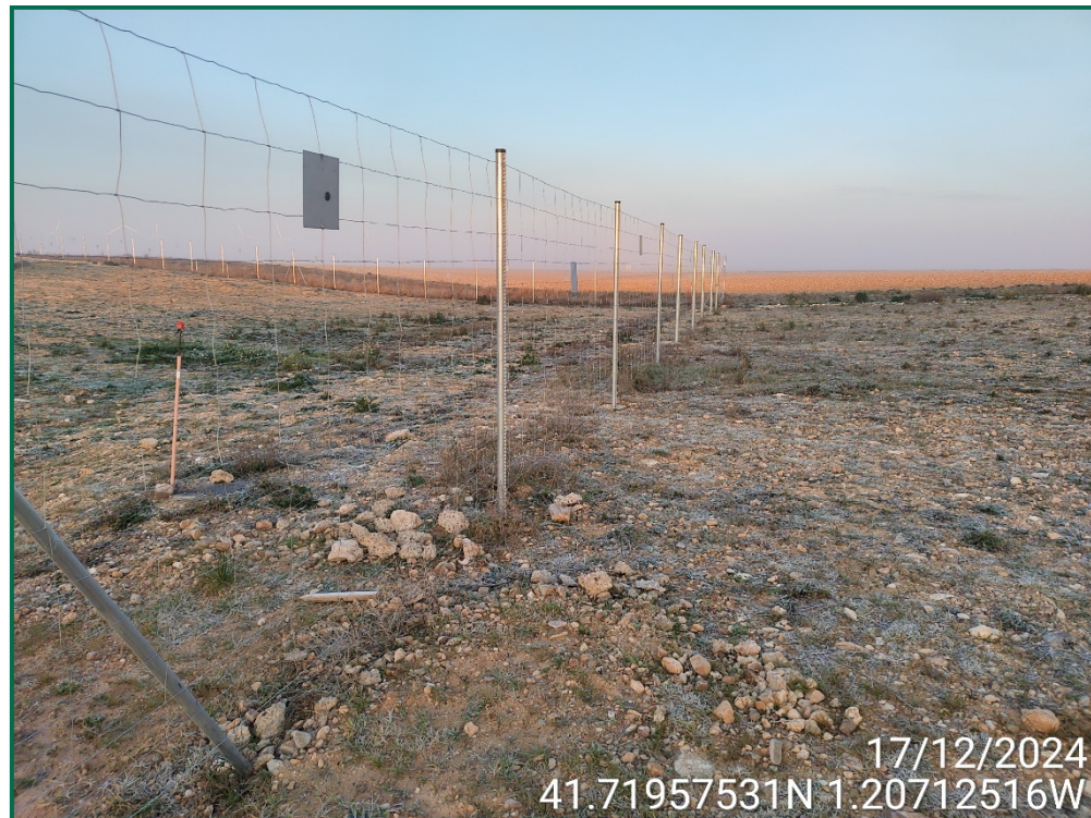
Fotografía 7. Vallado perimetral y placas anticolisión.
