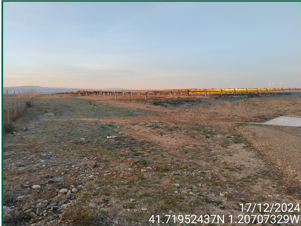
Fotografía 4. Superficie de la obra.
