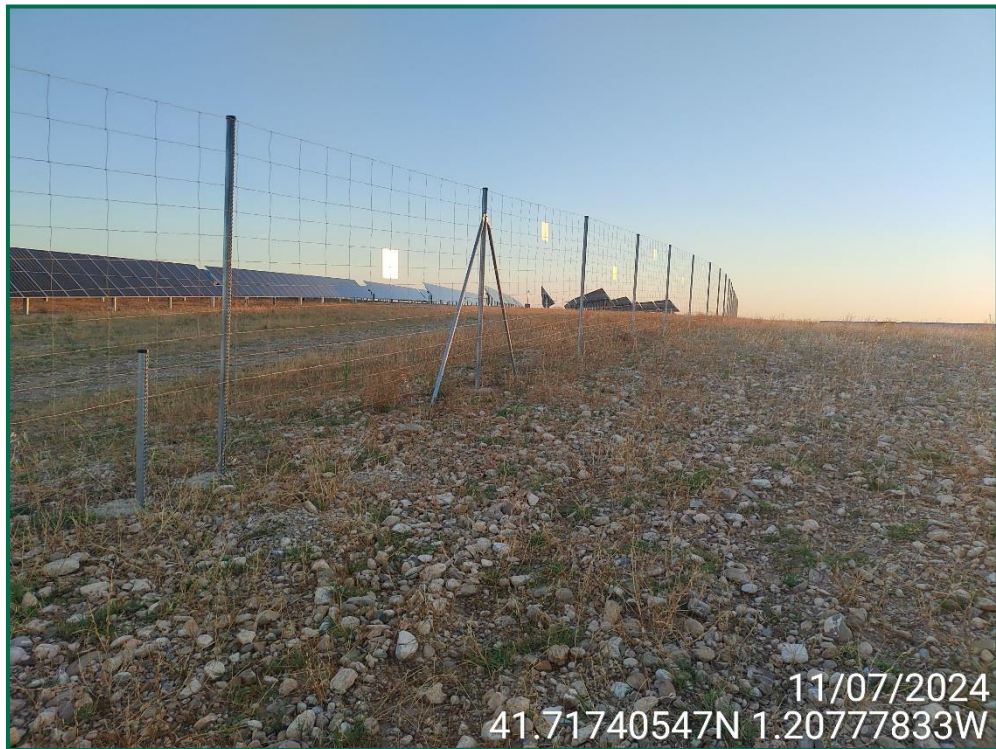
Fotografía 8. Vallado perimetral y placas anticolidión.
