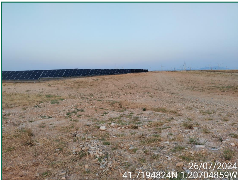
Fotografía 5. Superficie de la obra.
