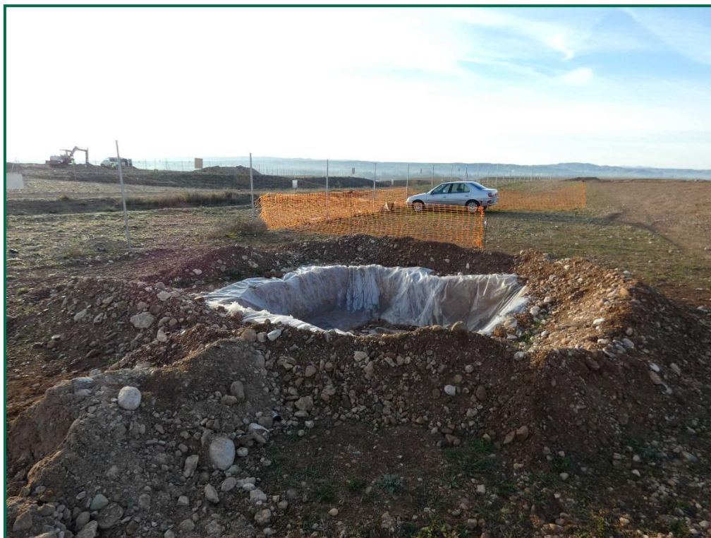
Fotografía 27. Balsa de limpieza.
