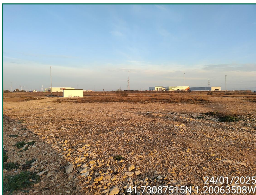
Fotografía 31. Final de la línea de evacuación.
