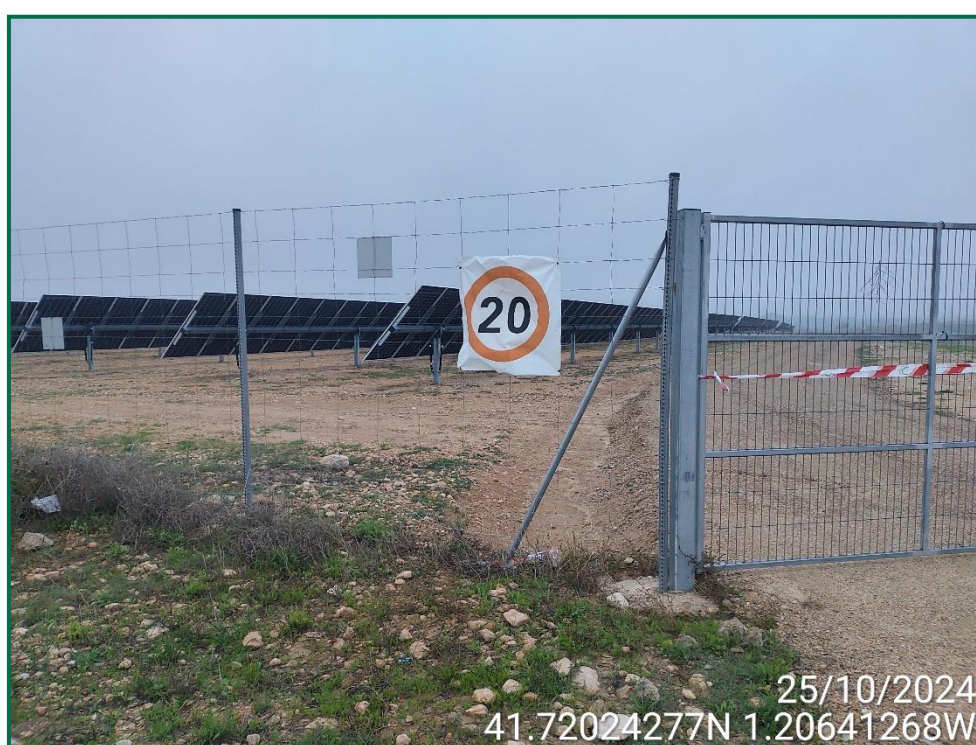
Fotografía 6. Señalización de velocidad.
