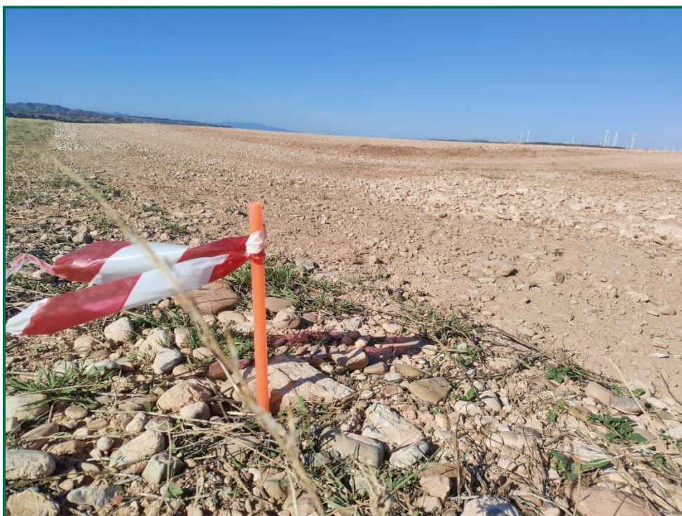
Fotografía 1. Jalonamiento previo mediante estacas.
