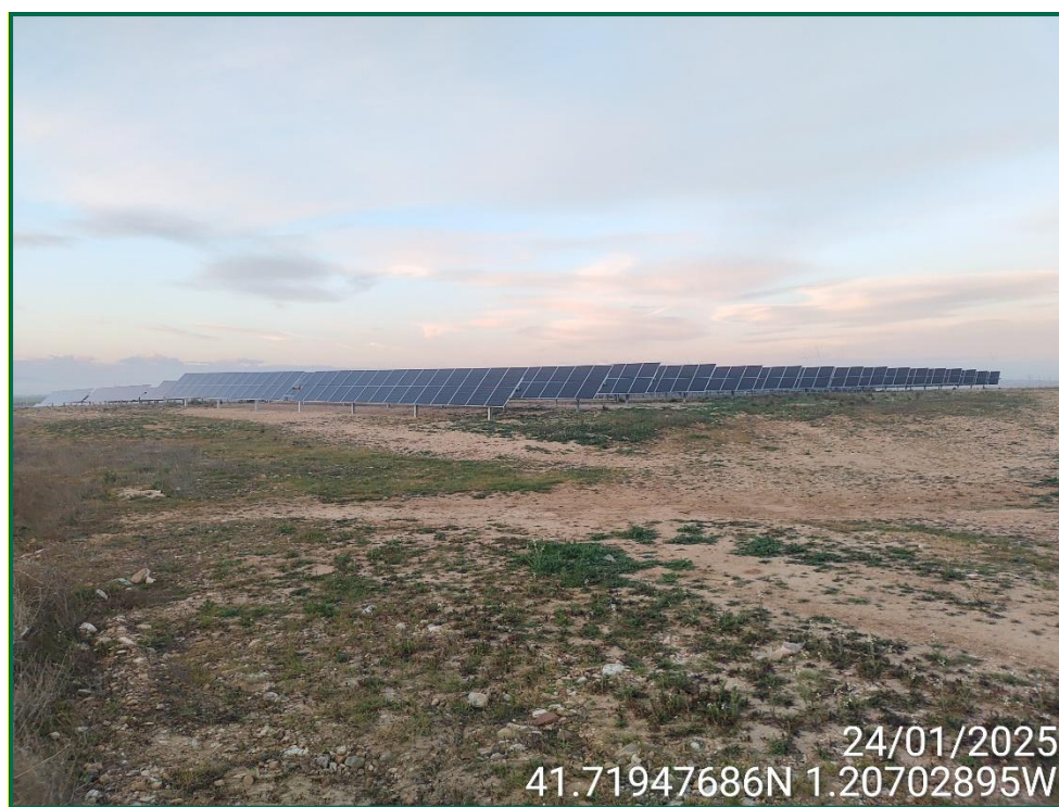
Fotografía 9. Superficie de la obra.
