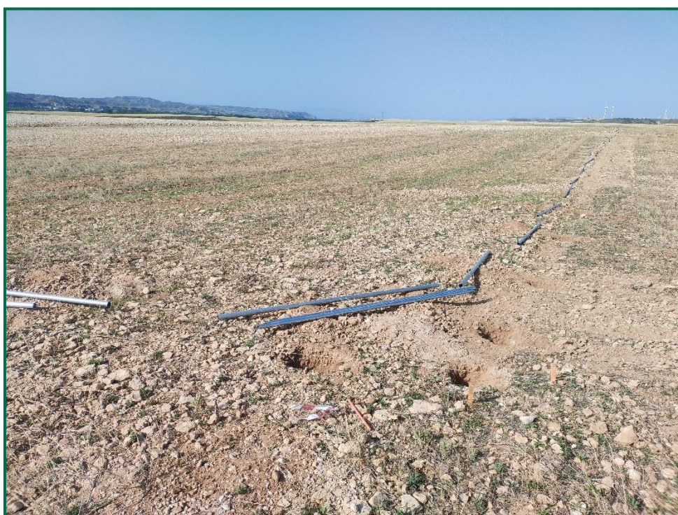
Fotografía 3. Colocación de postes para el vallado perimetral.
