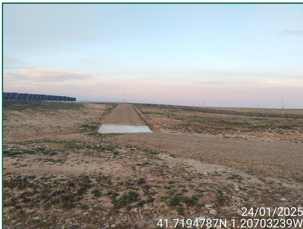
Fotografía 8. Habilitación de viales y cunetas.
