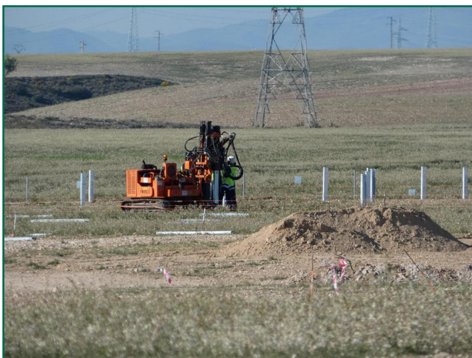
Fotografía 11. Hincas sobre el terreno.
