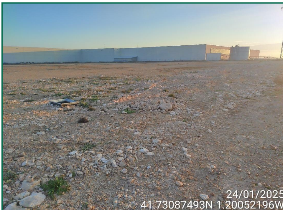
Fotografía 32. Línea de evacuación cubierta.
