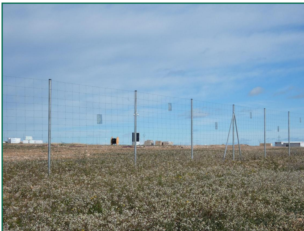
Fotografía 14. Placas anticolisión y vallado perimetral.
