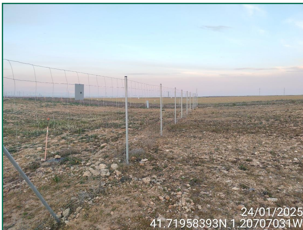
Fotografía 5. Vallado perimetral actualmente.
