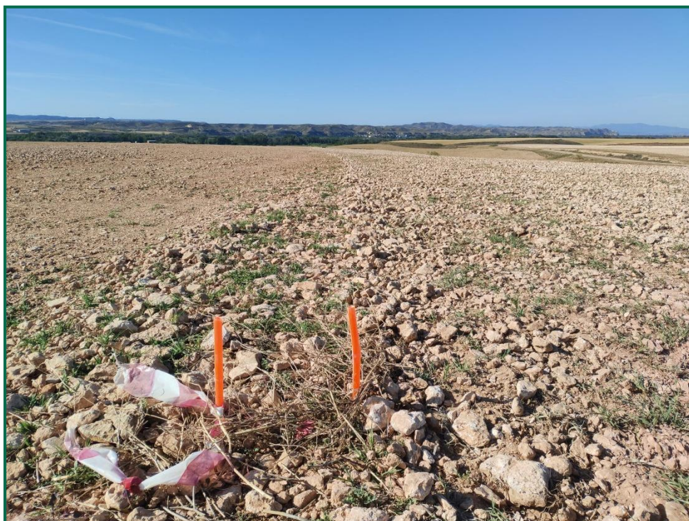
Fotografía 2. Jalonamiento previo mediante estacas.
