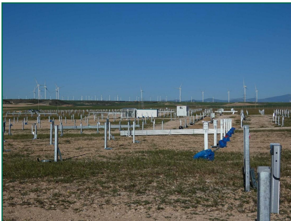
Fotografía 10. Hincas sobre el terreno.
