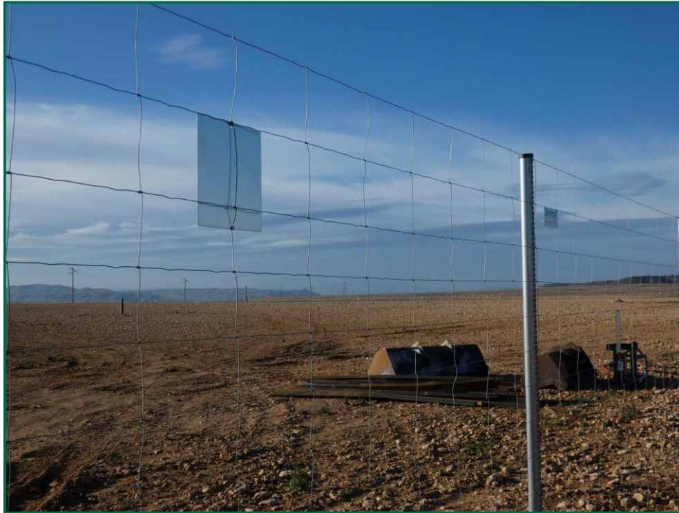
Fotografía 14. Placas anticollisión y vallado perimetral.
