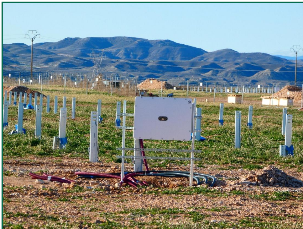
Fotografía 9. Hincas sobre el terreno.
