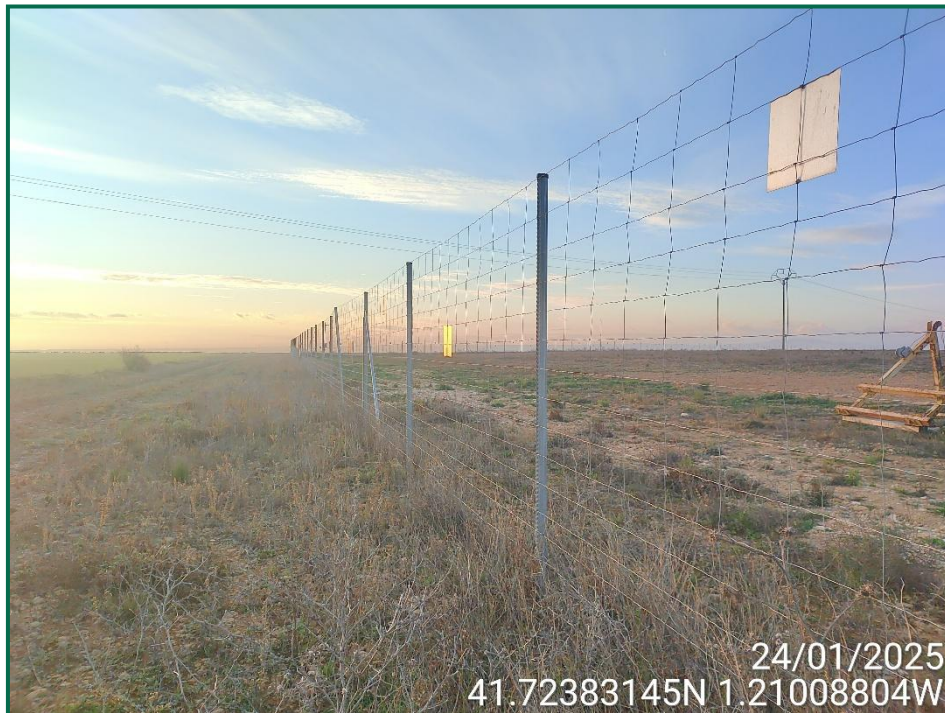
Fotografía 4. Vallado perimetral actualmente.
