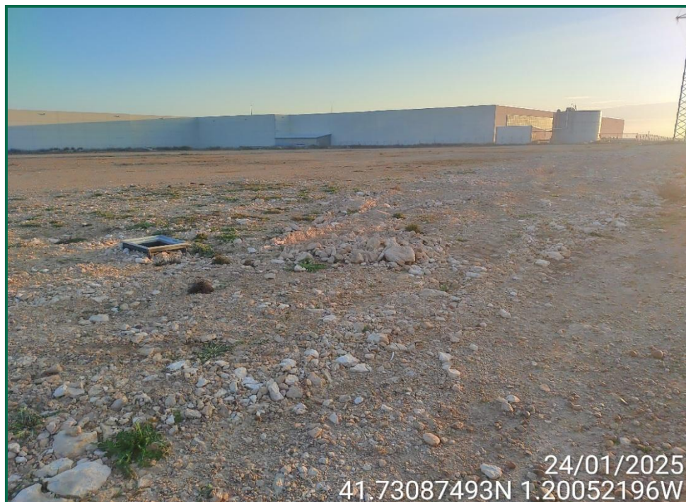
Fotografía 33. Línea de evacuación cubierta.
