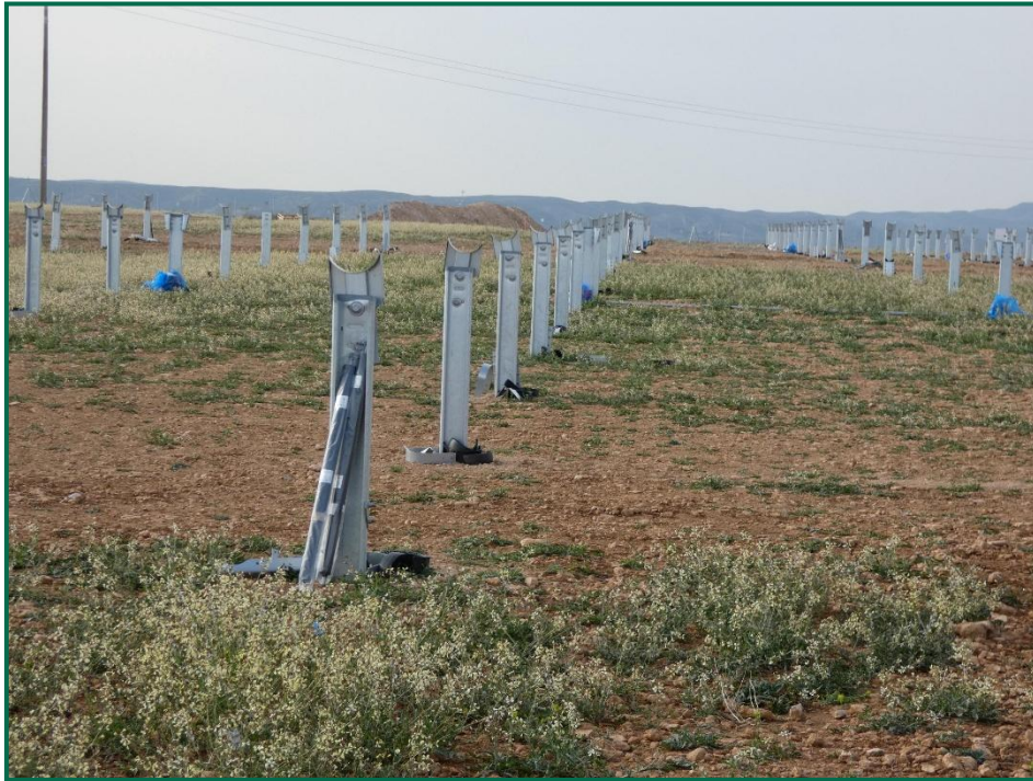
Fotografía 8. Hincas sobre el terreno.
