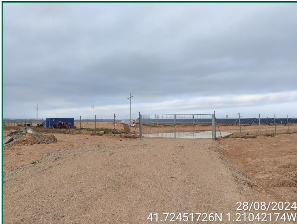
Fotografía 6. Exterior de la obra.
