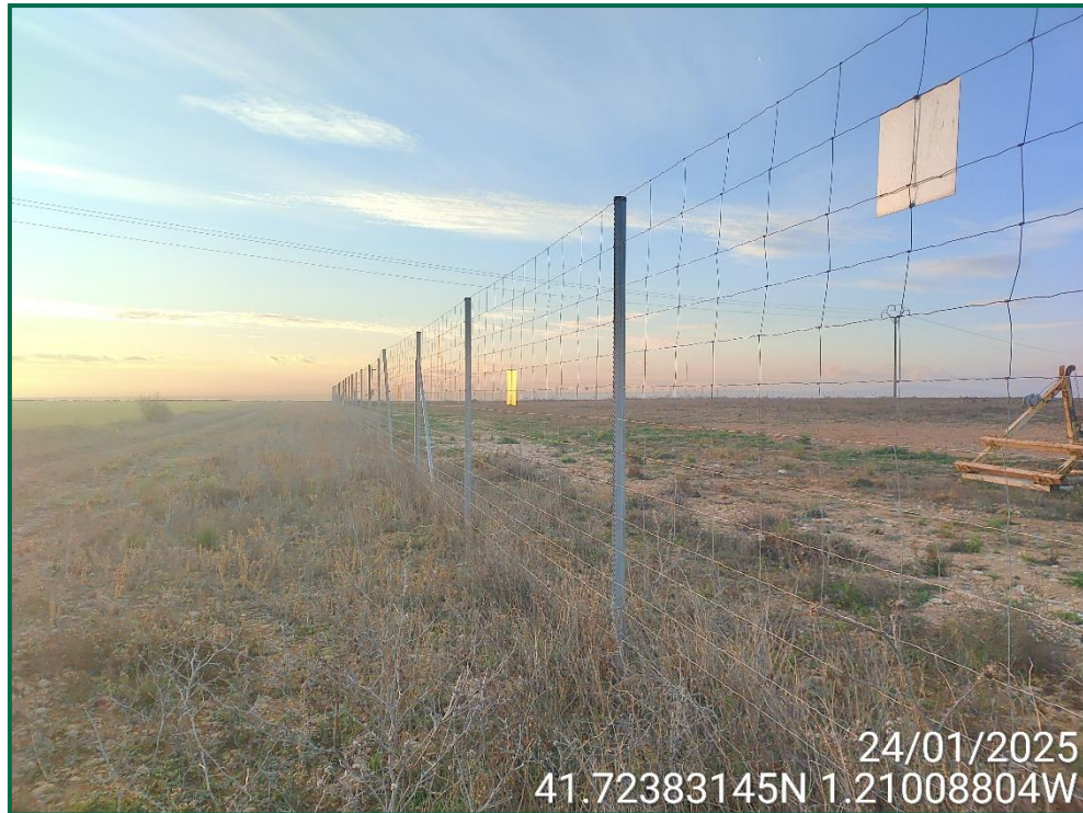
Fotografía 12. Placas anticolidión y vallado perimetral.
