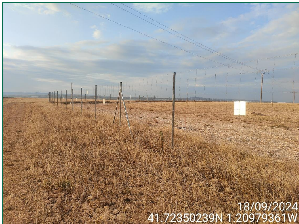
Fotografía 13. Placas anticolidión y vallado perimetral.
