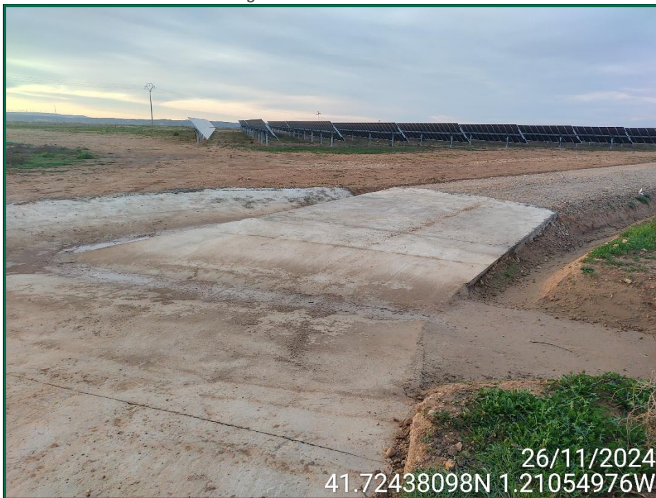
Fotografía 7. Superficie de la obra actualmente, viales.
