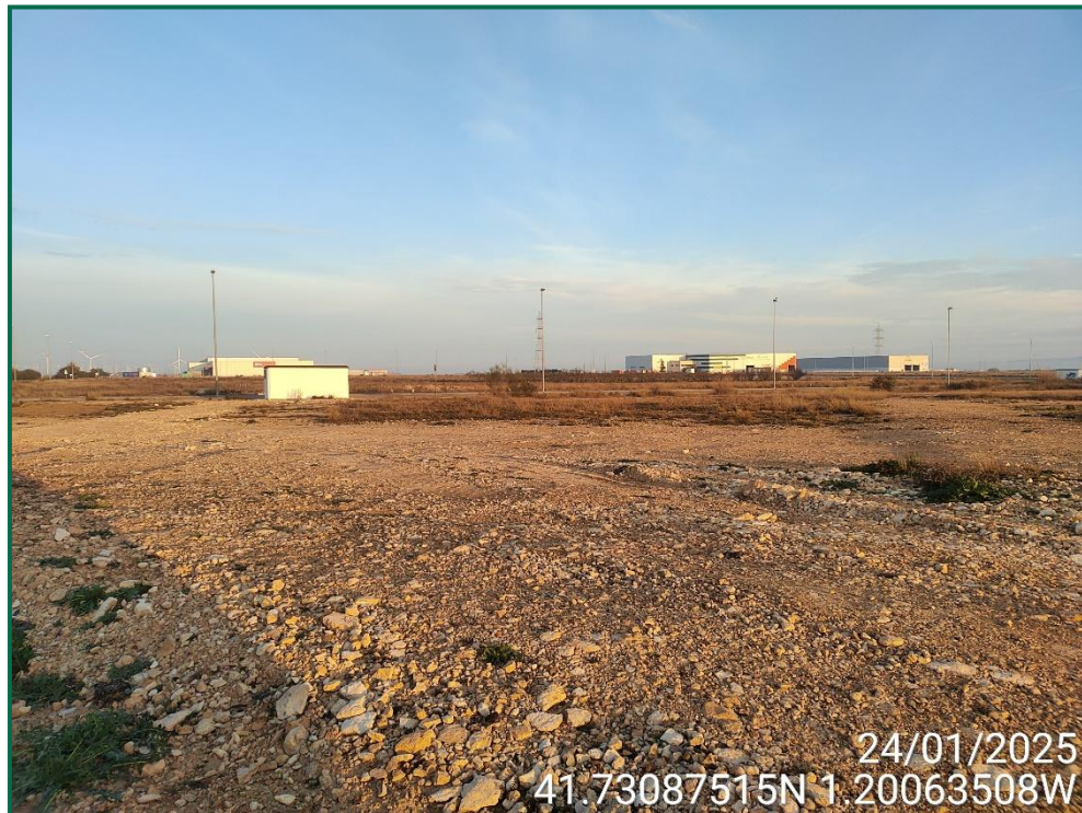
Fotografía 32. Final de la línea de evacuación.
