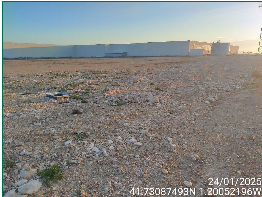
Fotografía 10. Línea de evacuación tapada.
