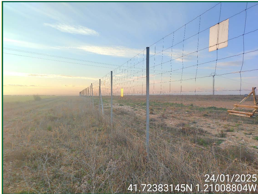
Fotografía 6. Vallado perimetral y placas anticollisión.
