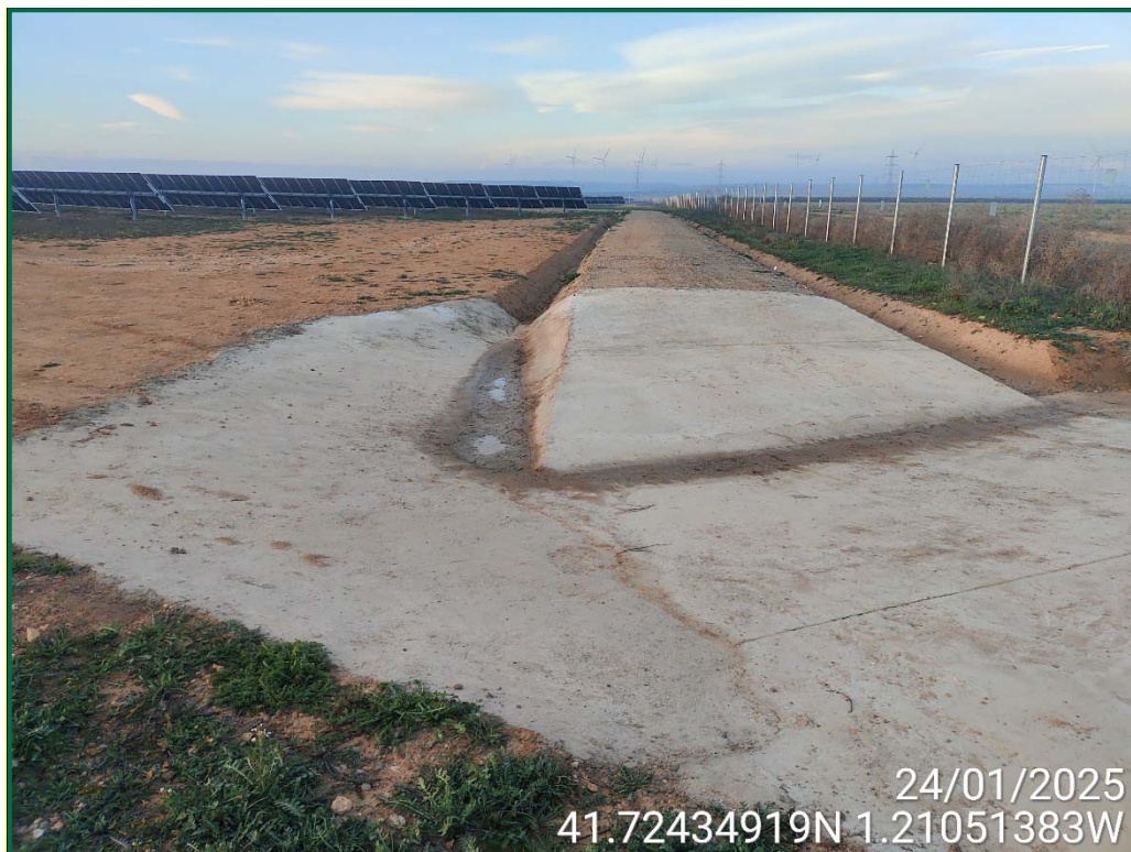
Fotografía 3. Habilitación de viales y cunetas.
