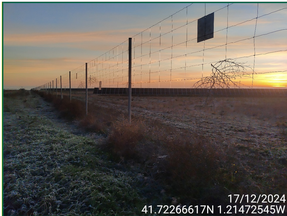
Fotografía 7. Vallado perimetral y placas anticolidión.
