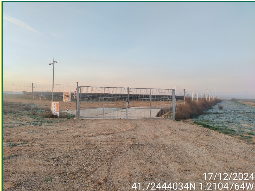
Fotografía 2. Señalización de velocidad y puerta de acceso.
