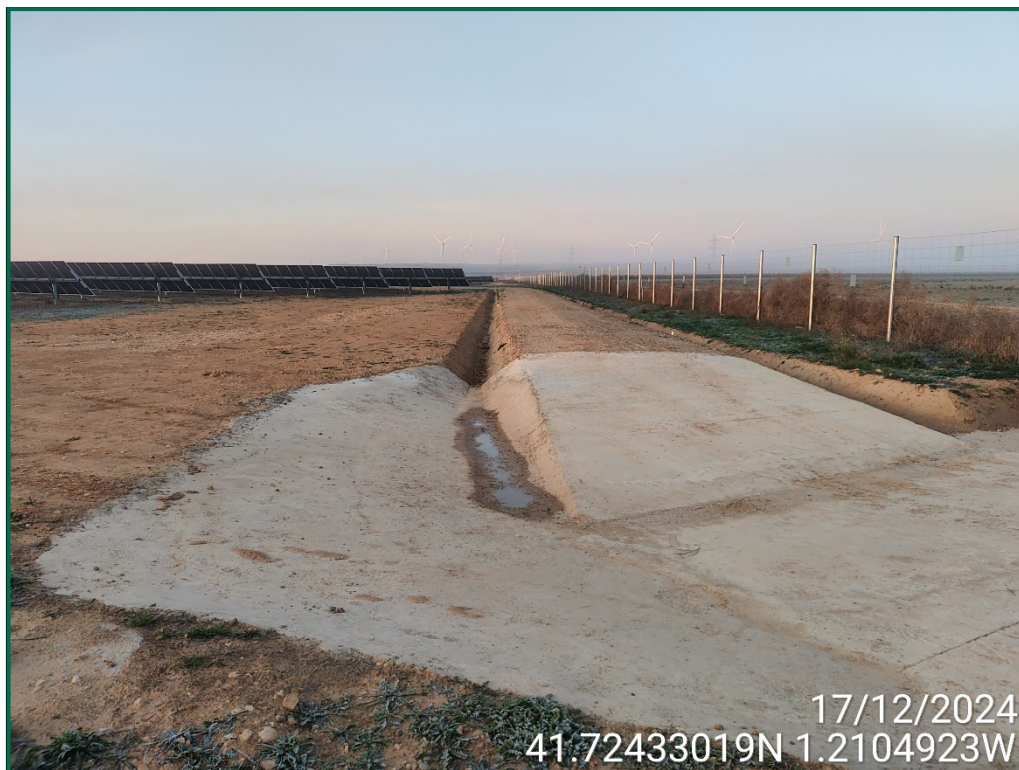
Fotografía 3. Habilitación de viales y cunetas.
