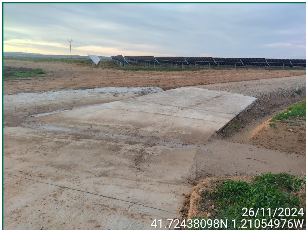
Fotografía 3. Habilitación de viales y cunetas.
