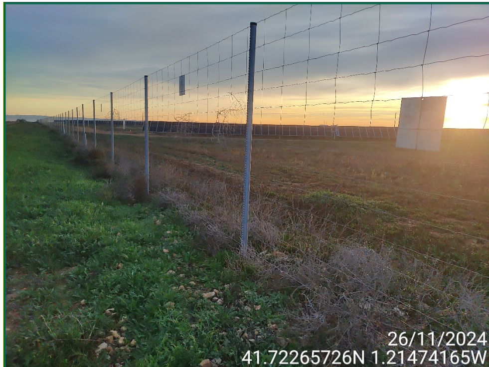
Fotografía 6. Vallado perimetral y placas anticolidión.
