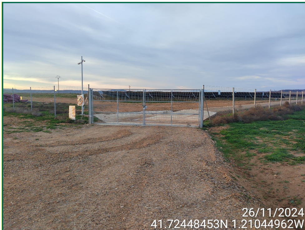
Fotografía 2. Señalización de velocidad y puerta de acceso.
