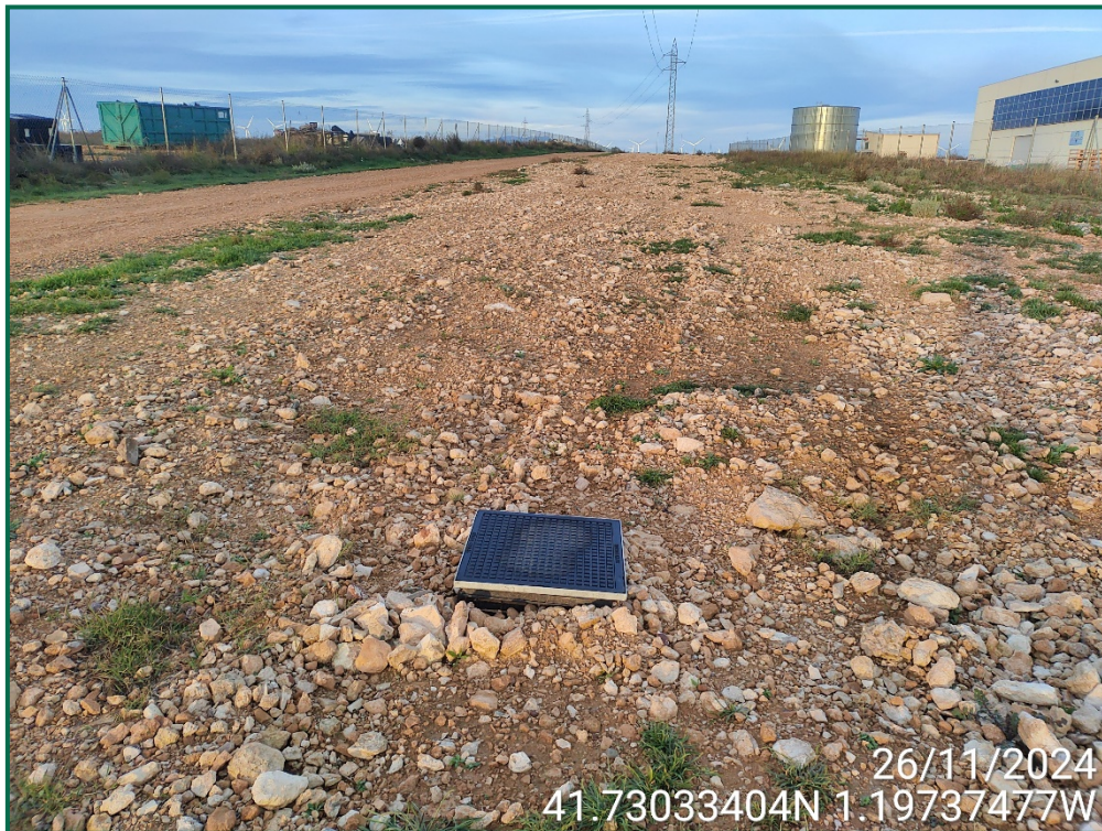
Fotografía 11. Zanjas tapadas y acopios de tierra.
