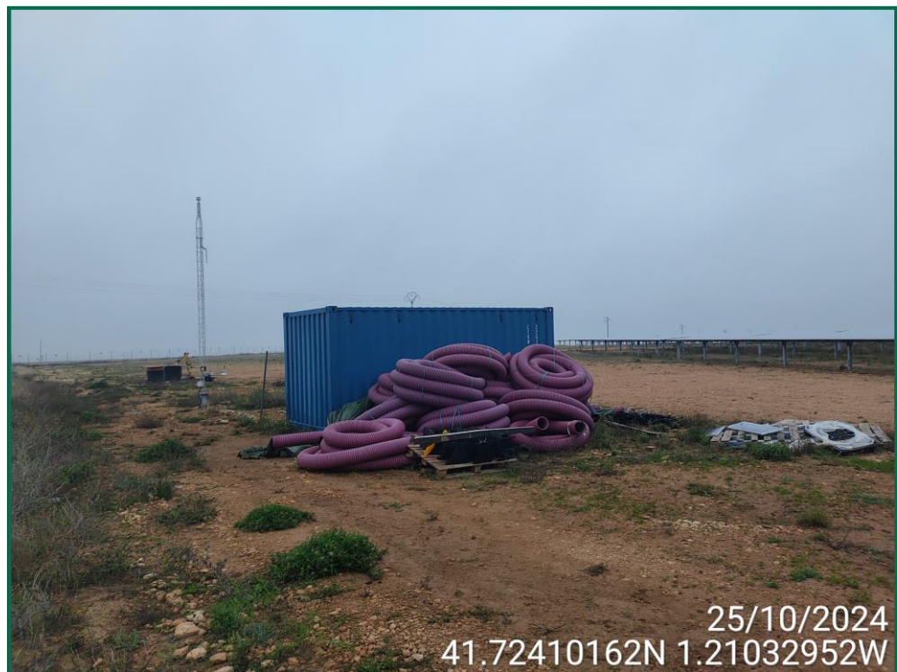
Fotografía 9. Restos de materiales.
