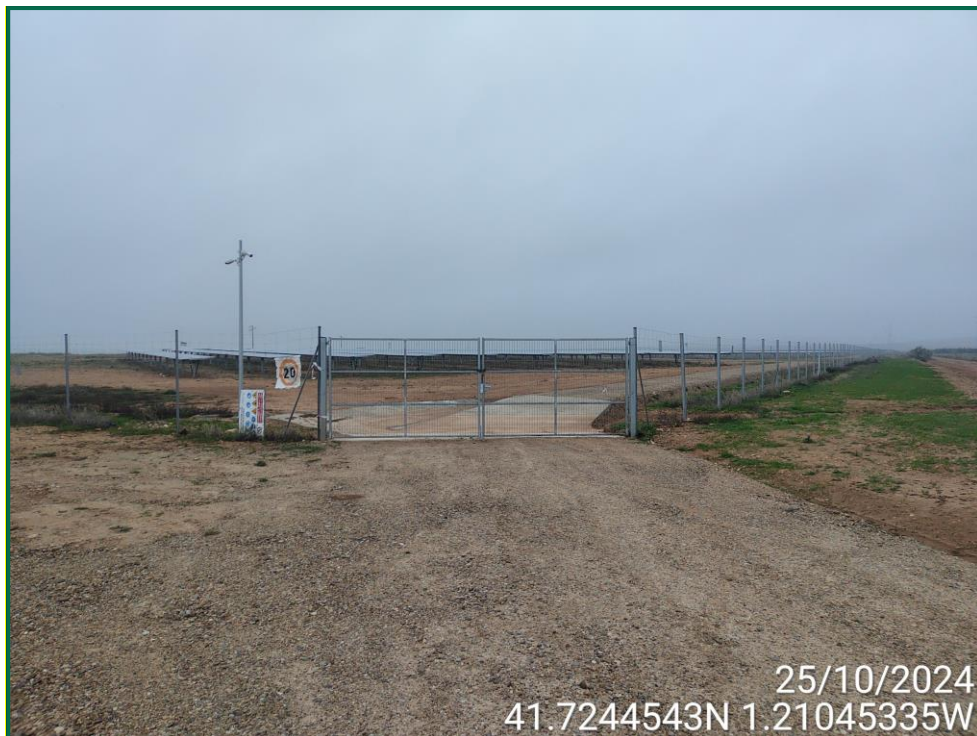
Fotografía 2. Señalización de velocidad y puerta de acceso.
