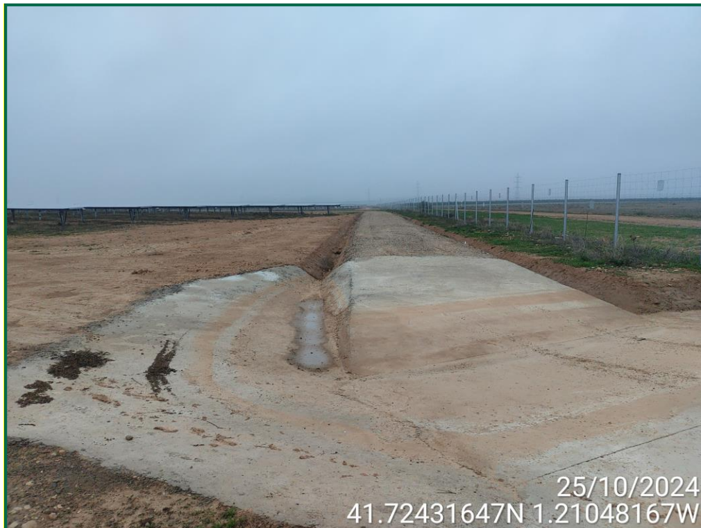
Fotografía 3. Habilitación de viales y cunetas.
