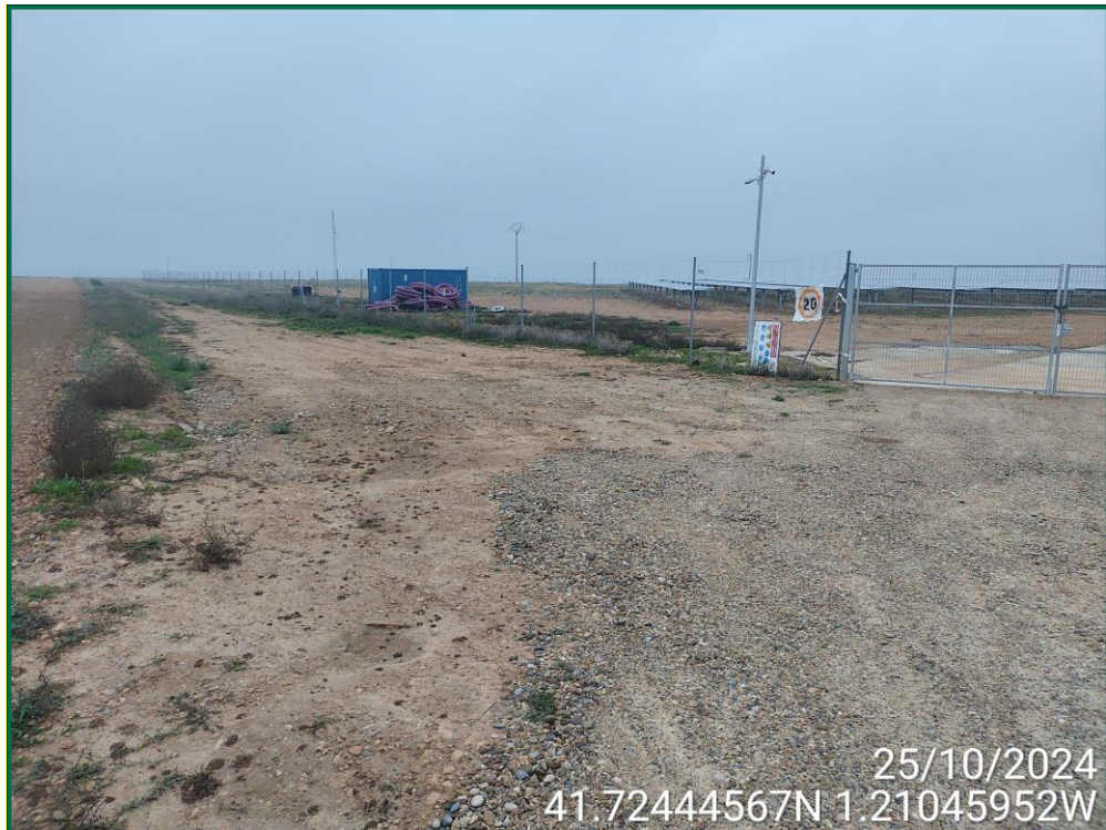
Fotografía 8. Restos de tierra y hormigón retirados.
