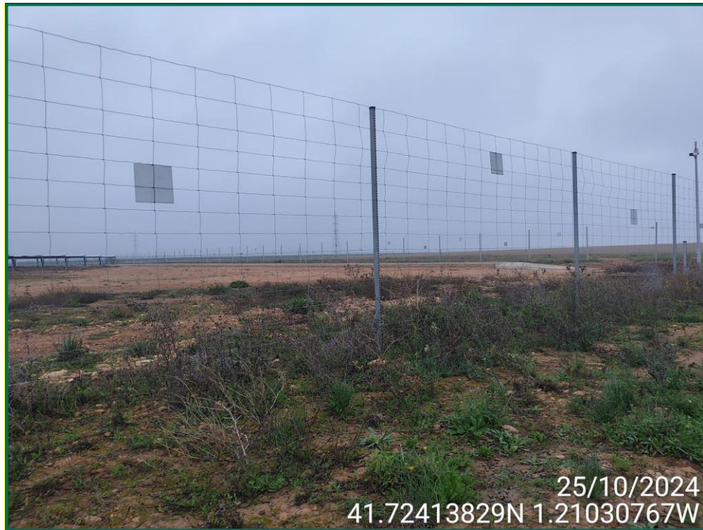
Fotografía 6. Vallado perimetral y placas anticolidión.
