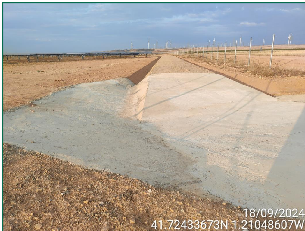
Fotografía 3. Habilitación de viales y cunetas.
