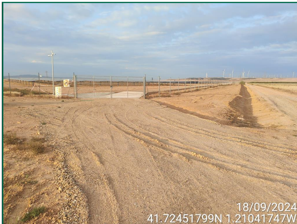
Fotografía 2. Señalización de velocidad y puerta de acceso.
