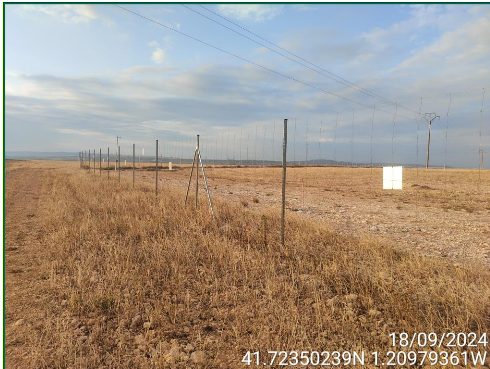
Fotografía 8. Vallado perimetral y placas anticollisión.
