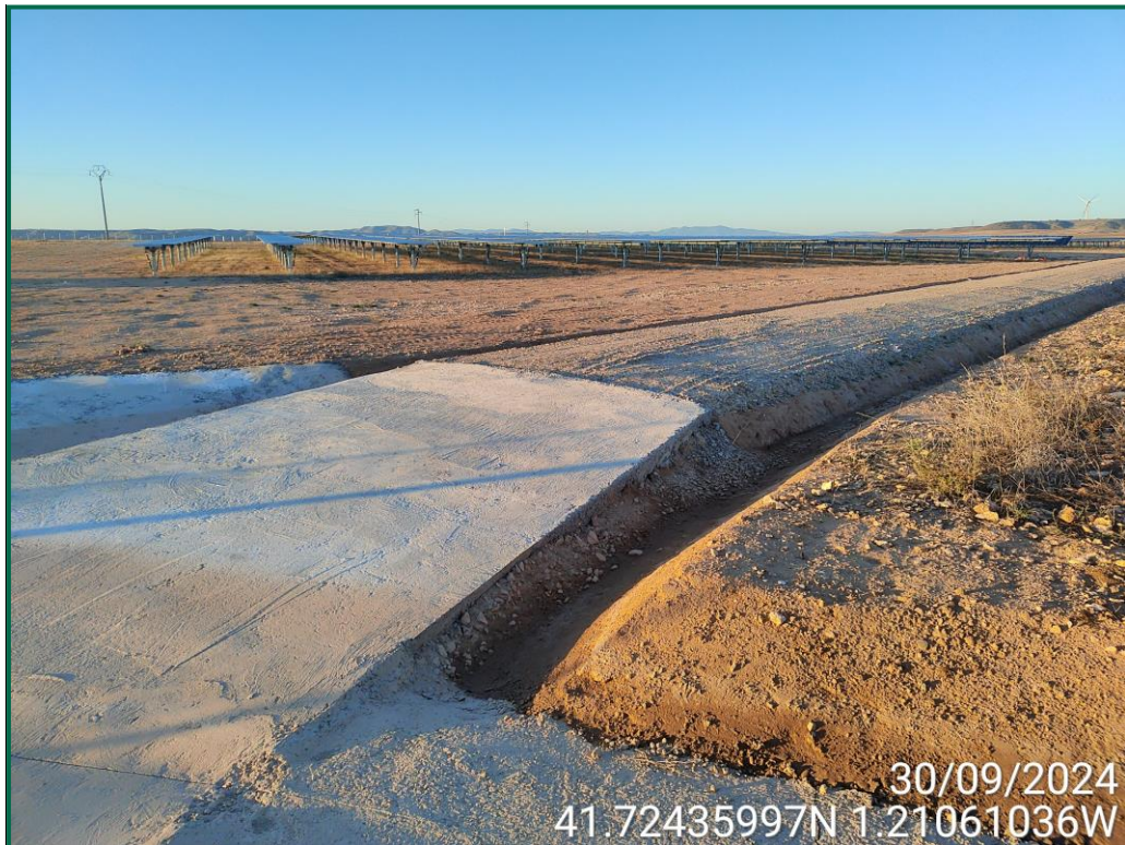
Fotografía 4. Habilitación de viales y cunetas.
