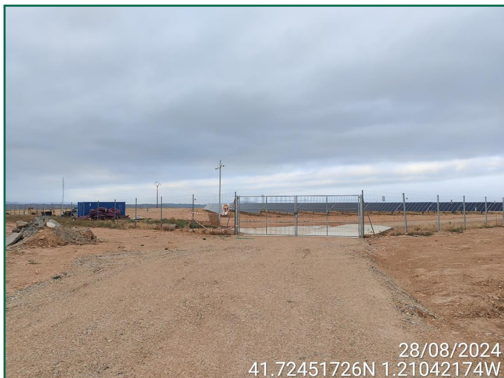
Fotografía 2. Señalización de velocidad y puerta de acceso.
