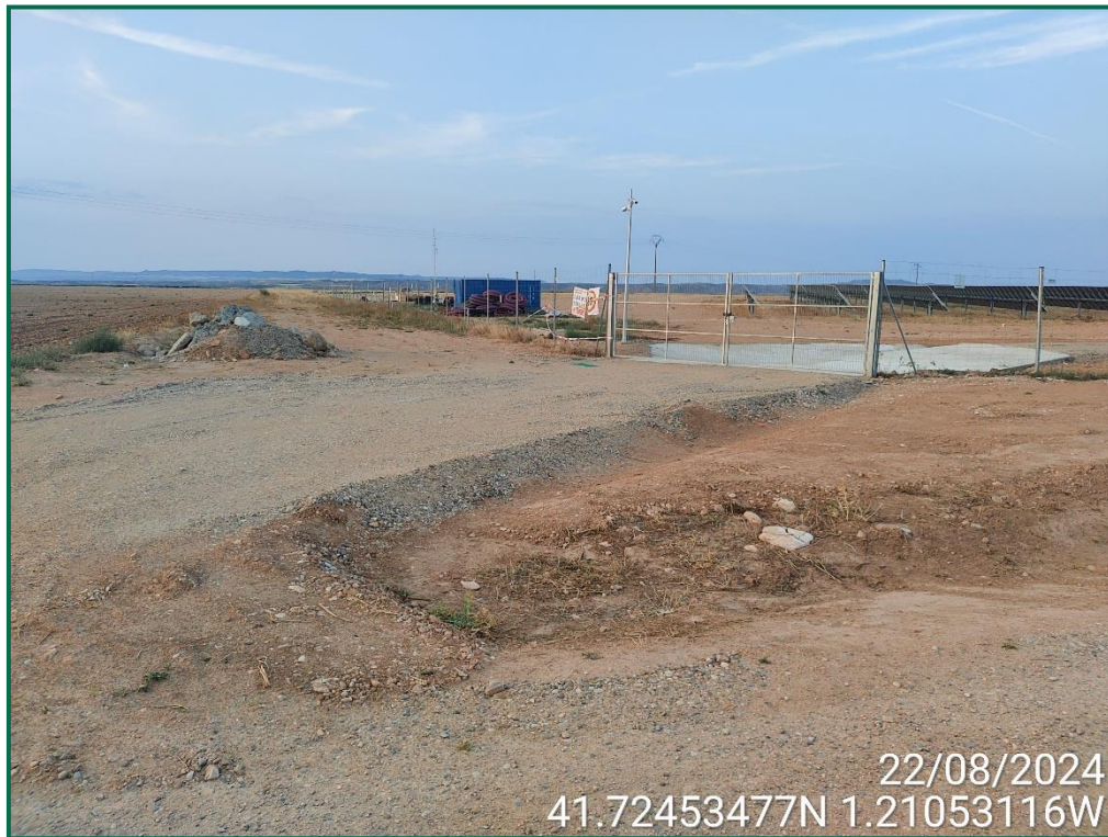
Fotografía 4. Habilitación de viales.
