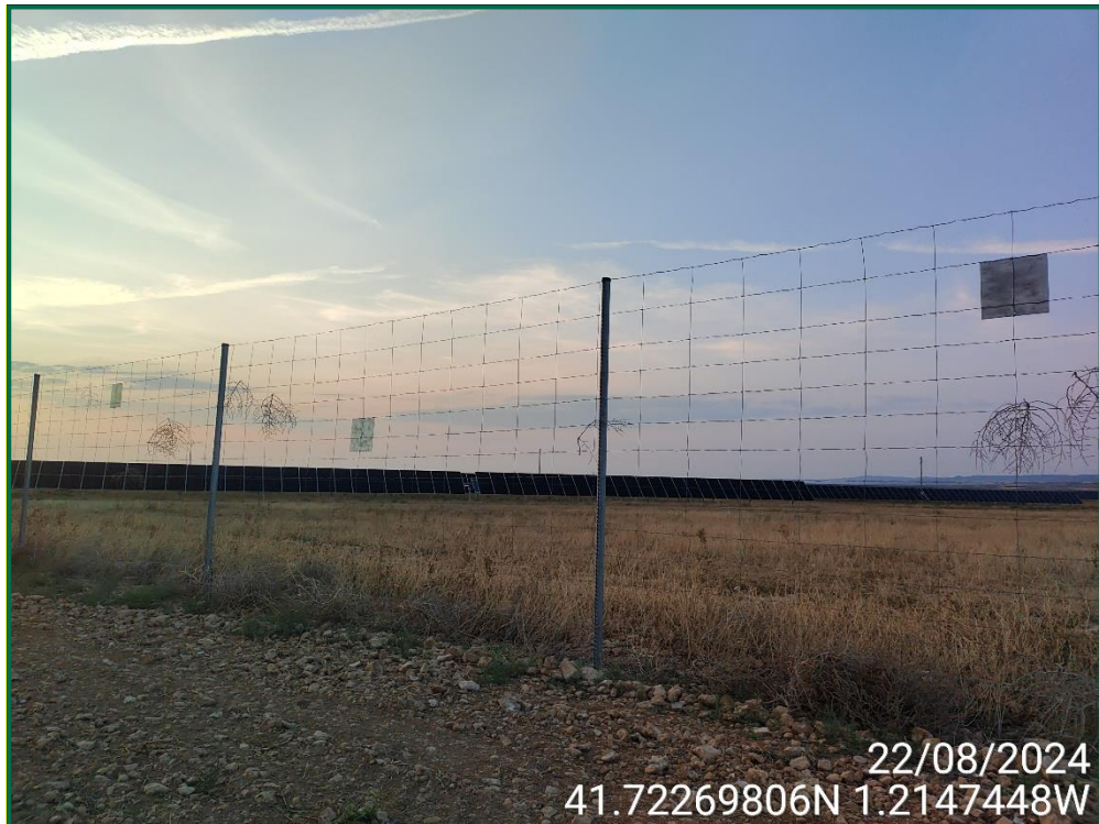
Fotografía 8. Vallado perimetral y placas anticollisión.
