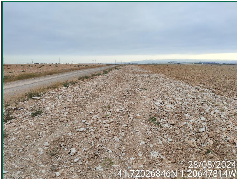
Fotografía 12. Zanjas tapadas.
