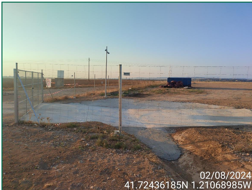
Fotografía 5. Habilitación de viales y cunetas.
