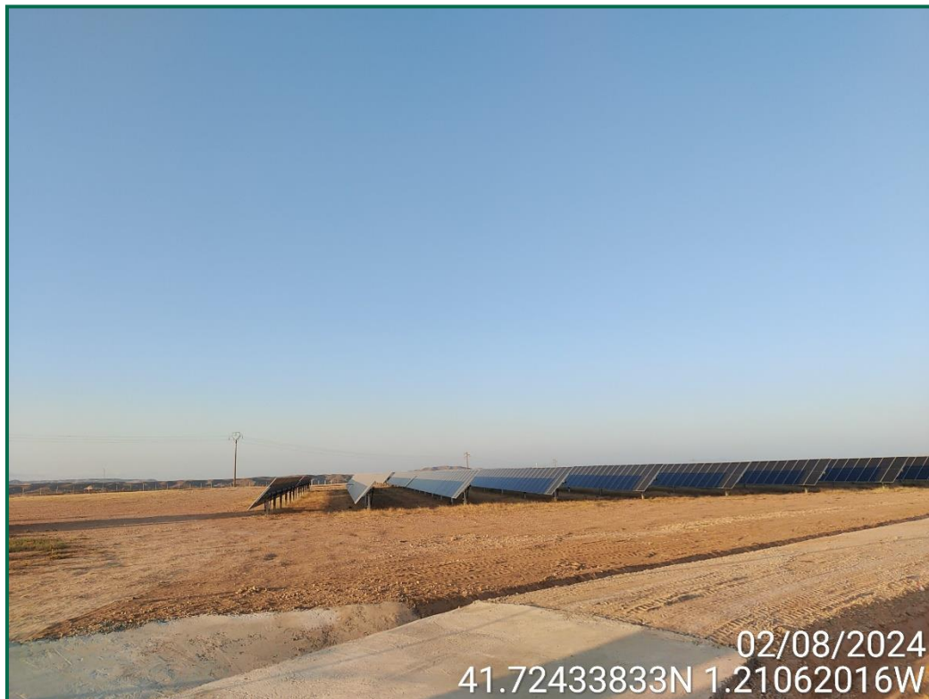
Fotografía 3. Superficie de la obra.
