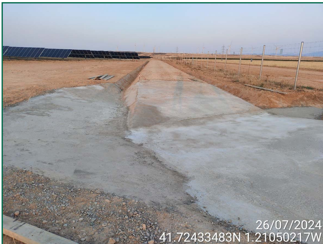
Fotografía 7. Habilitación de viales.
