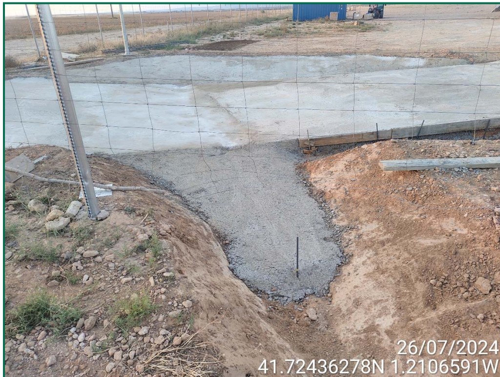
Fotografía 8. Habilitación de viales y cunetas.
