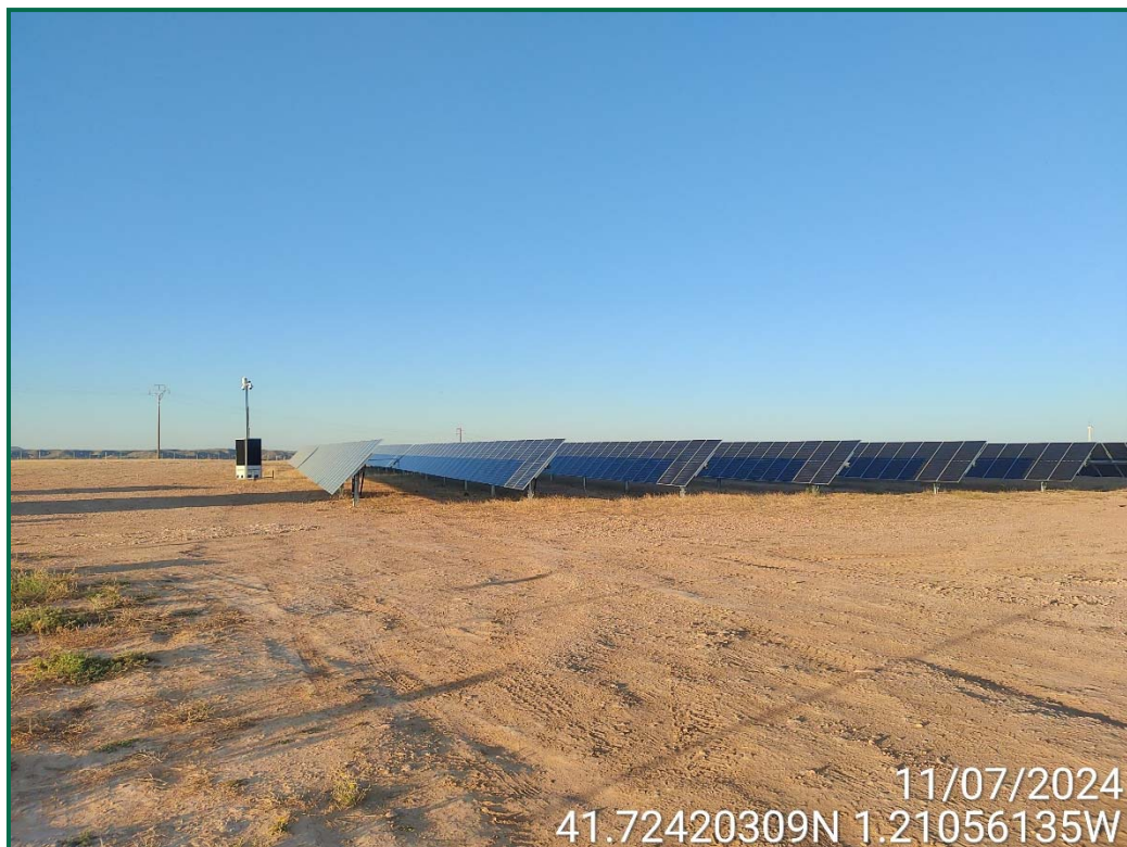
Fotografía 5. Superficie de la obra.
