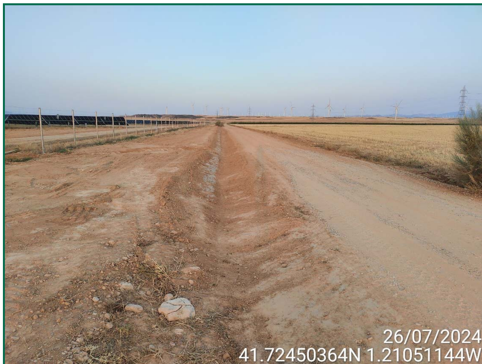
Fotografía 10. Franja vegetal y cunetas.
