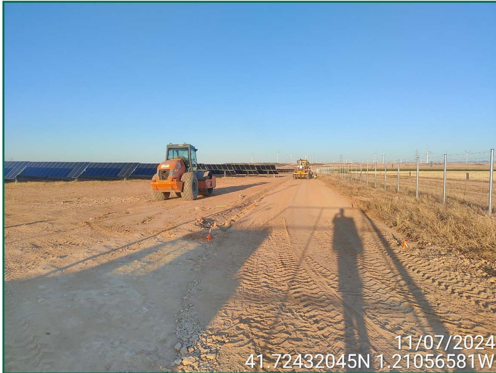
Fotografía 6. Habilitación de viales.
