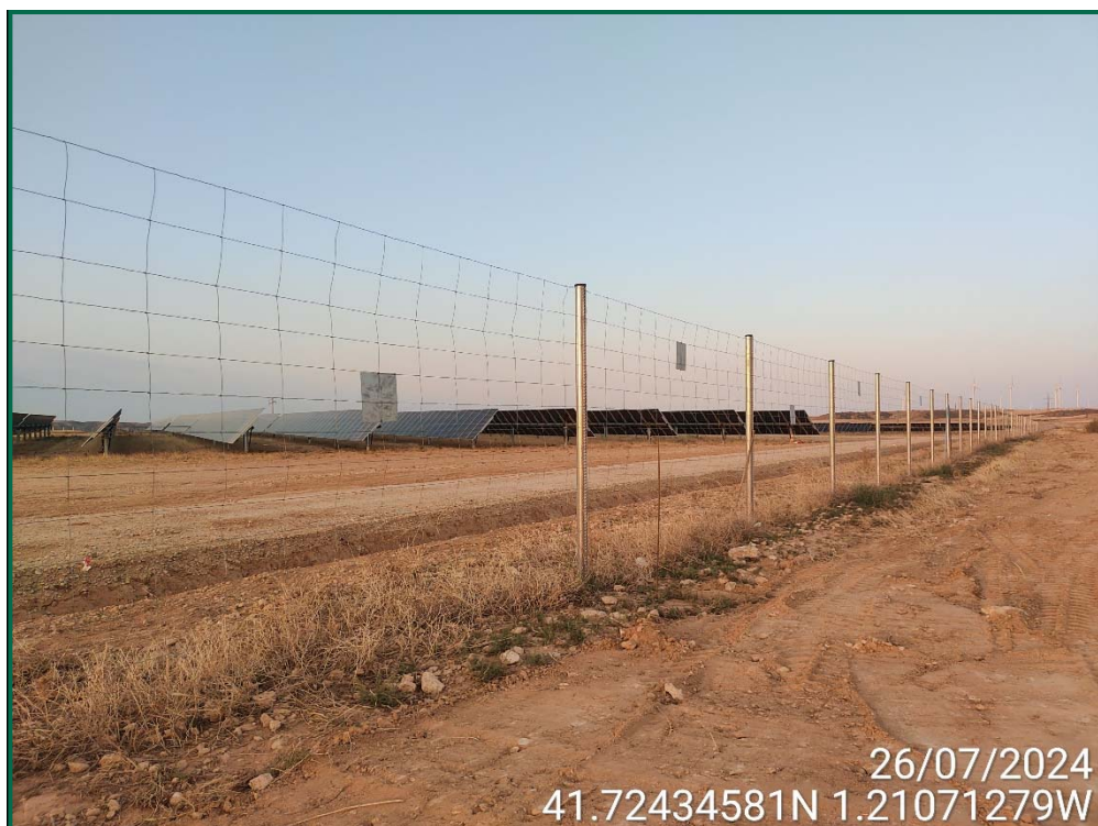
Fotografía 11. Vallado perimetral y placas anticolidión.
