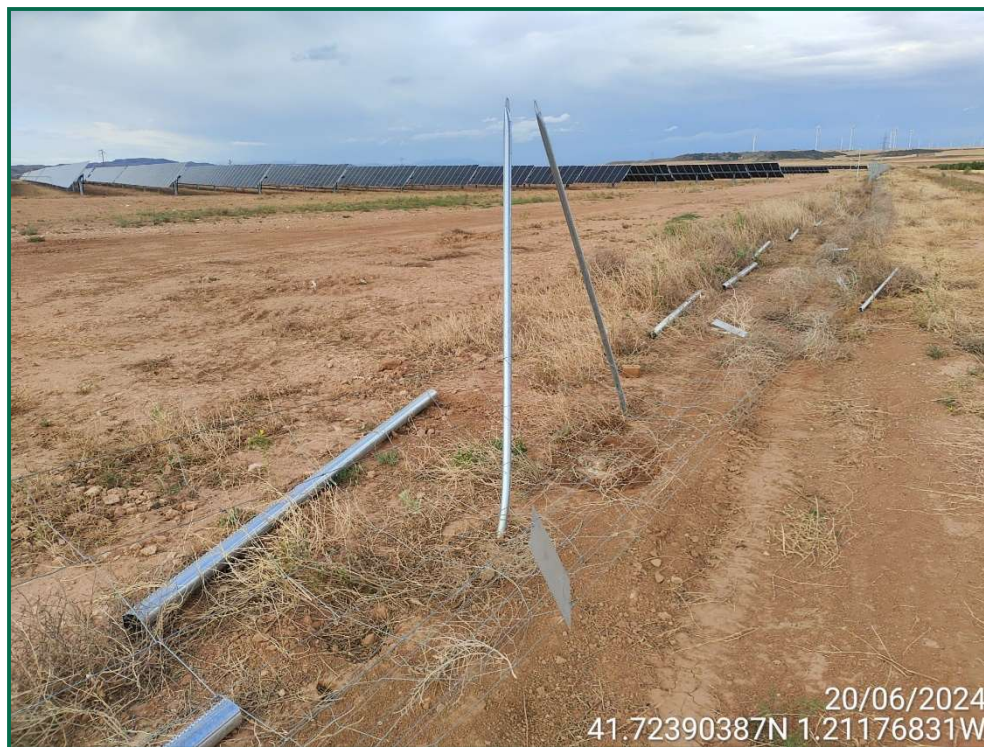
Fotografía 13. Colocación de nuevos postes.
