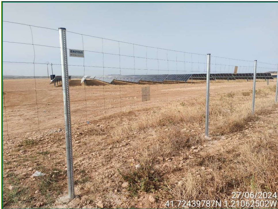
Fotografía 10. Vallado perimetral y placas anticollisión.
