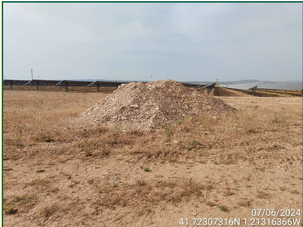
Fotografía 2. Acopio de tierra.
