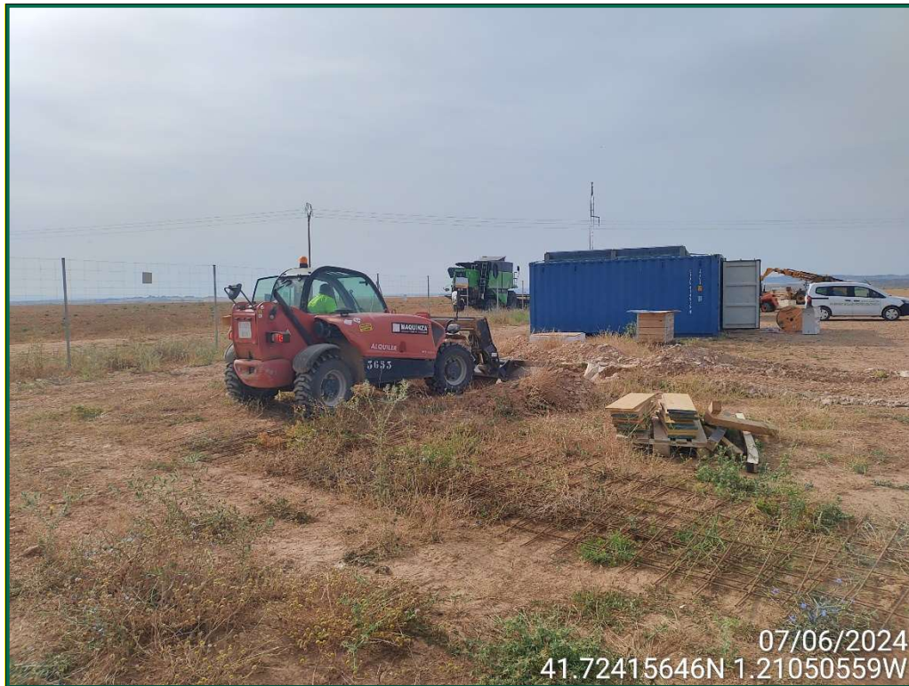
Fotografía 19. Tapado de balsa de limpieza.
