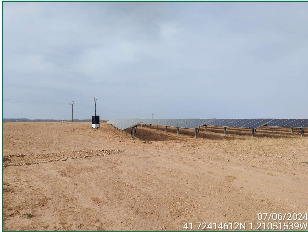
Fotografía 1. Superficie de la obra.
