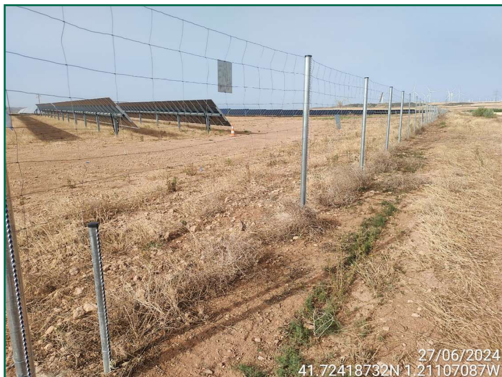
Fotografía 15. Vallado colocado con postes reforzados.
