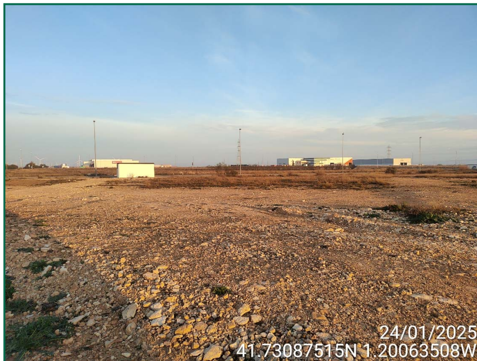
Fotografía 11. Final de la línea de evacuación.
