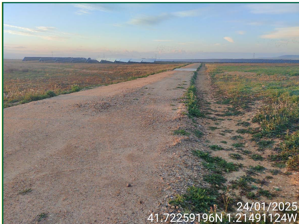
Fotografía 3. Habilitación de viales.
