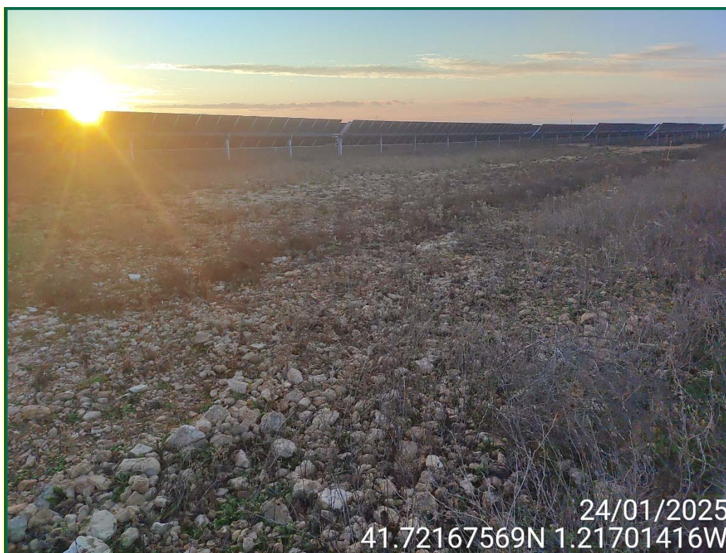
Fotografía 5. Superficie de la obra.
