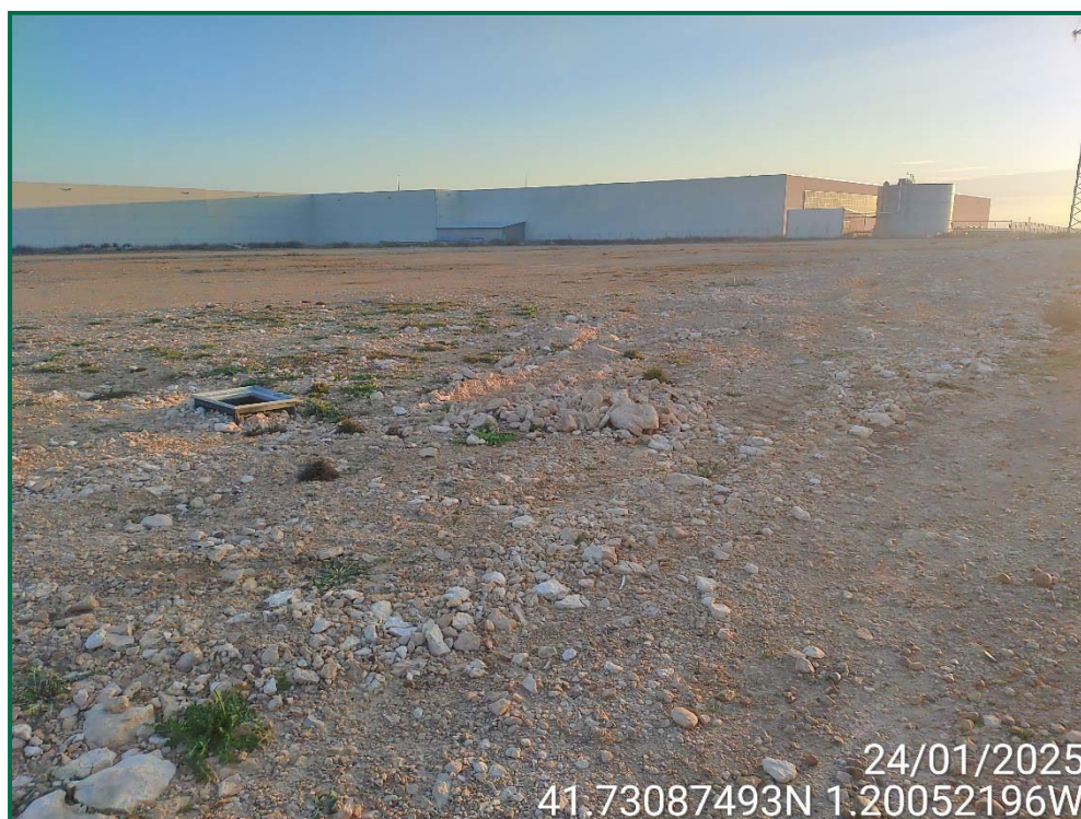
Fotografía 12. Línea de evacuación tapada.
