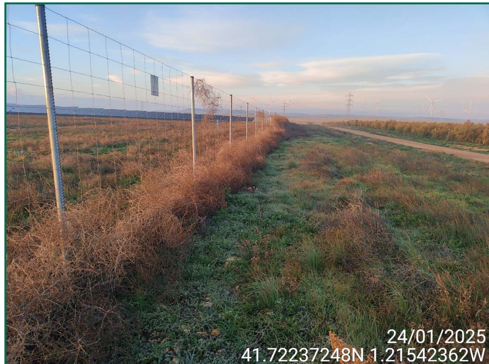
Fotografía 9. Vallado perimetral y placas anticollisión.
