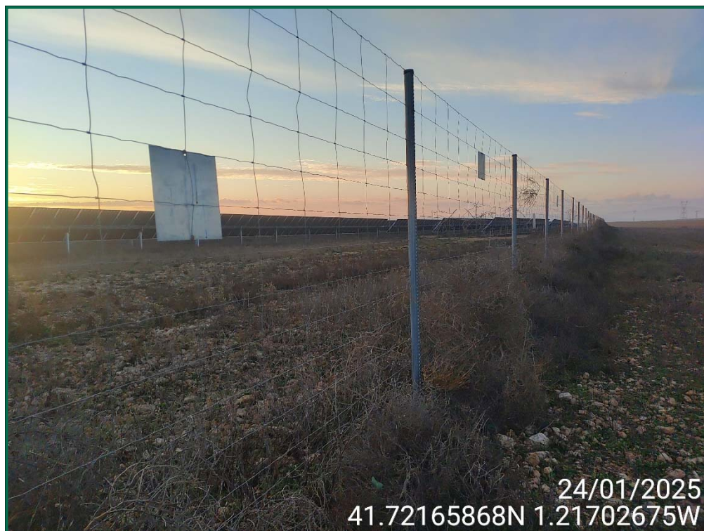
Fotografía 8. Vallado perimetral y placas anticollisión.
