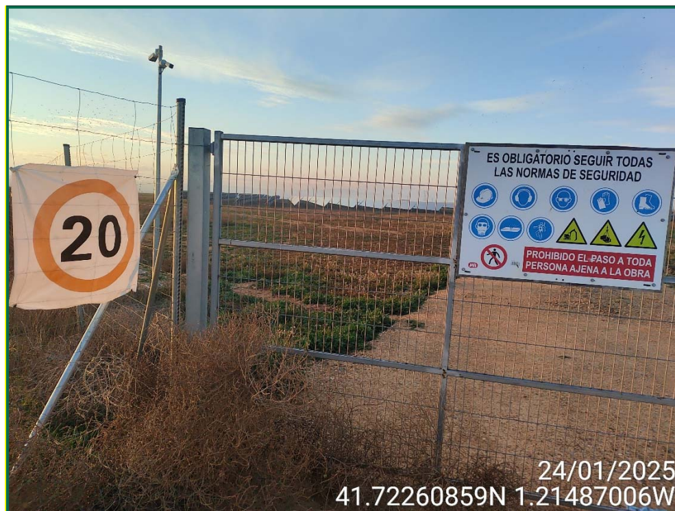
Fotografía 1. Señalización de velocidad.
