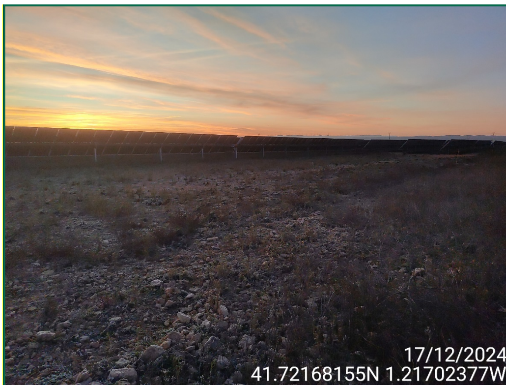
Fotografía 5. Superficie de la obra.
