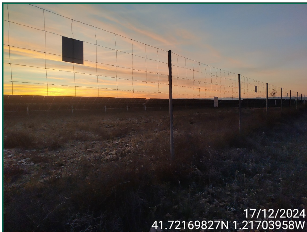
Fotografía 8. Vallado perimetral y placas anticolidión.
