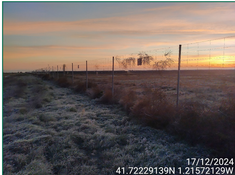
Fotografía 9. Vallado perimetral y placas anticolidión.
