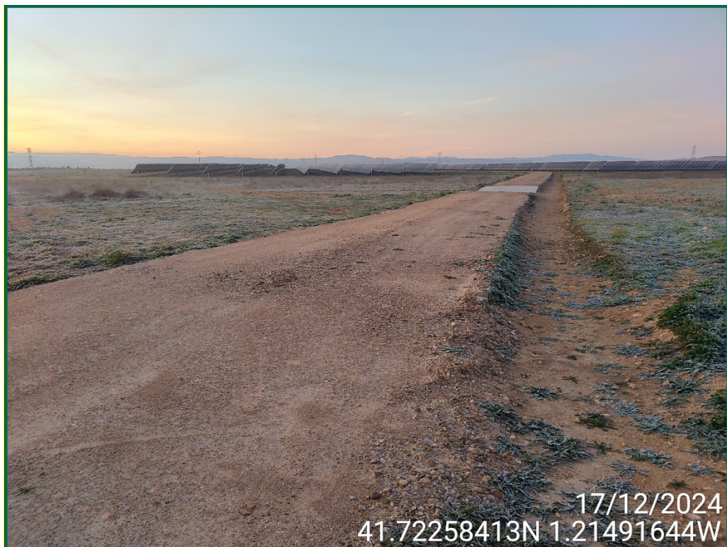
Fotografía 3. Habilitación de viales.
