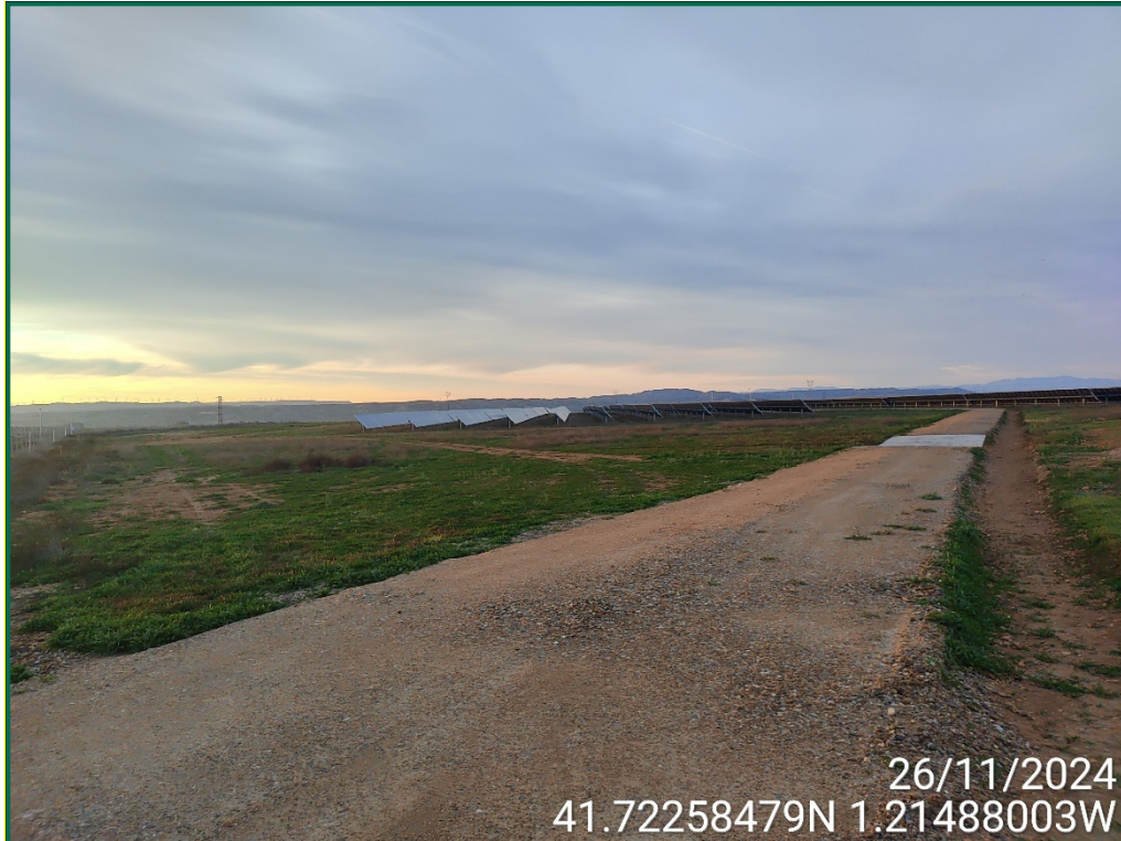
Fotografía 4. Habilitación de viales y cunetas.
