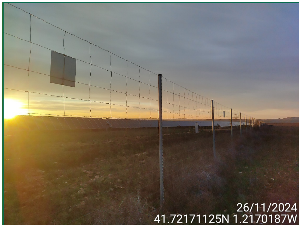
Fotografía 9. Vallado perimetral y placas anticolidión.
