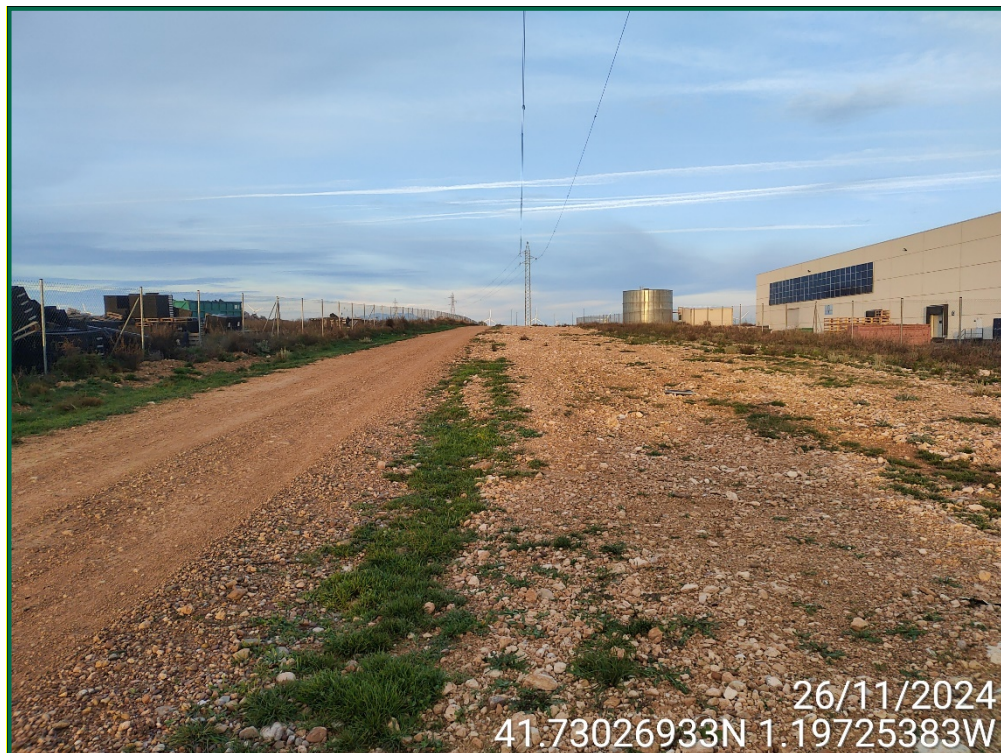
Fotografía 11. Zanjas tapadas y acopios de tierra.
