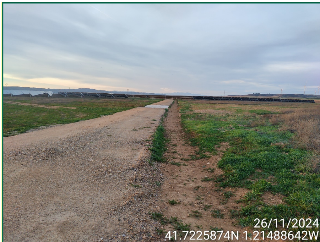
Fotografía 3. Habilitación de viales.
