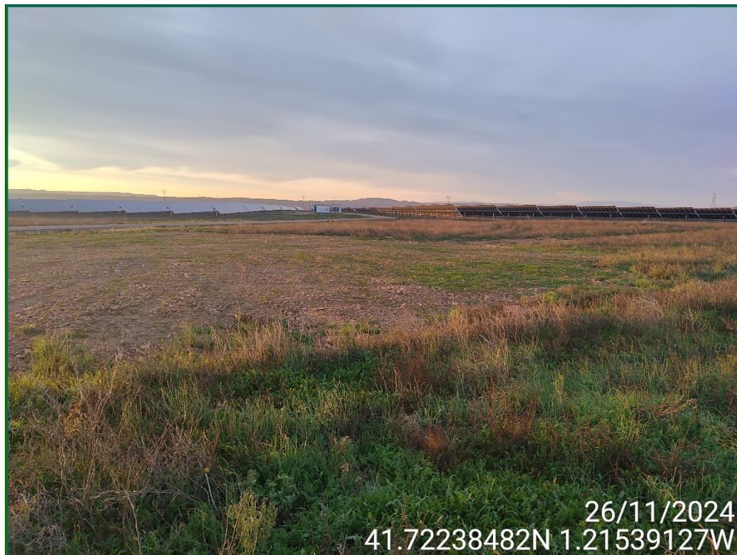
Fotografía 5. Acopios de tierra extendidos.
