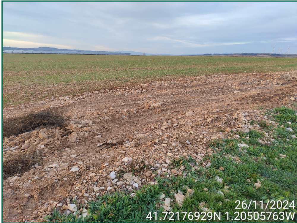
Fotografía 12. Zanjas tapadas y acopios de tierra.
