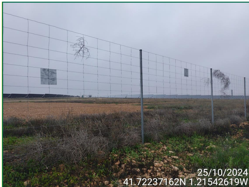
Fotografía 9. Vallado perimetral y placas anticolidión.
