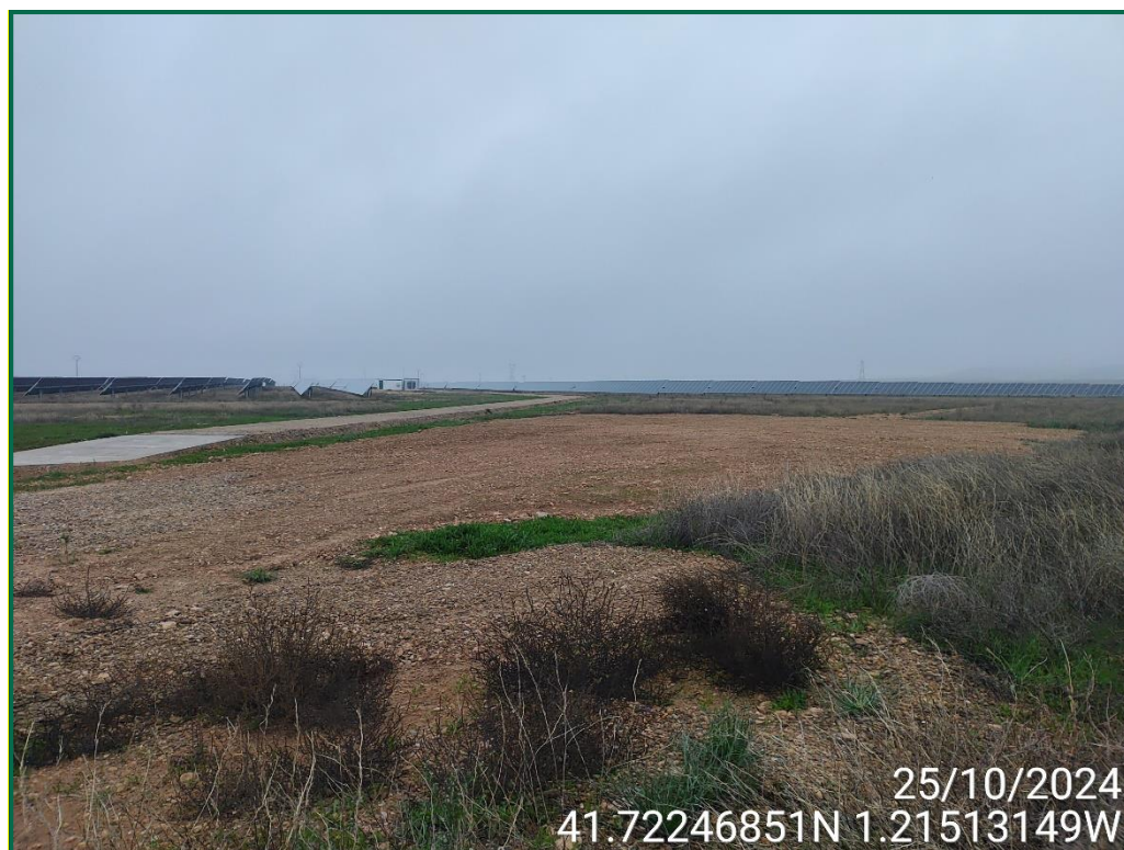
Fotografía 5. Acopios de tierra extendidos.
