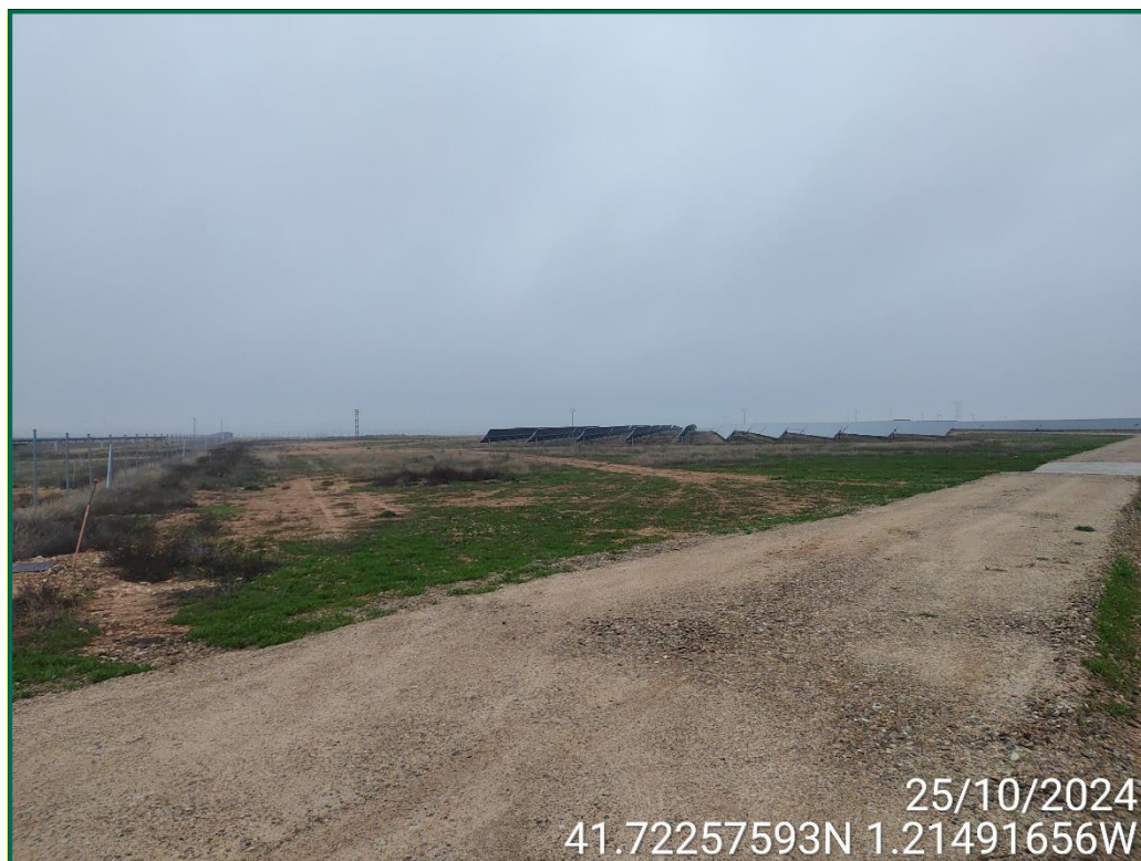
Fotografía 4. Habilitación de viales y cunetas.
