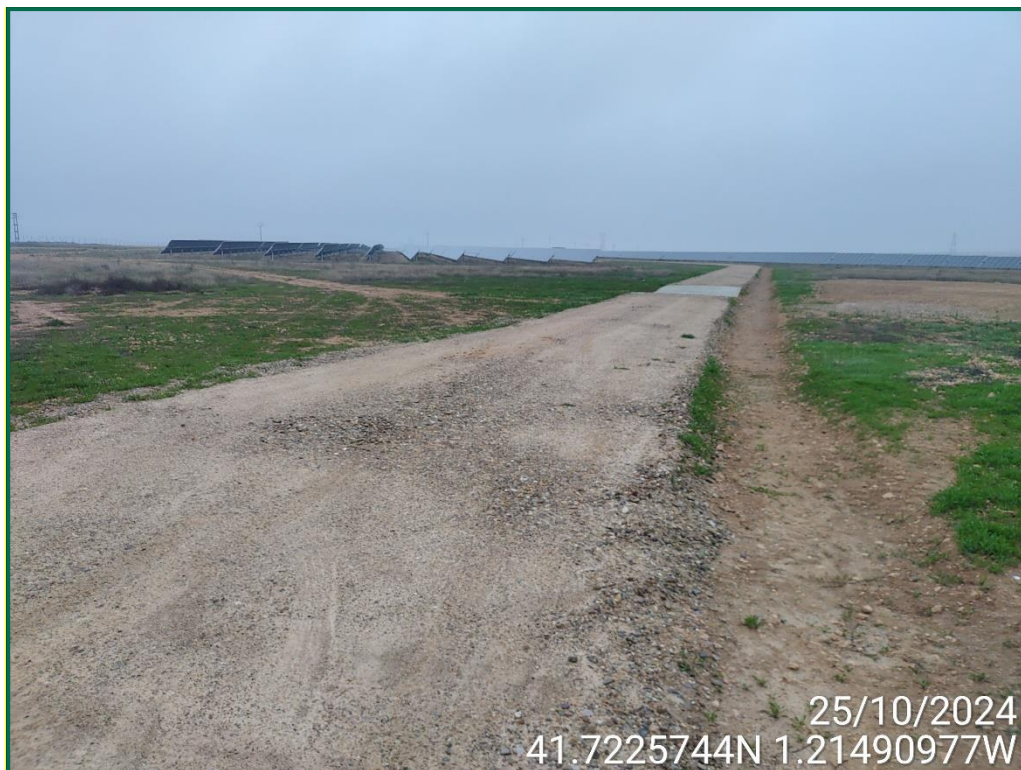
Fotografía 3. Habilitación de viales.
