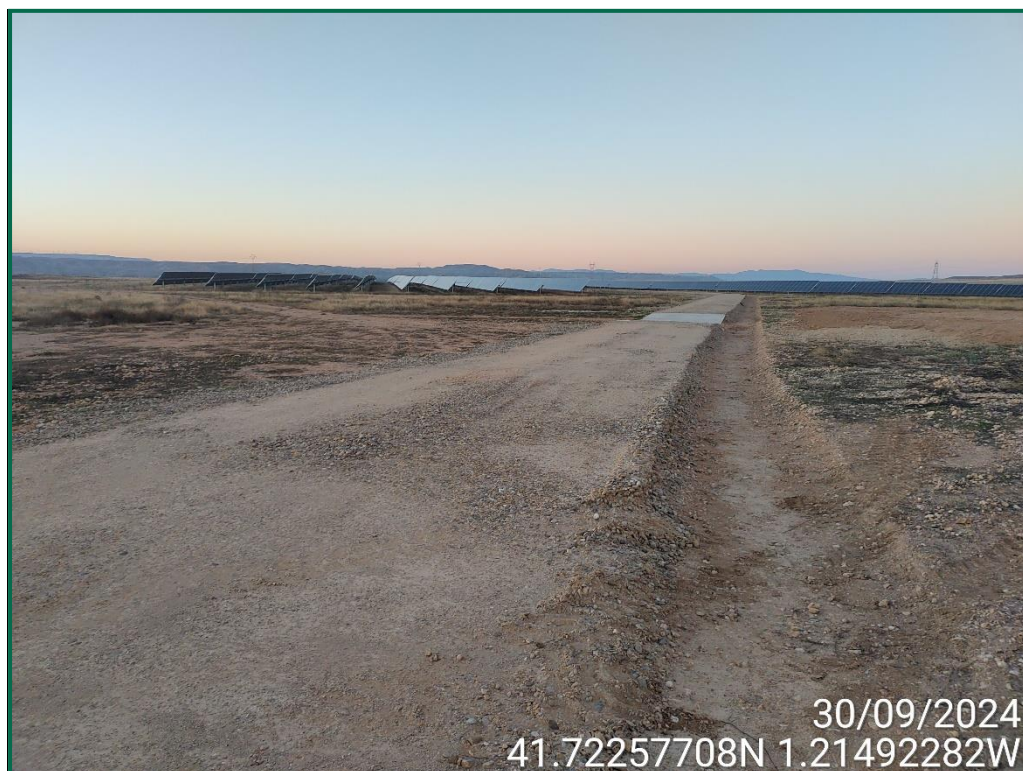
Fotografía 3. Habilitación de viales.
