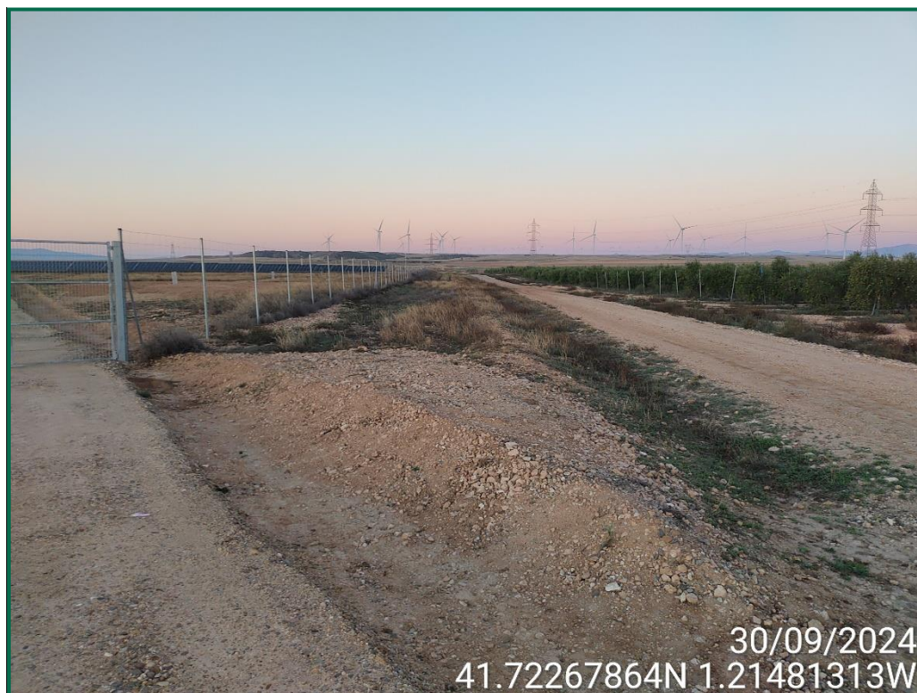
Fotografía 4. Habilitación de viales y cunetas.
