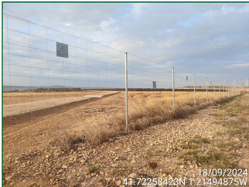
Fotografía 9. Vallado perimetral y placas anticolidión.
