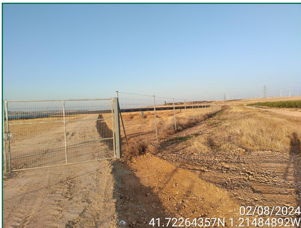
Fotografía 5. Habilitación de viales y cunetas.
