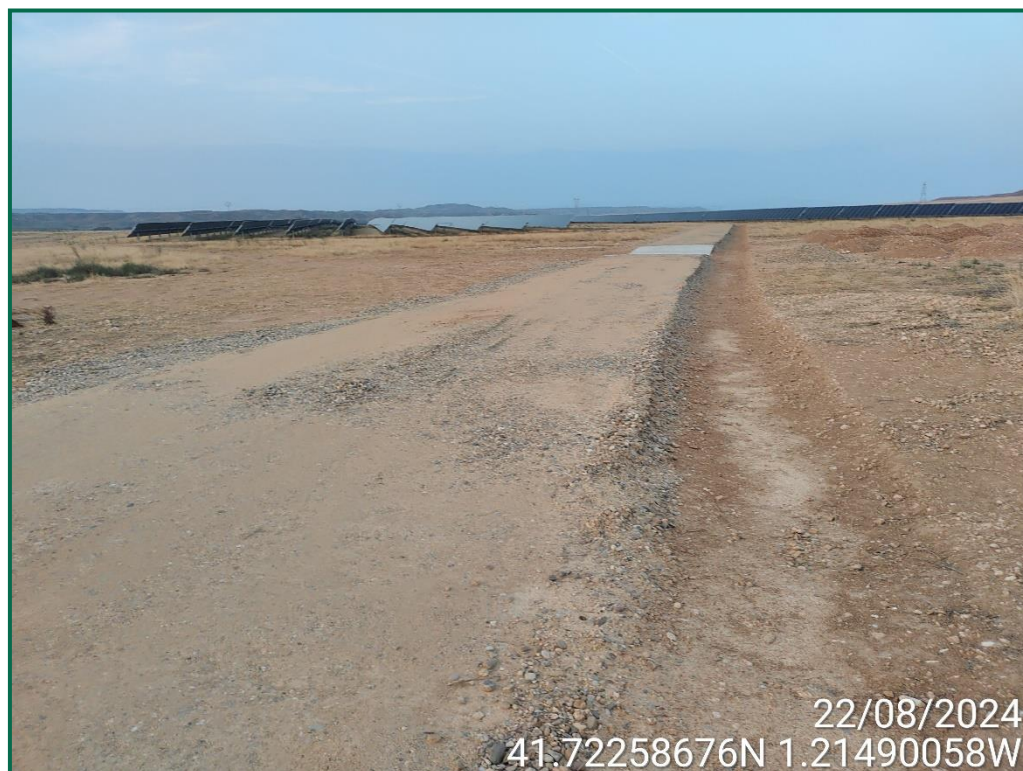
Fotografía 4. Habilitación de viales.
