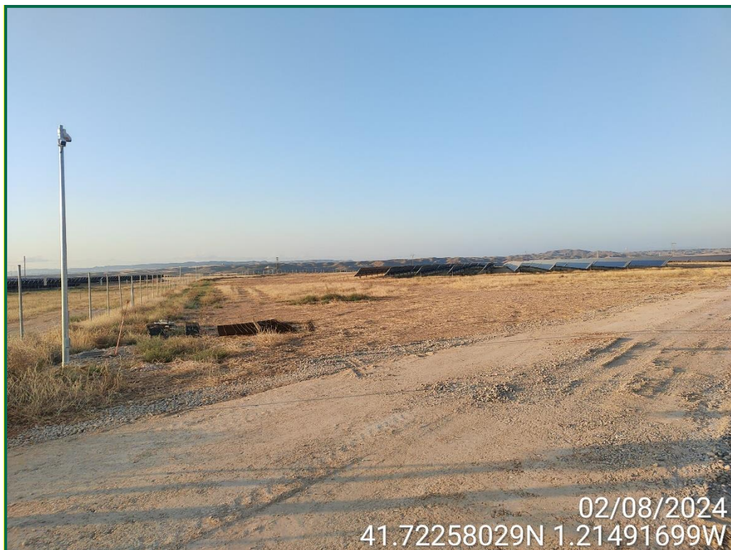
Fotografía 3. Superficie de la obra.
