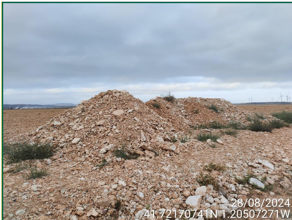
Fotografía 11. Acopios de tierra.
