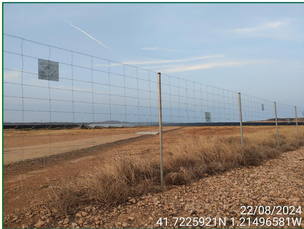
Fotografía 9. Vallado perimetral y placas anticolidión.
