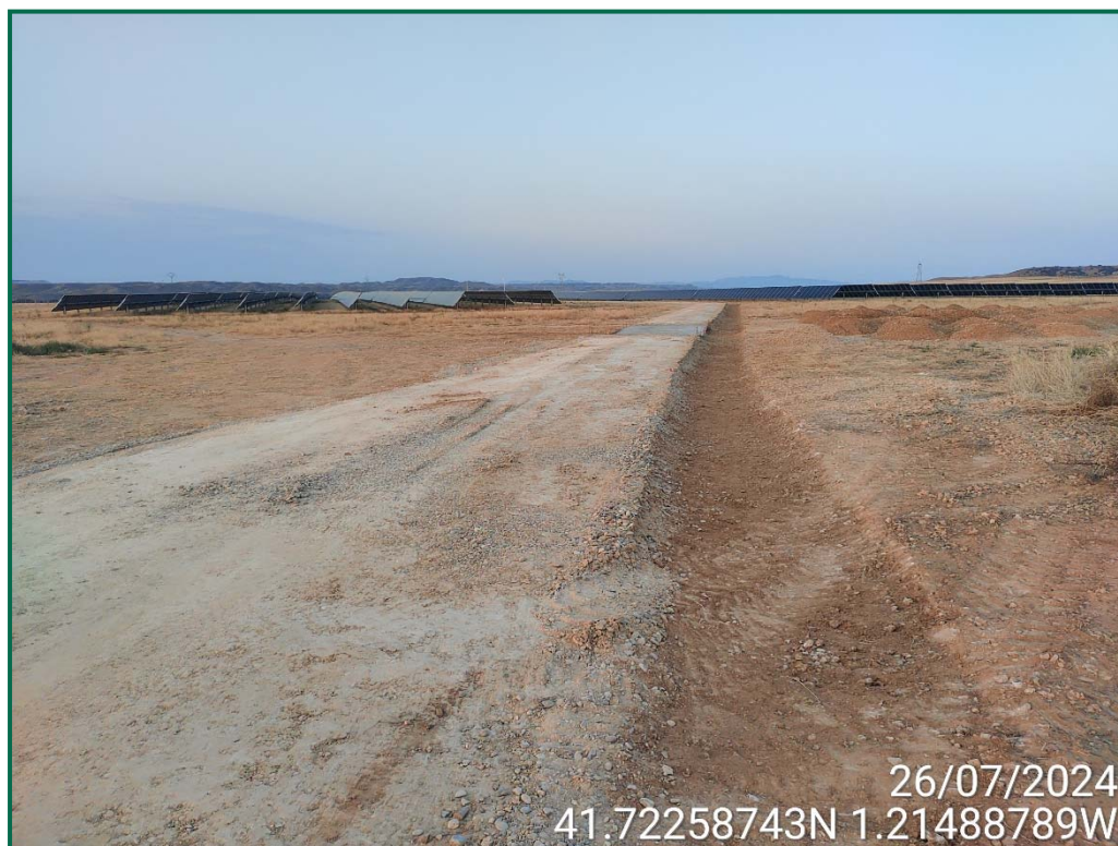
Fotografía 8. Habilitación de viales y cunetas.
