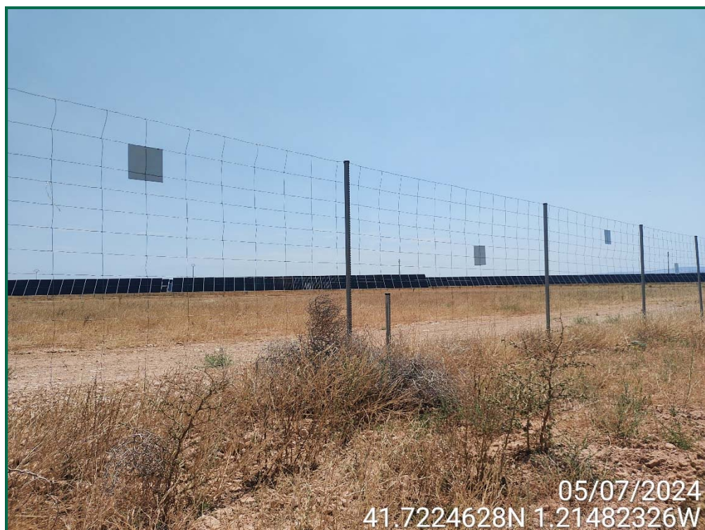
Fotografía 13. Vallado perimetral y placas anticolidión.
