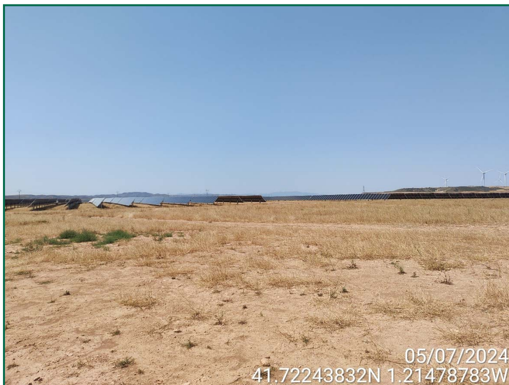
Fotografía 6. Superficie de la obra.
