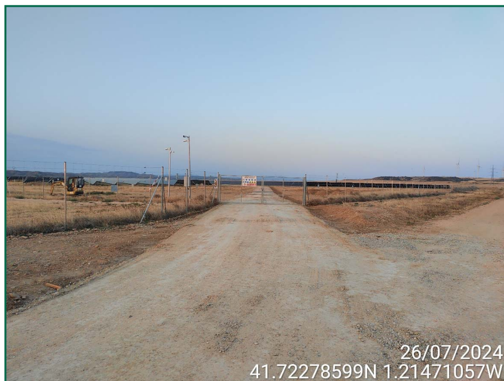
Fotografía 7. Habilitación de viales.
