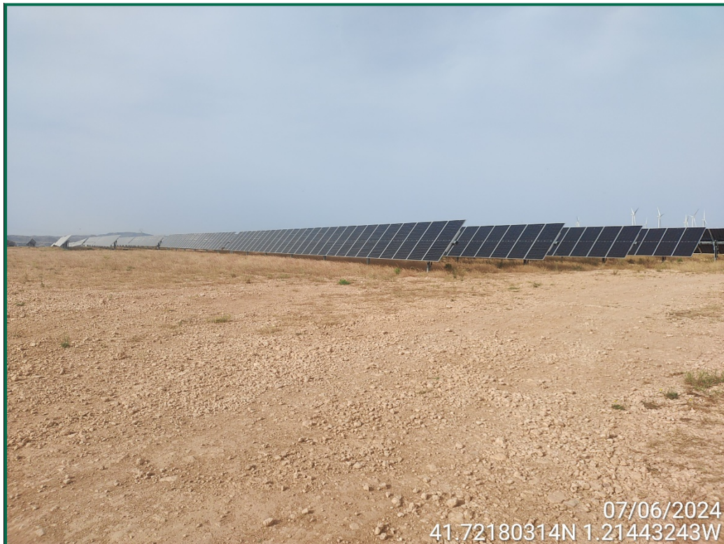
Fotografía 1. Superficie de la obra.
