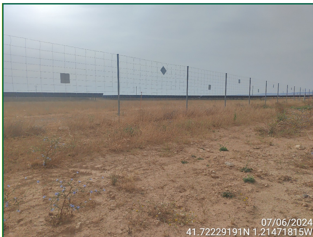
Fotografía 9. Vallado perimetral y placas anticolisión.
