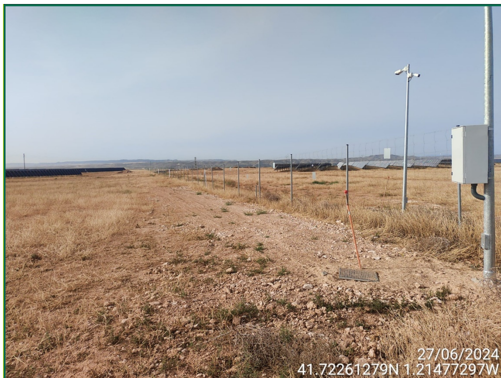
Fotografía 8. Vallado perimetral entre Pradillo 3 y 4 con placas anticolisión y pasos de fauna.
