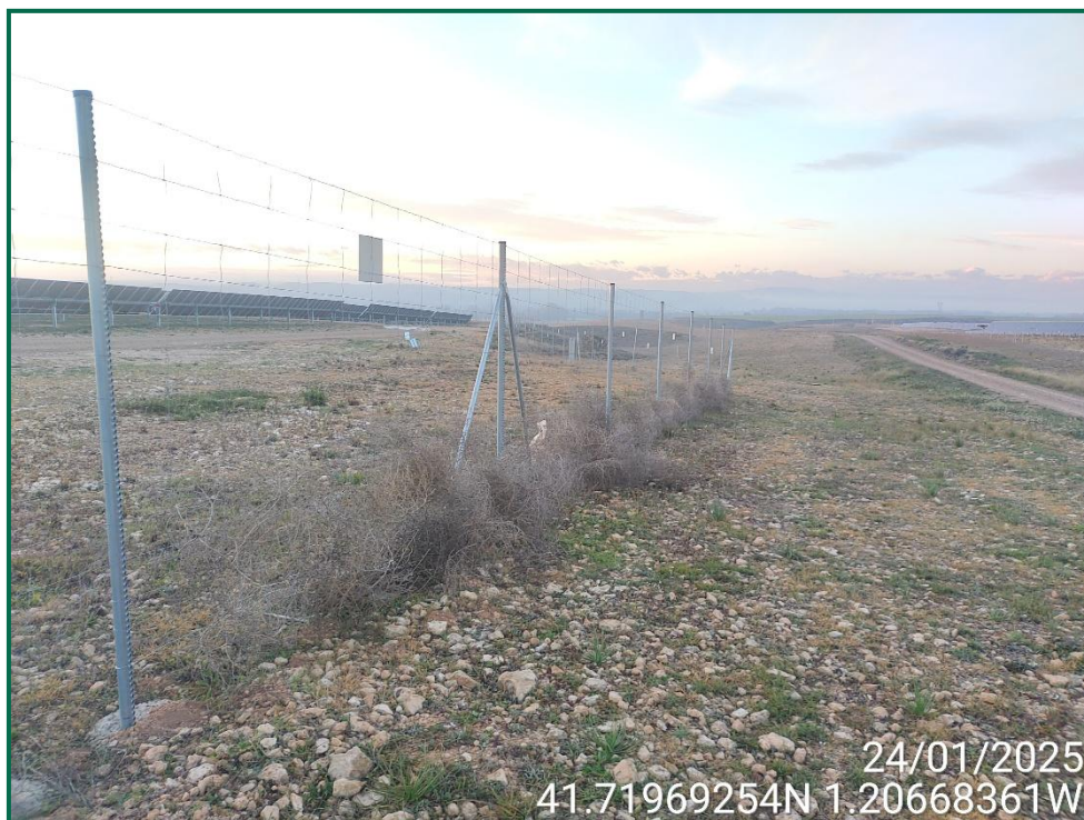
Fotografía 4. Vallado perimetral actualmente.
