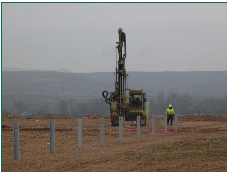
Fotografía 8. Hincas sobre el terreno.
