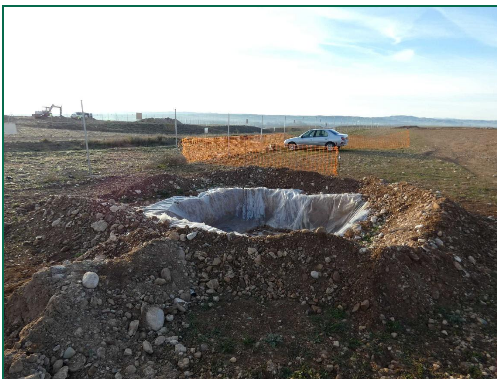
Fotografía 27. Balsa de limpieza.
