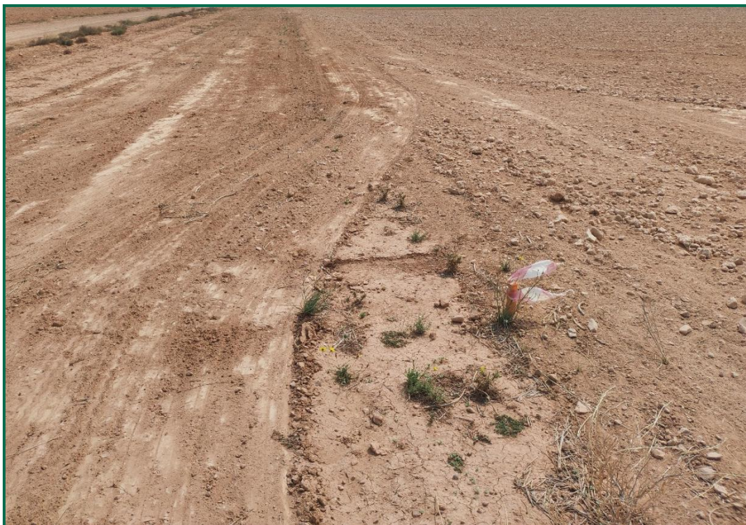
Fotografía 1. Jalonamiento previo mediante estacas.
