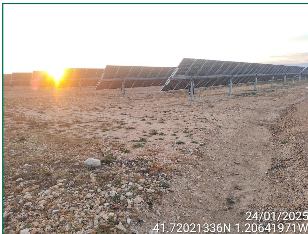
Fotografía 7. Superficie de la obra.
