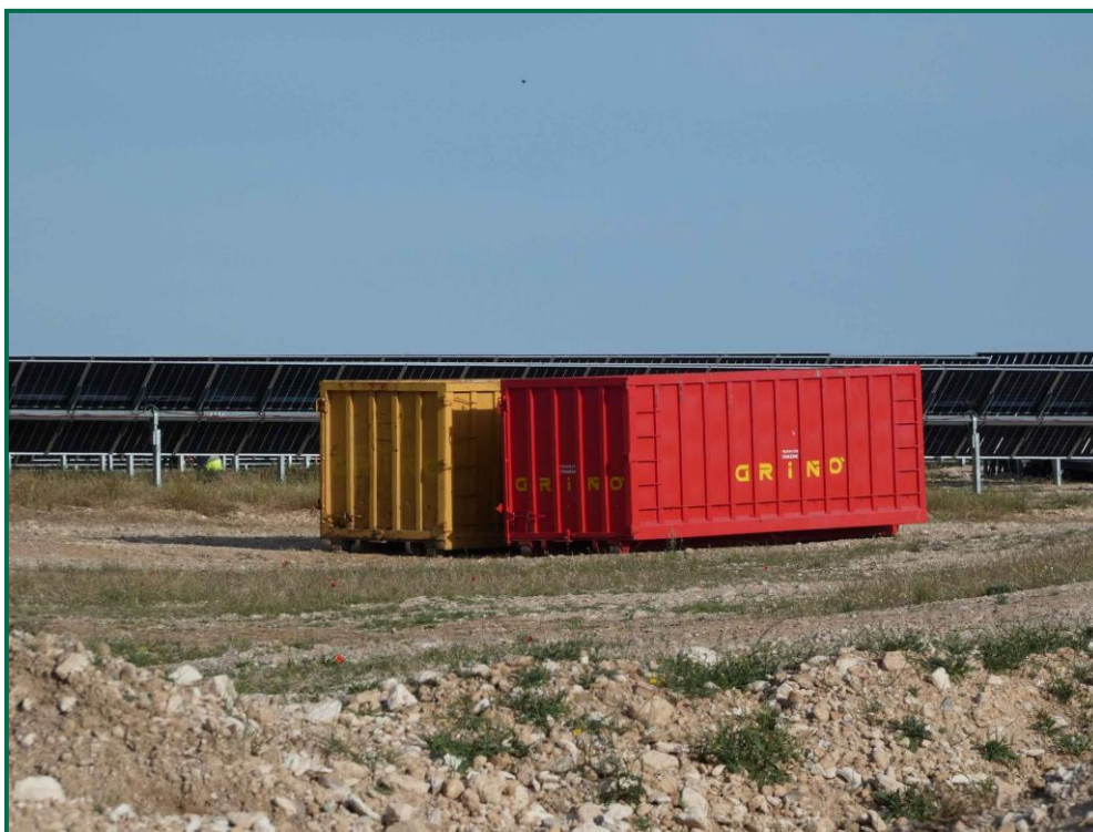
Fotografía 22. Contenedores de residuos sobre la planta.
