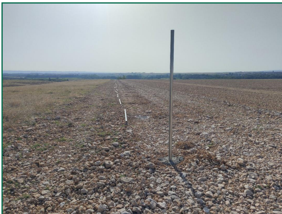
Fotografía 2. Colocación de postes para el vallado perimetral.
