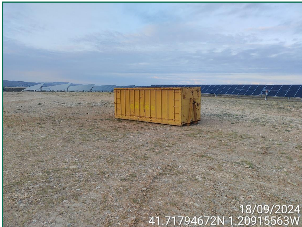
Fotografía 21. Último contenedor de residuos sobre la superficie de la obra, ya retirado.
