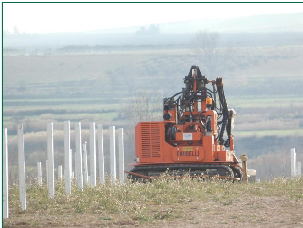
Fotografía 9. Hincas sobre el terreno.
