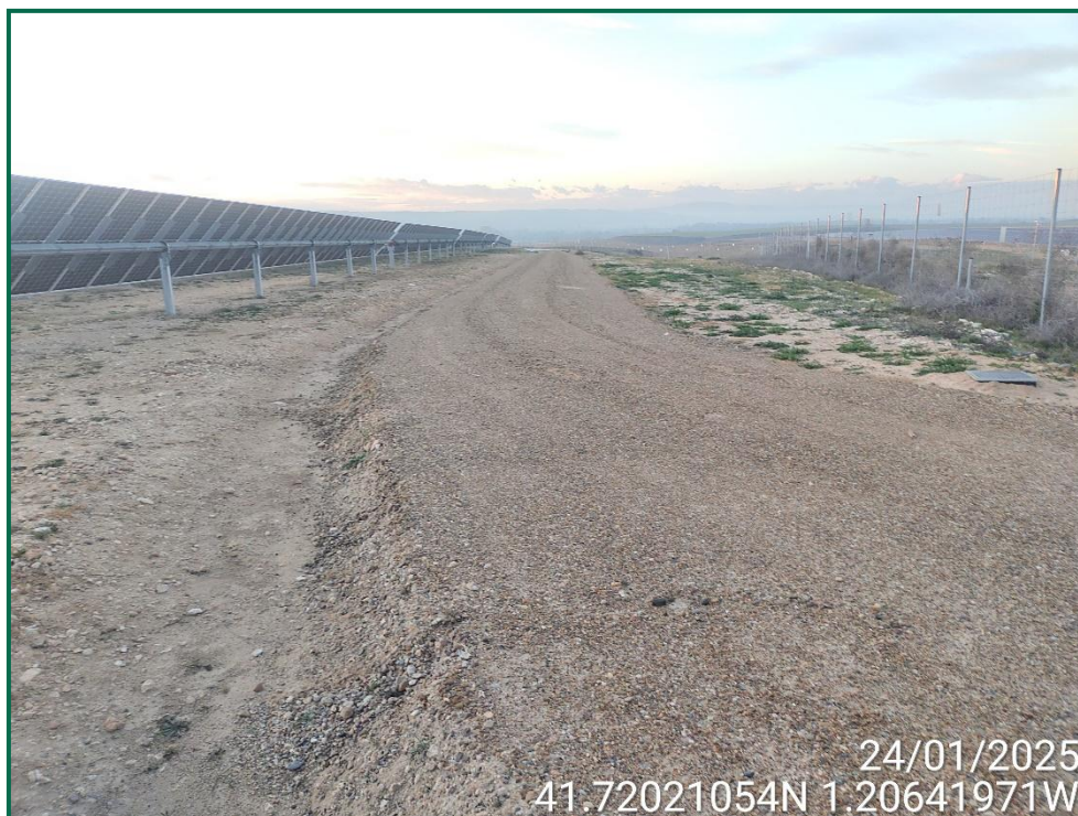
Fotografía 6. Habilitación de viales y cunetas.
