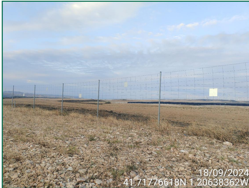
Fotografía 14. Placas anticollisión y vallado perimetral.
