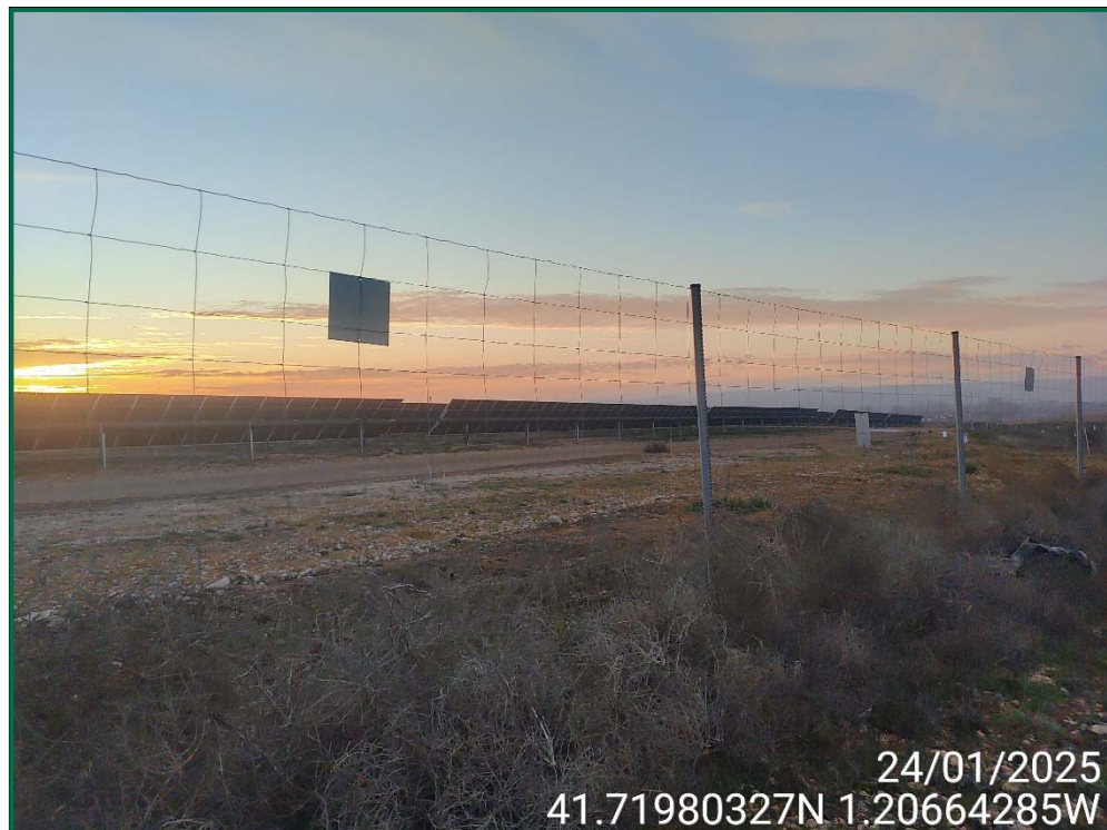
Fotografía 7. Vallado perimetral y placas anticolidión.
