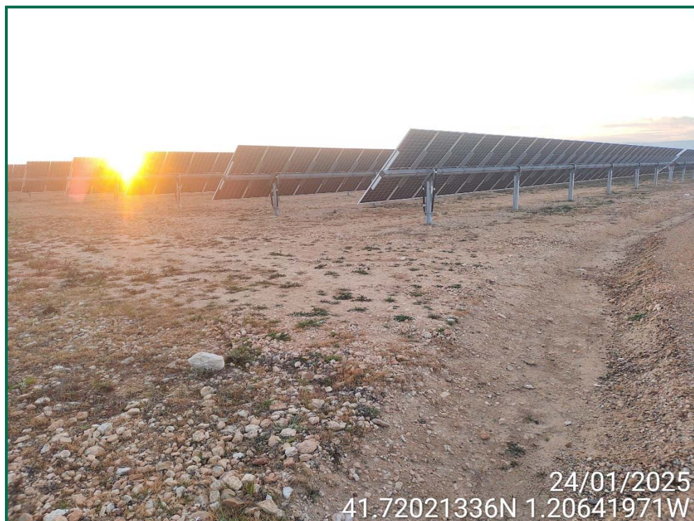
Fotografía 3. Superficie de la obra.
