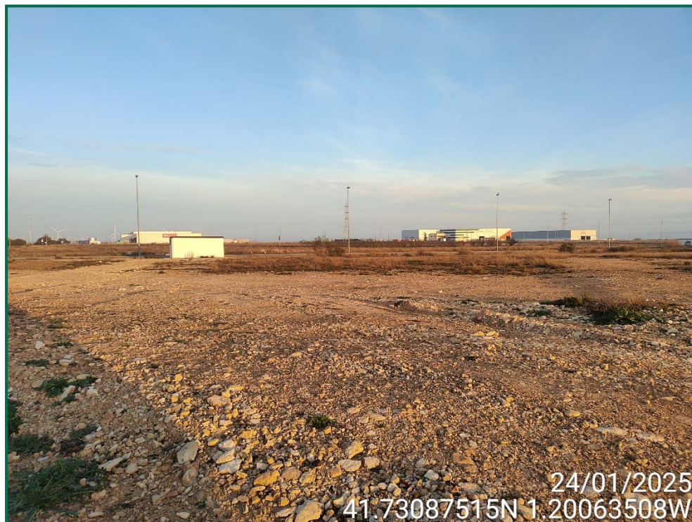
Fotografía 9. Final de la línea de evacuación.
