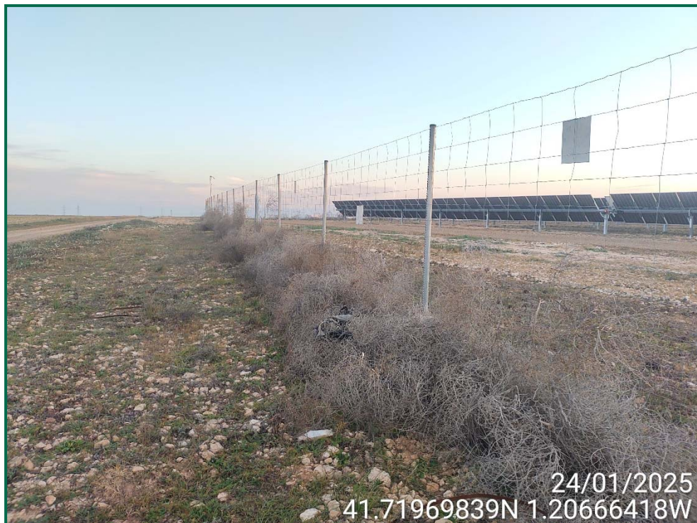
Fotografía 6. Franja vegetal y capitanas sobre el vallado.
