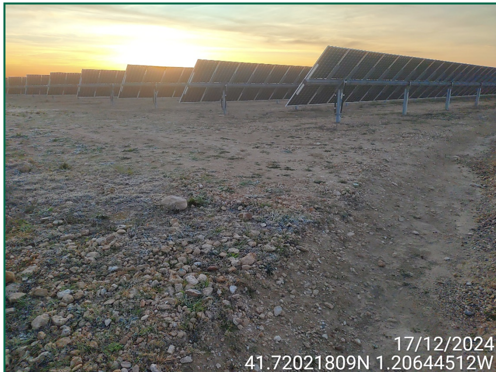
Fotografía 3. Superficie de la obra.
