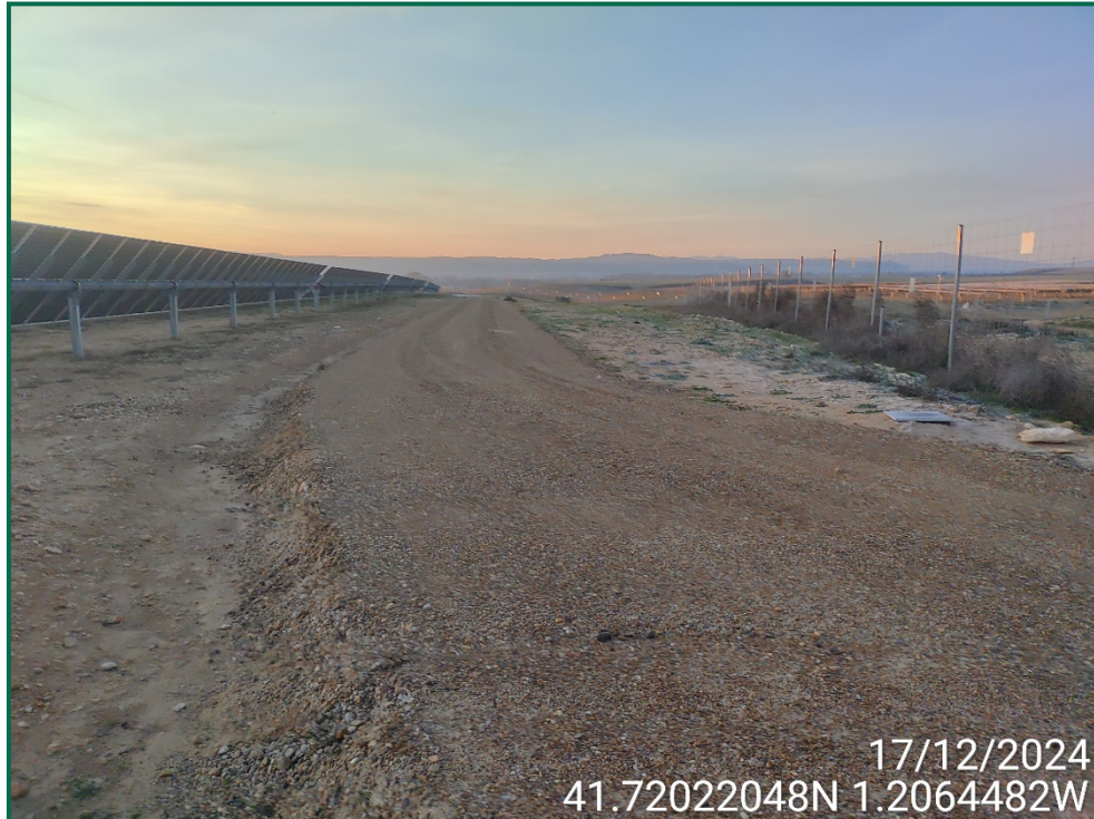
Fotografía 4. Habilitación de viales y cunetas.
