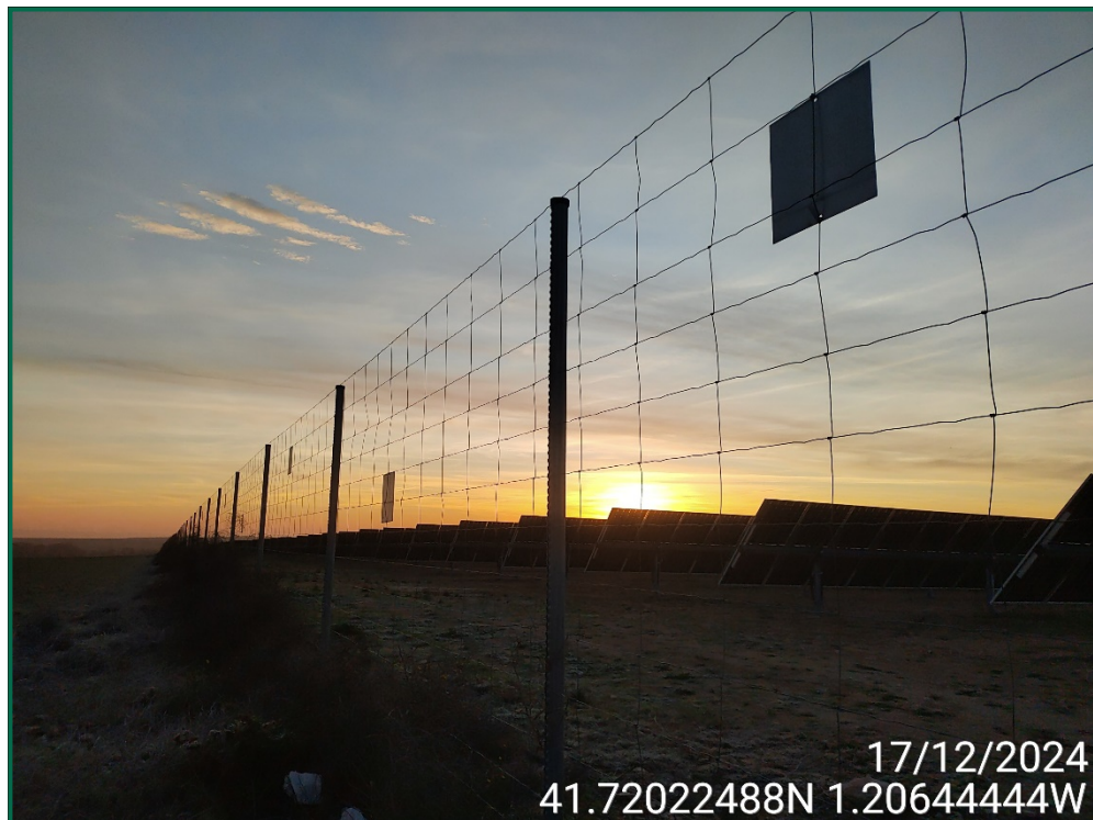
Fotografía 8. Vallado perimetral y placas anticollisión.
