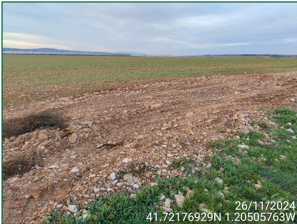
Fotografía 9. Zanjas tapadas y acopios de tierra.
