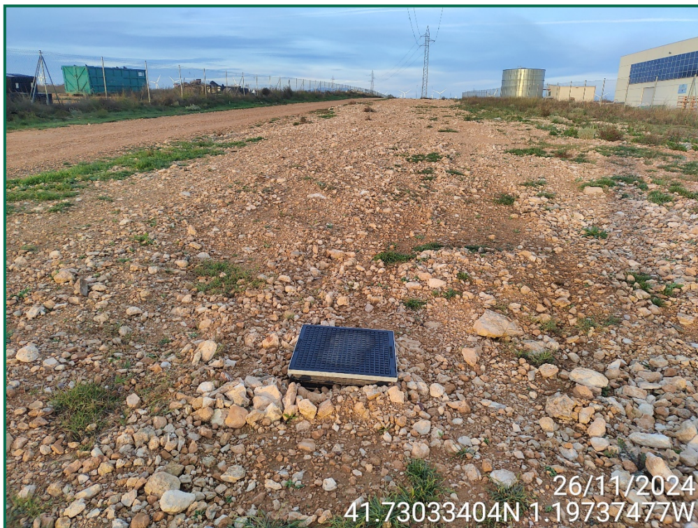
Fotografía 10. Zanjas tapadas y acopios de tierra.
