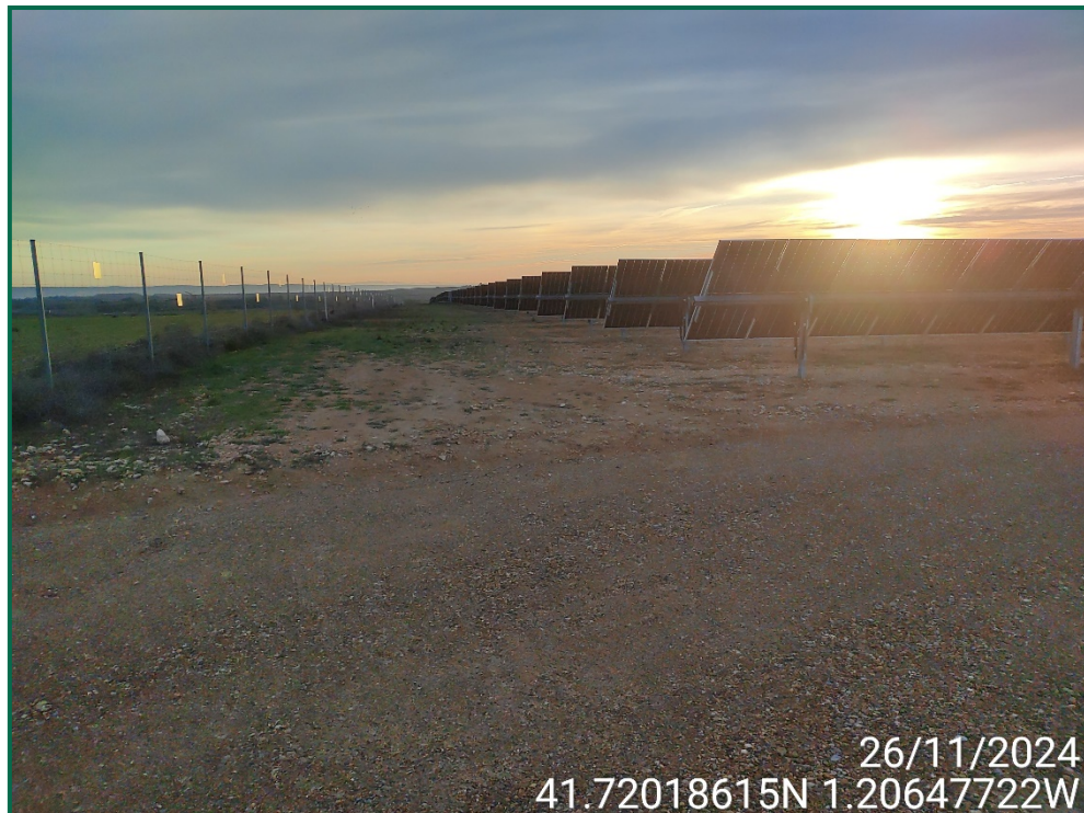
Fotografía 3. Superficie de la obra.
