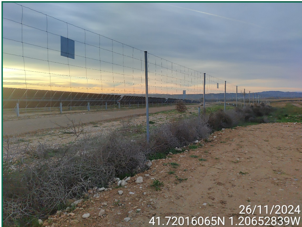
Fotografía 6. Vallado perimetral y placas anticollisión.
