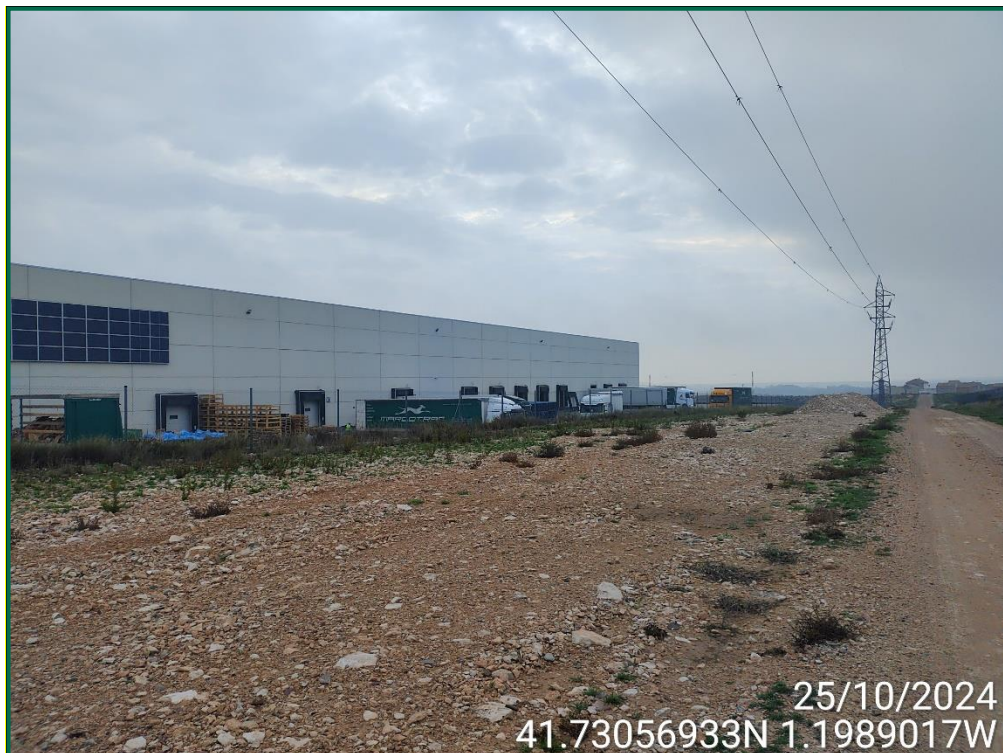
Fotografía 7. Zanjas tapadas y acopios de tierra.
