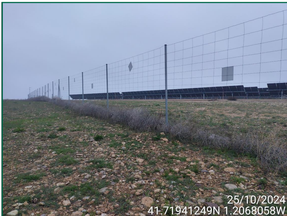
Fotografía 5. Vallado perimetral y placas anticolidión.
