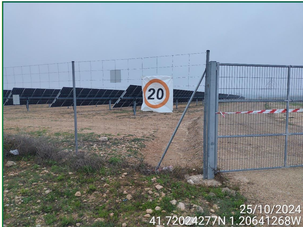
Fotografía 1. Señalización de velocidad.
