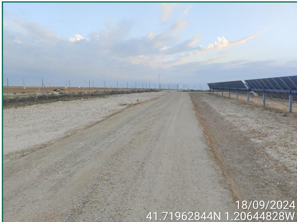
Fotografía 4. Habilitación de viales y cunetas.
