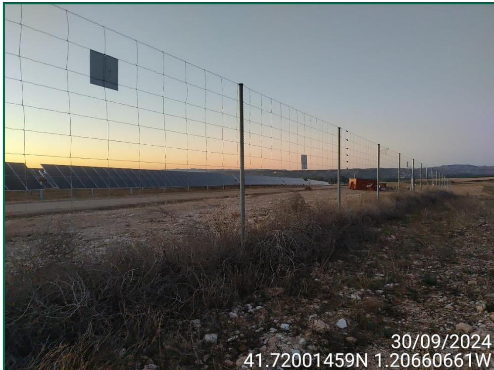
Fotografía 12. Vallado perimetral y placas anticollisión.
