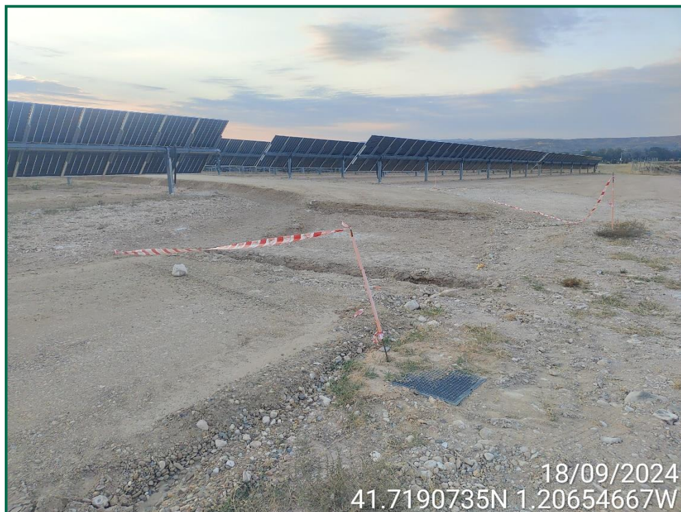
Fotografía 1. Balizado de zanjas para los viales.
