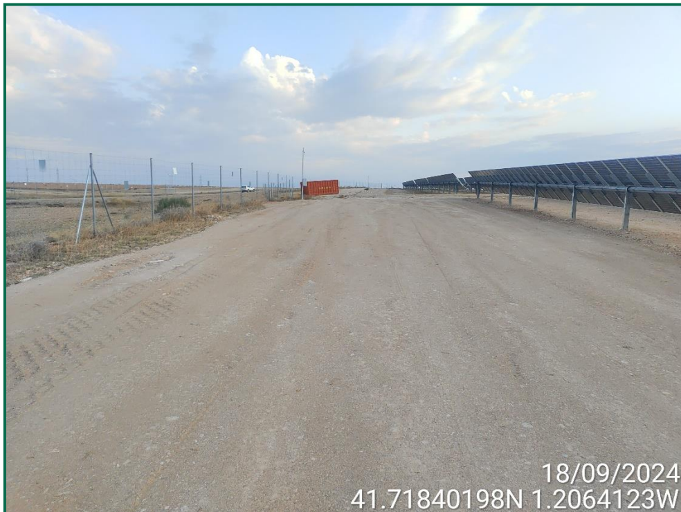
Fotografía 6. Allanado del terreno.
