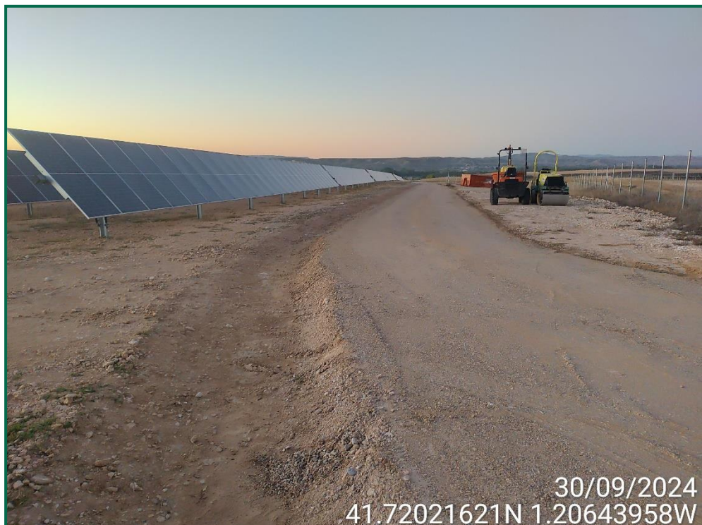
Fotografía 5. Habilitación de viales y cunetas.
