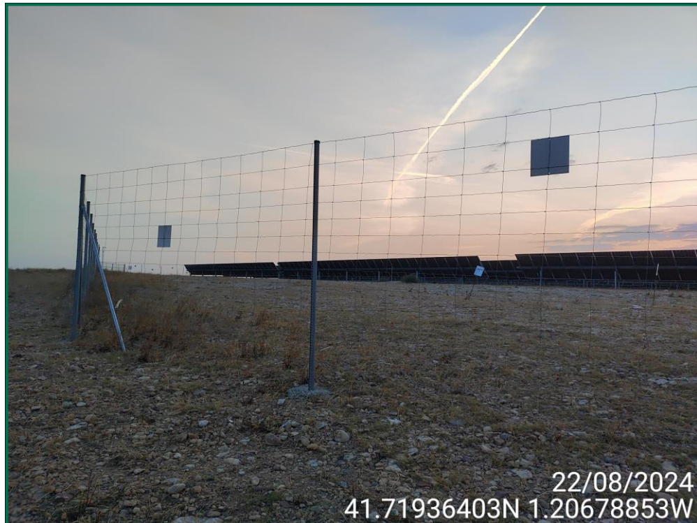
Fotografía 6. Vallado perimetral y placas anticollisión.
