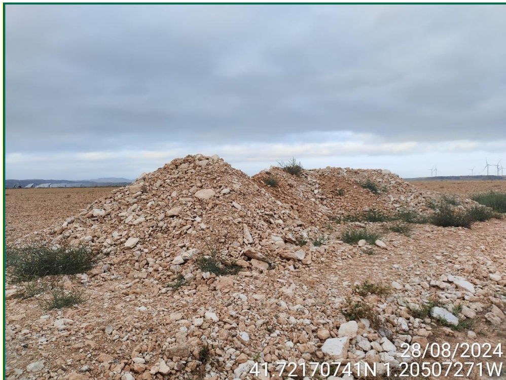
Fotografía 9. Acopios de tierra.
