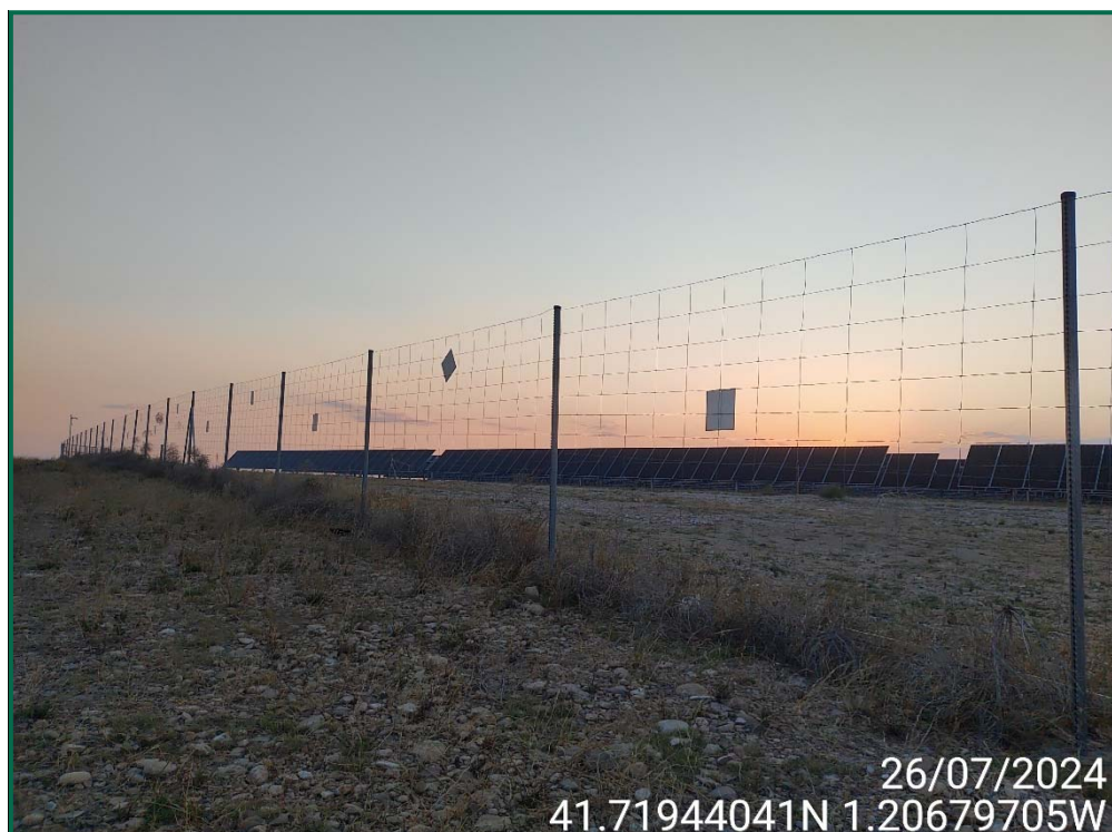
Fotografía 7. Vallado perimetral y placas anticolidión.
