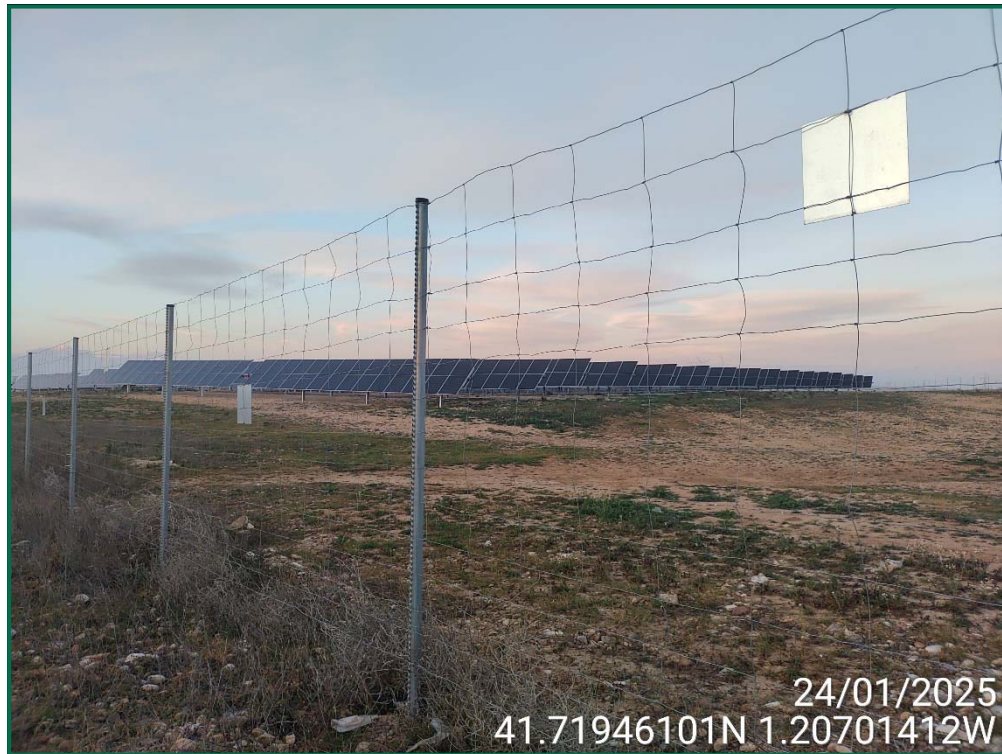
Fotografía 6. Vallado perimetral y placas anticollisión.
