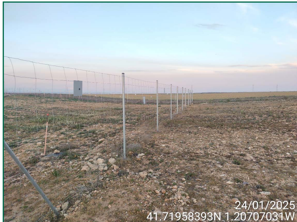
Fotografía 7. Vallado perimetral y placas anticollisión.
