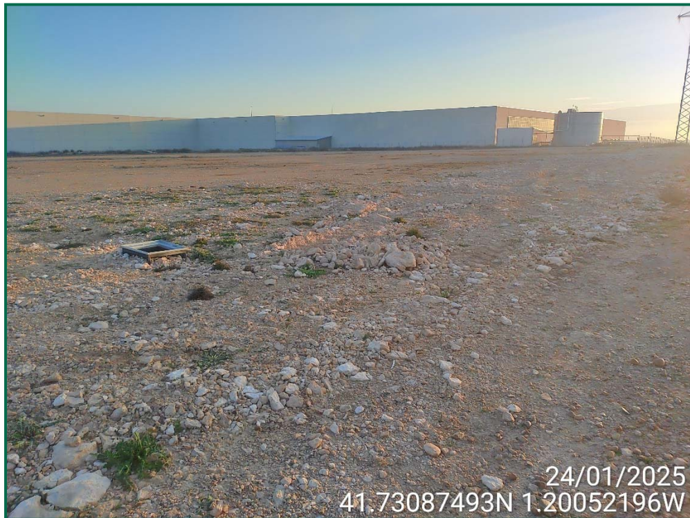
Fotografía 10. Línea de evacuación tapada.
