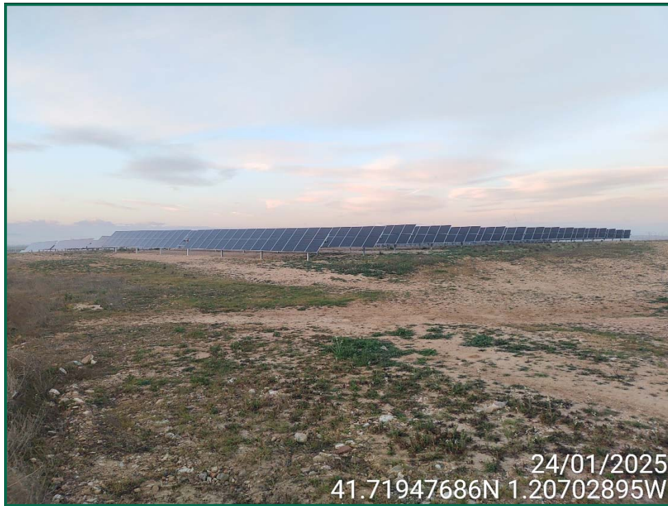
Fotografía 4. Superficie de la obra.
