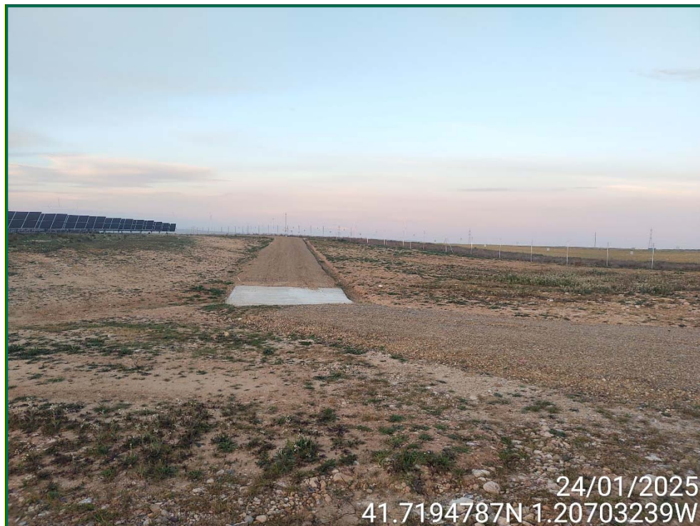
Fotografía 3. Habilitación de viales y cunetas.
