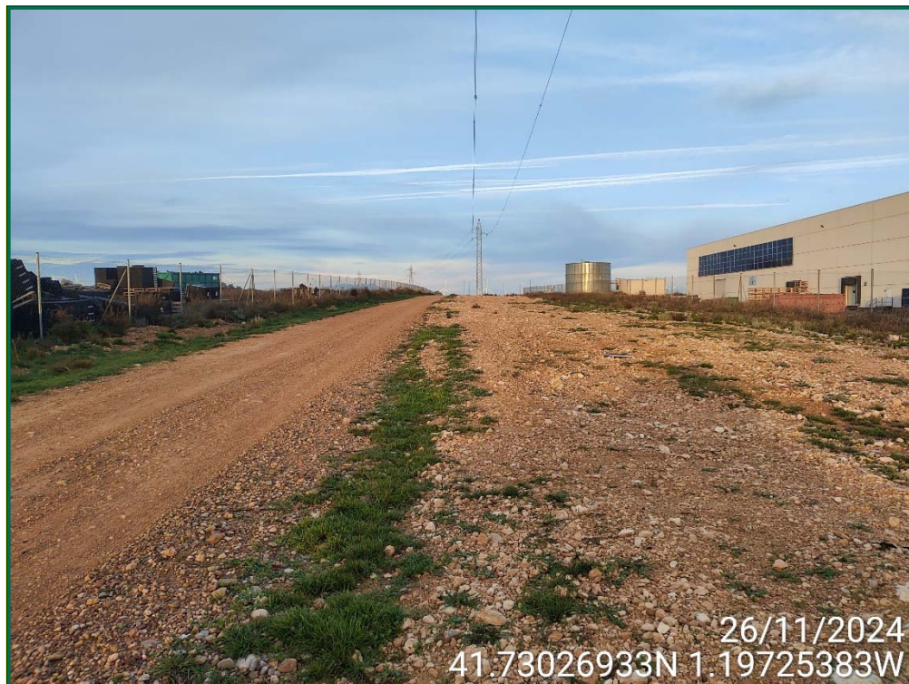
Fotografía 8. Zanjas tapadas y acopios de tierra.
