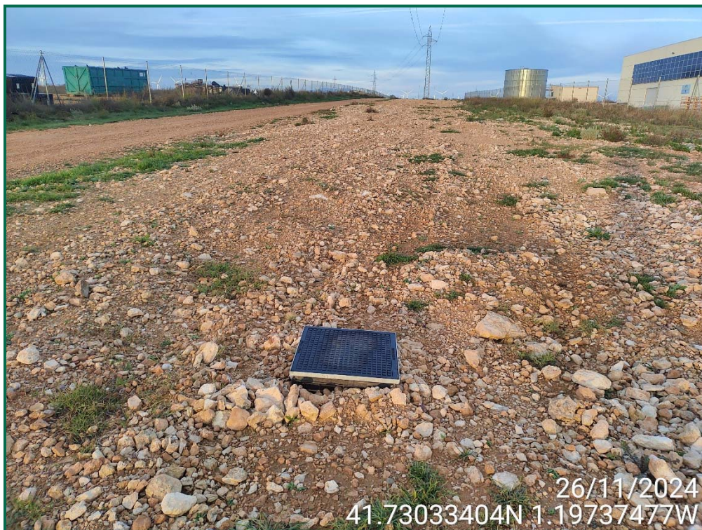
Fotografía 10. Zanjas tapadas y acopios de tierra.
