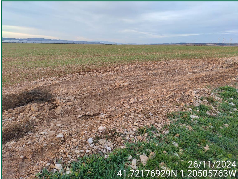
Fotografía 9. Zanjas tapadas y acopios de tierra.
