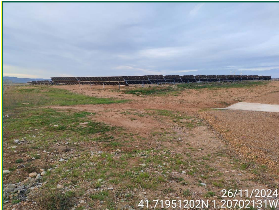
Fotografía 4. Superficie de la obra.
