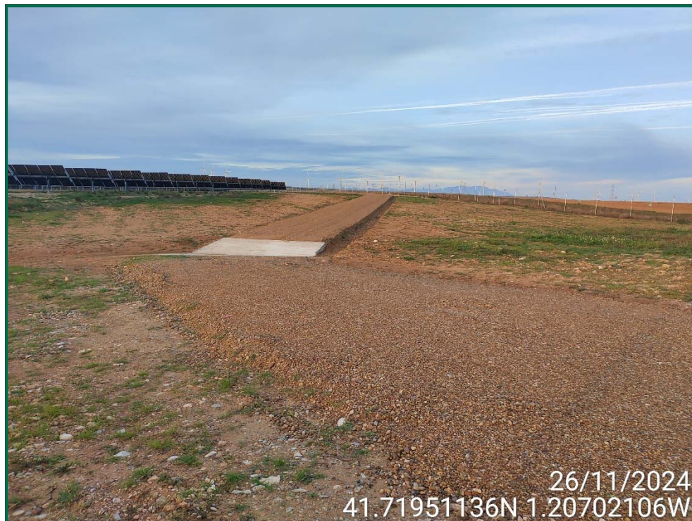
Fotografía 3. Habilitación de viales y cunetas.
