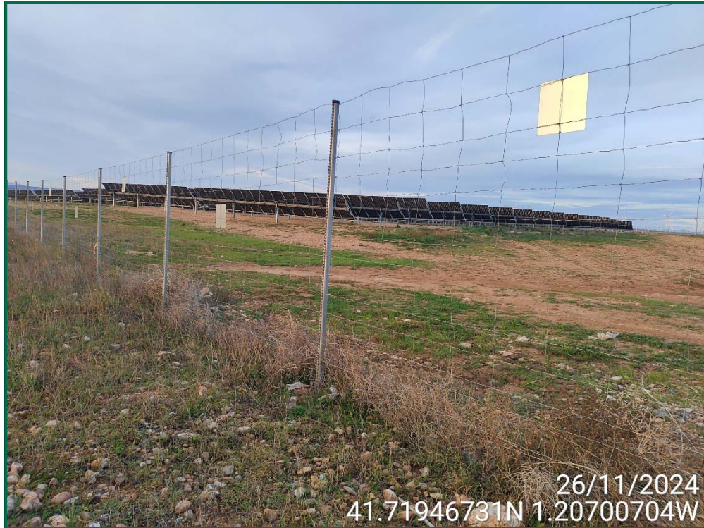
Fotografía 6. Vallado perimetral y placas anticollisión.
