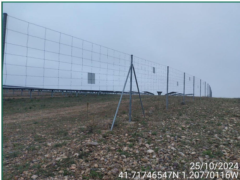
Fotografía 7. Vallado perimetral y placas anticolidión.
