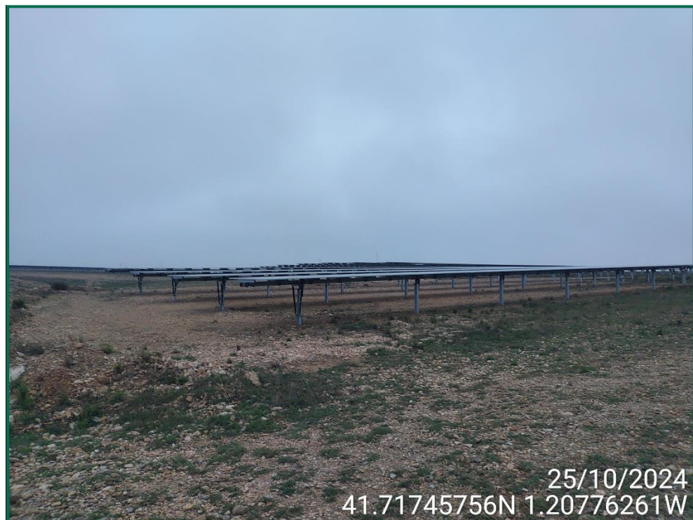
Fotografía 5. Superficie de la obra.
