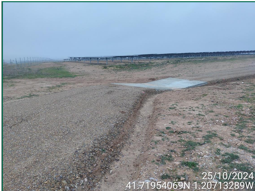
Fotografía 4. Habilitación de viales y cunetas.
