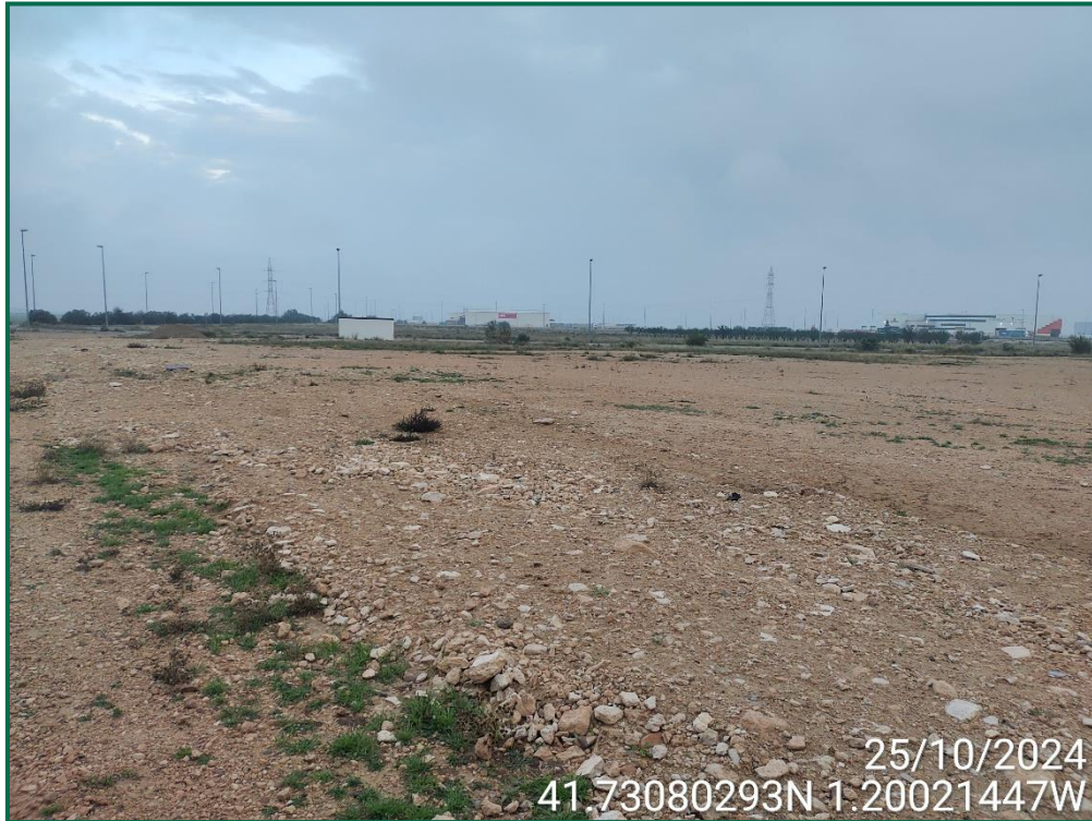
Fotografía 10. Final de la línea de evacuación.
