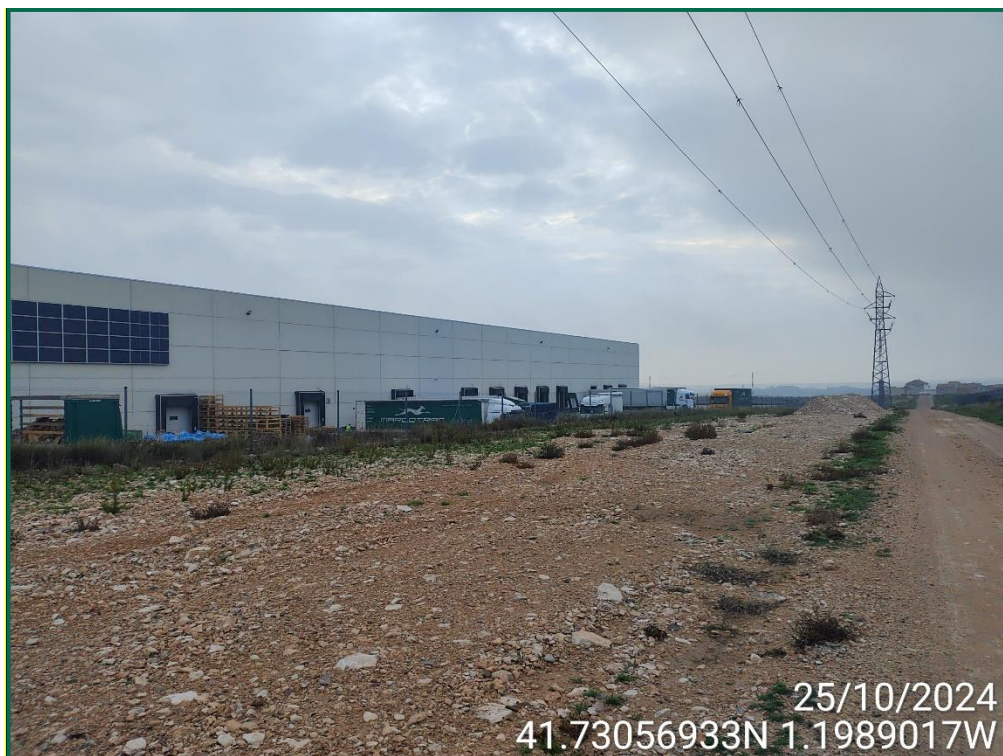
Fotografía 9. Zanjas tapadas y acopios de tierra.
