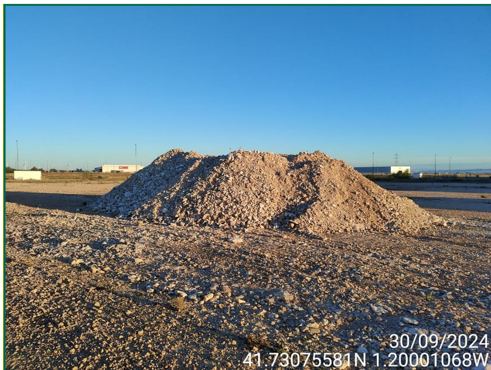
Fotografía 14. Acopios de tierra.
