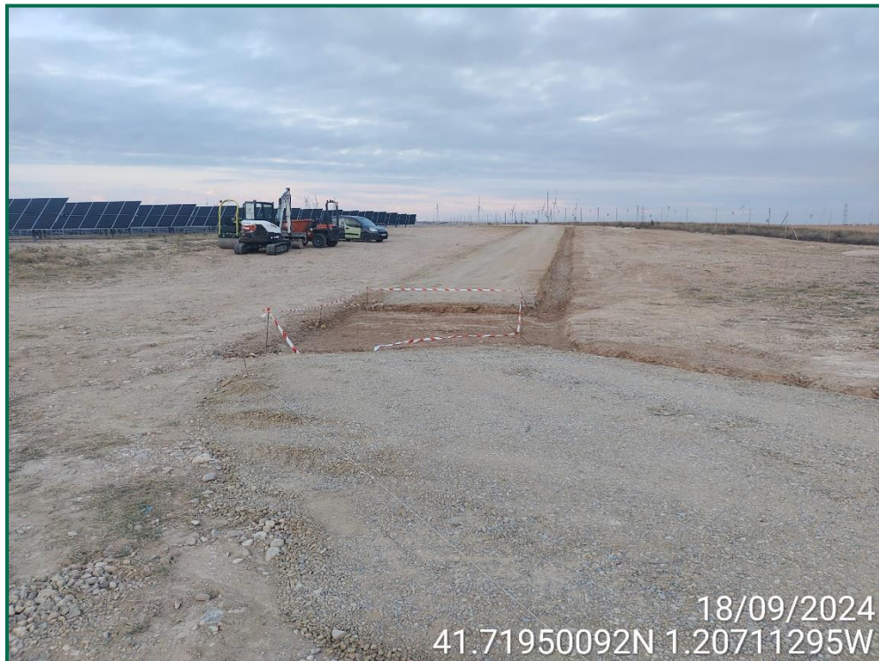
Fotografía 6. Habilitación de viales y cunetas.
