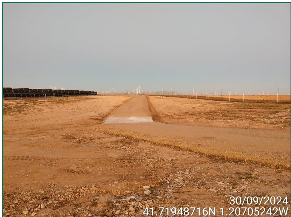
Fotografía 7. Habilitación de viales y cunetas finalizados.
