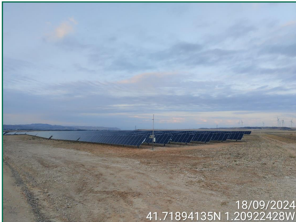
Fotografía 8. Superficie de la obra.
