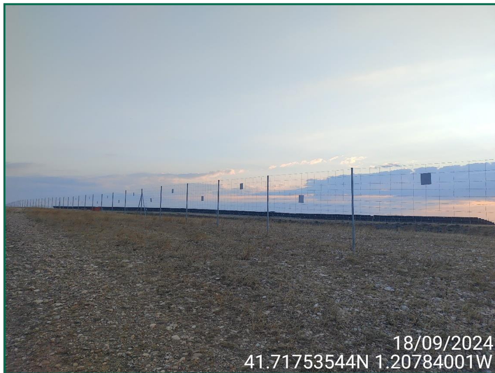
Fotografía 11. Vallado perimetral y placas anticolidión.
