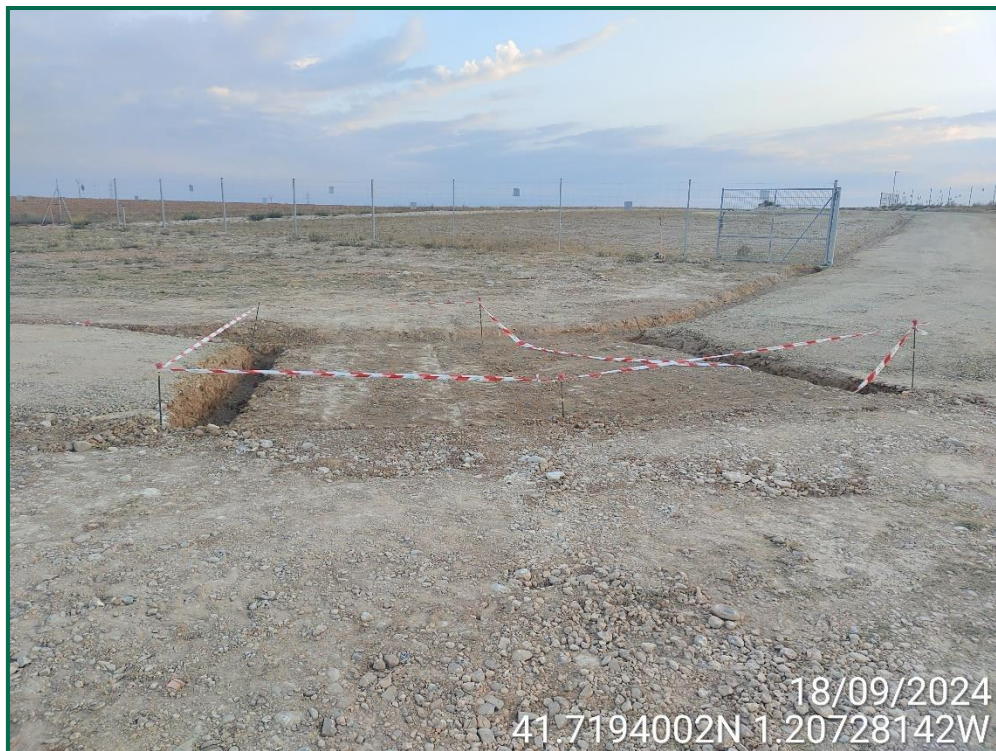
Fotografía 1. Balizado de zanjas para los viales.
