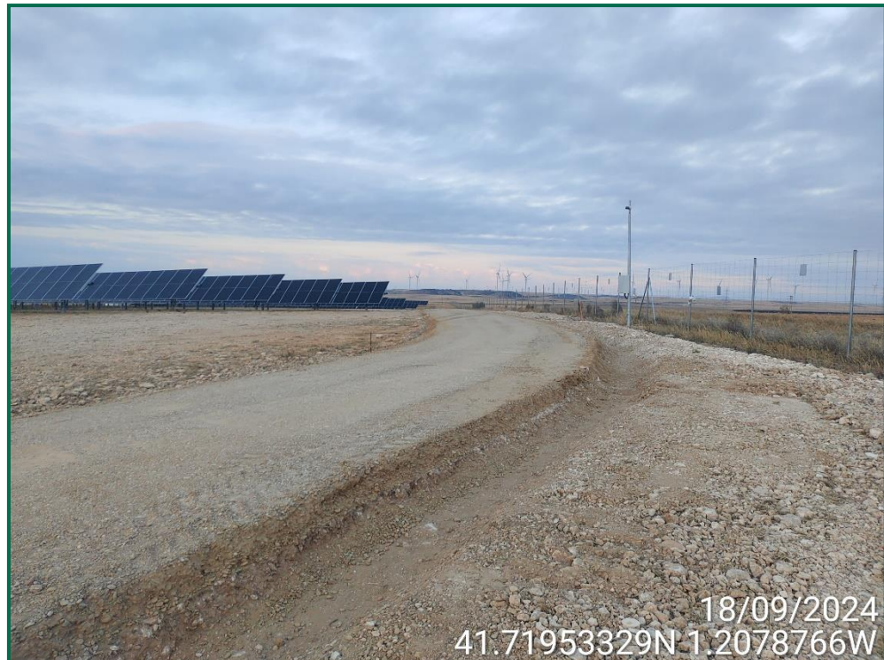
Fotografía 5. Habilitación de viales y cunetas.
