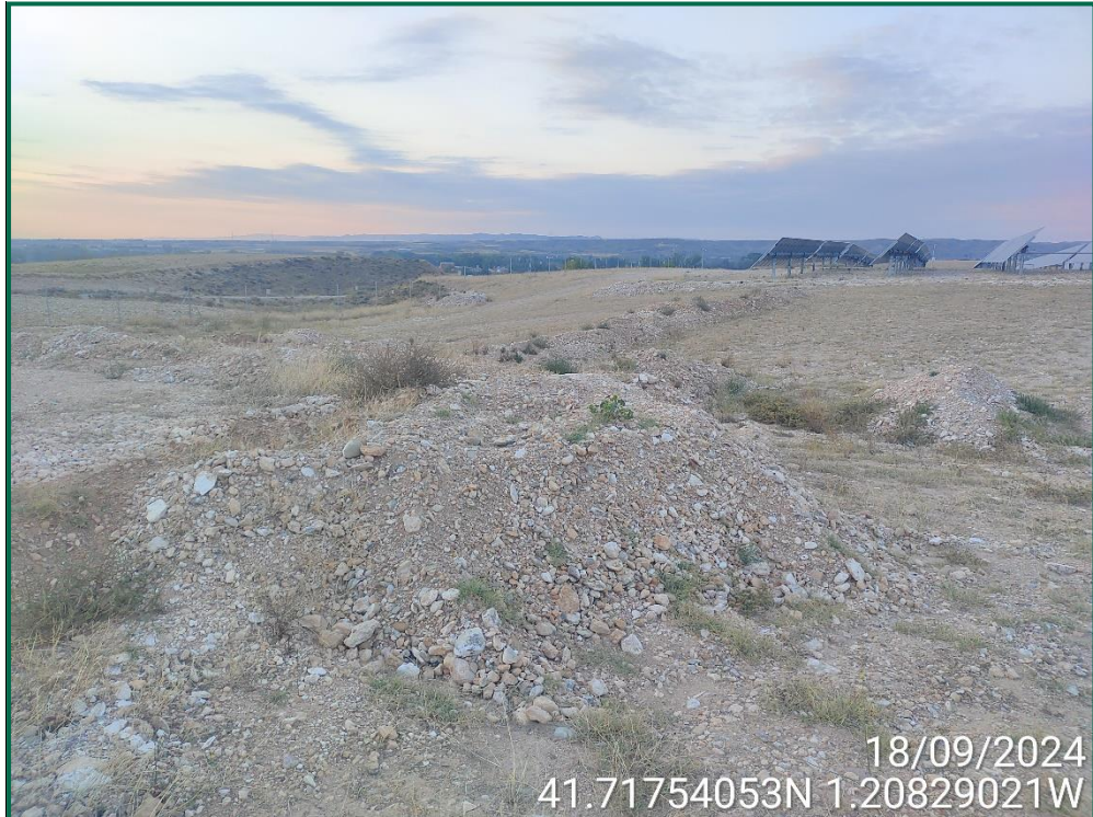
Fotografía 4. Acopios de tierra.
