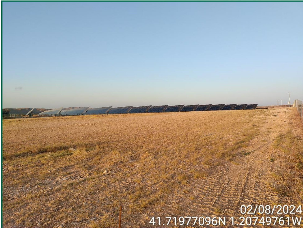
Fotografía 4. Superficie de la obra.
