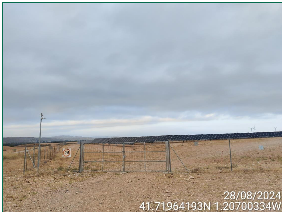
Fotografía 2. Señalización de velocidad y puerta de acceso.
