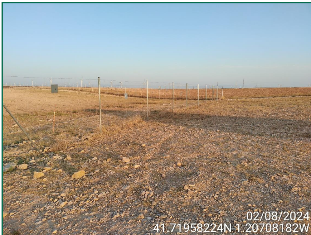
Fotografía 7. Vallado perimetral y placas anticolidión.
