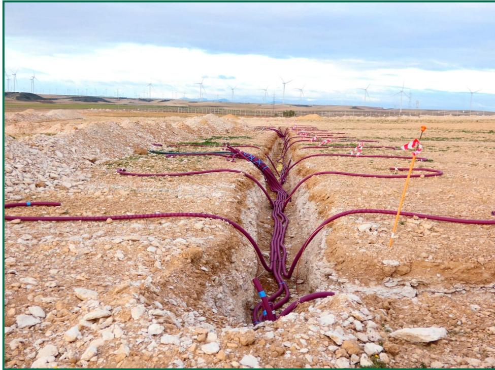
Fotografía 4. Zanjas y colocación del cableado.
