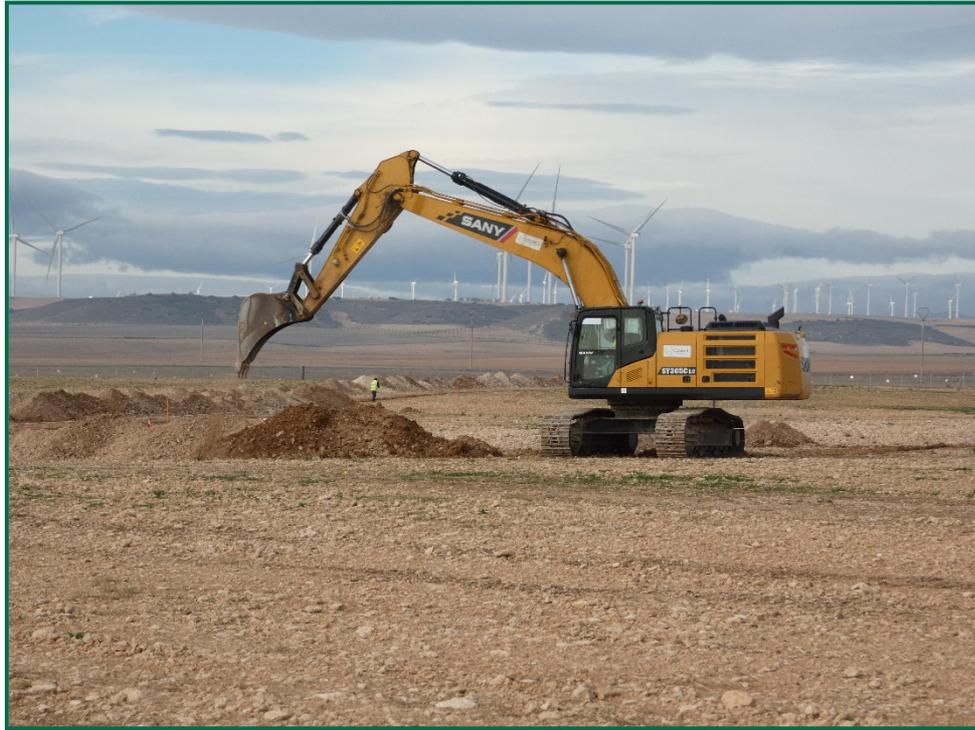
Fotografía 3. Excavadora realizando zanjas.
