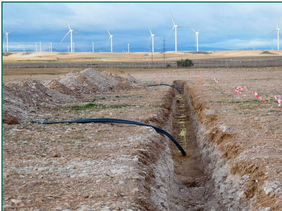
Fotografía 5. Zanjas y colocación del cableado.
