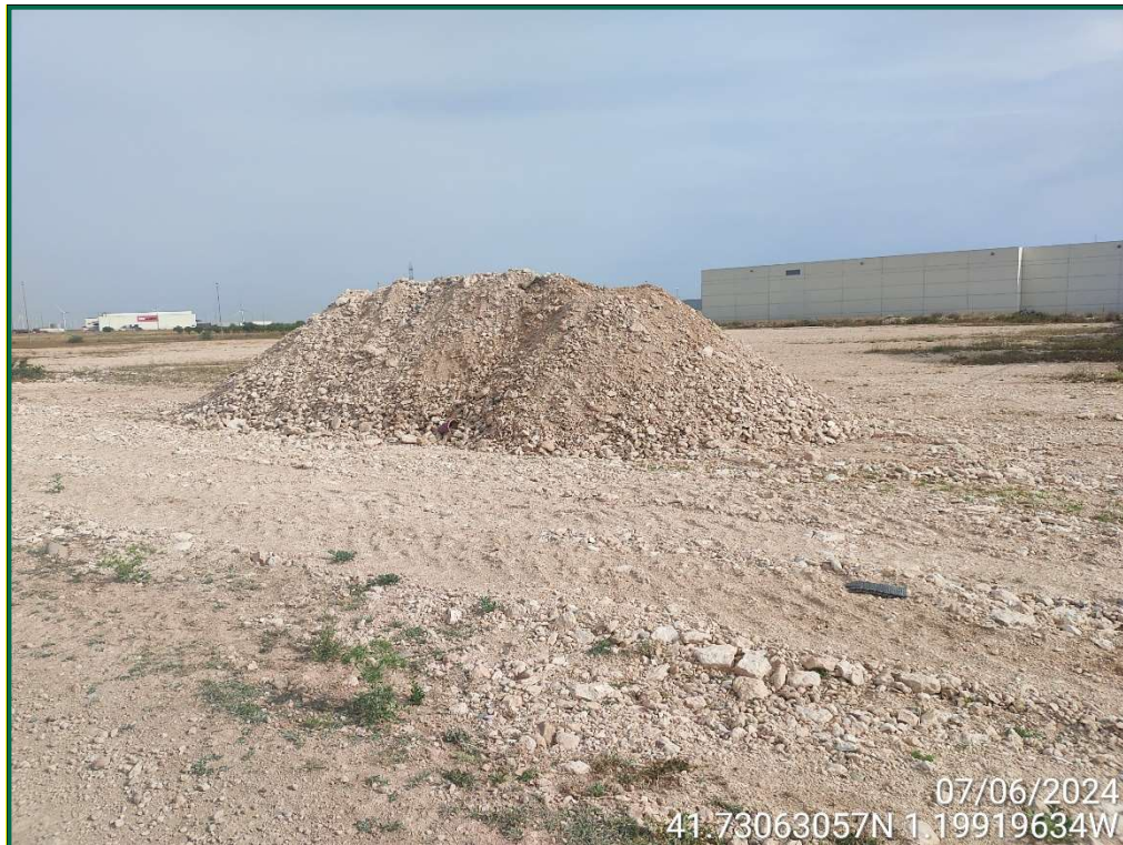
Fotografía 22. Acopios de tierra.
