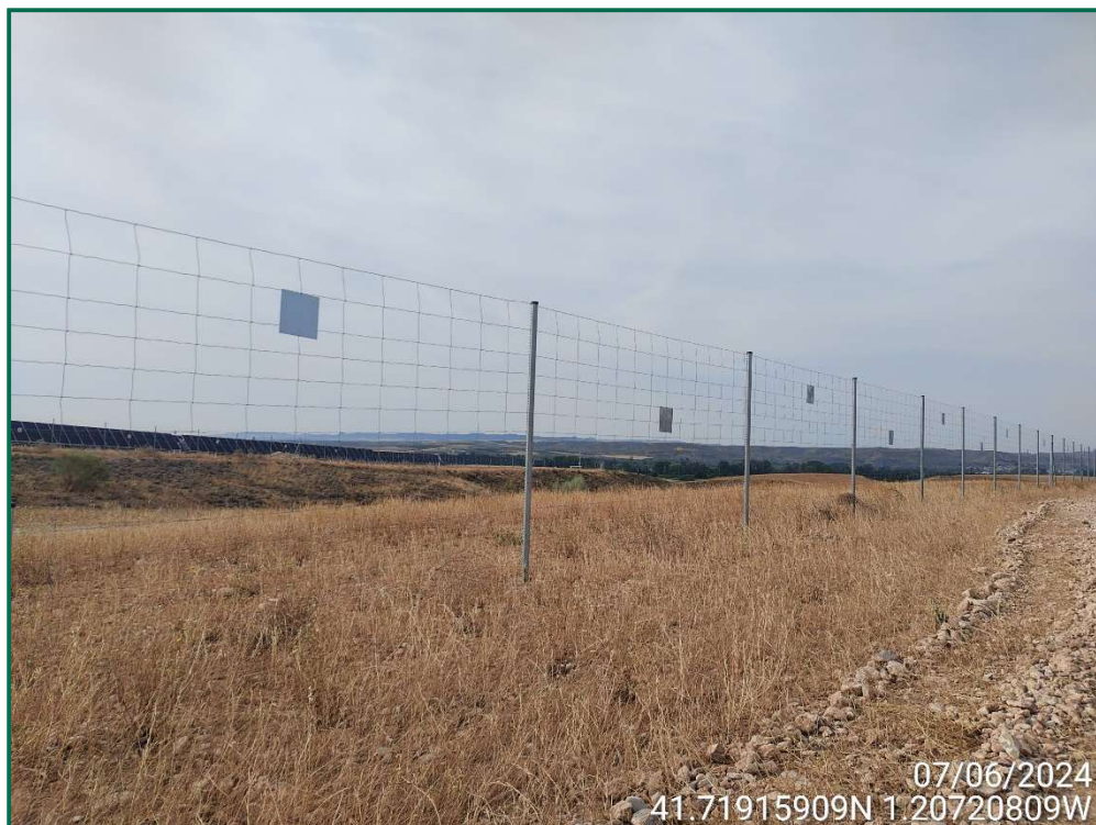
Fotografía 9. Vallado perimetral y placas anticolidión.
