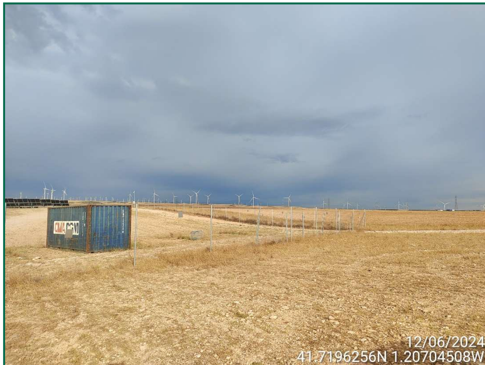
Fotografía 7. Exterior de la obra.
