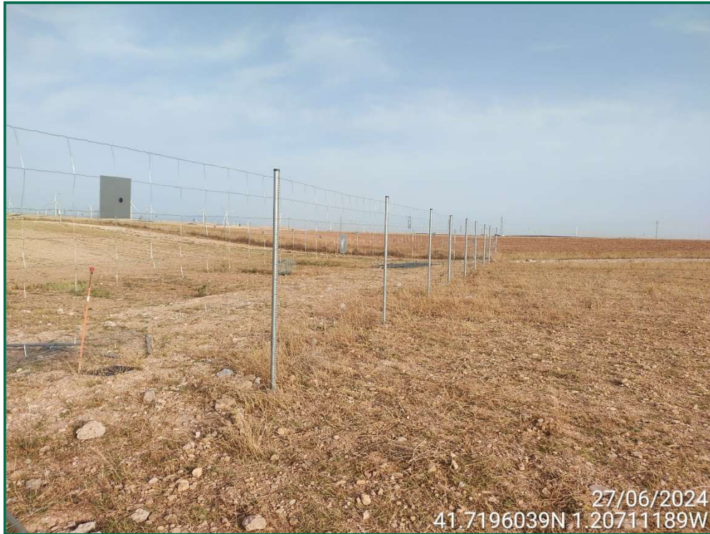
Fotografía 14. Vallado arreglado y reforzado.
