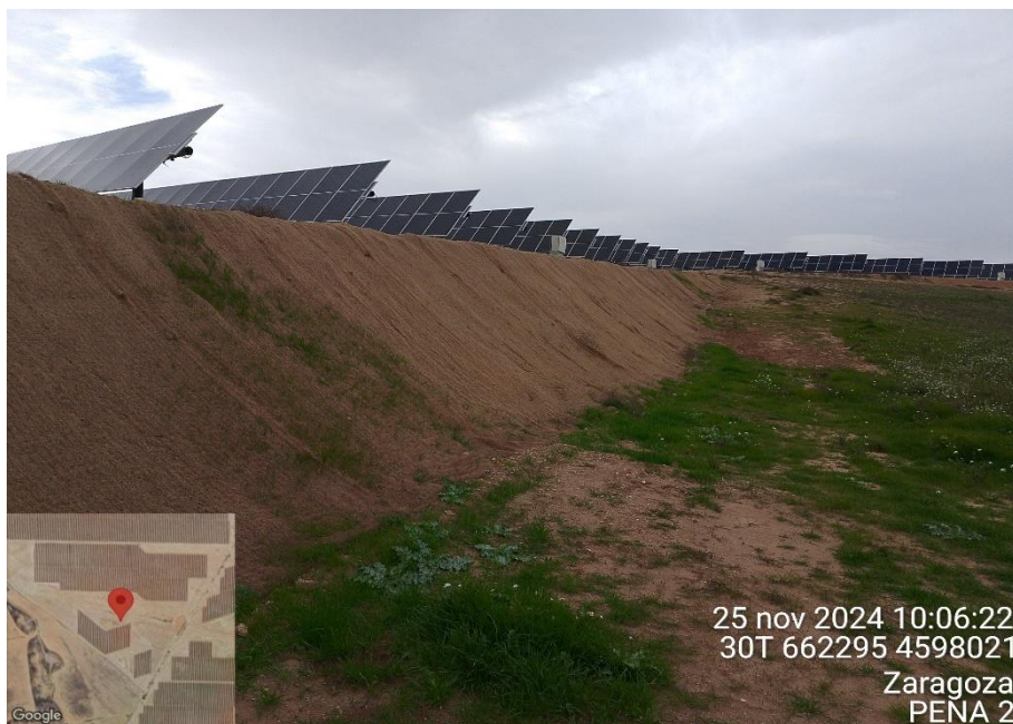
Fotografía 4. Talud con malla de fibra de coco comenzando a revegetar en la PSFV
