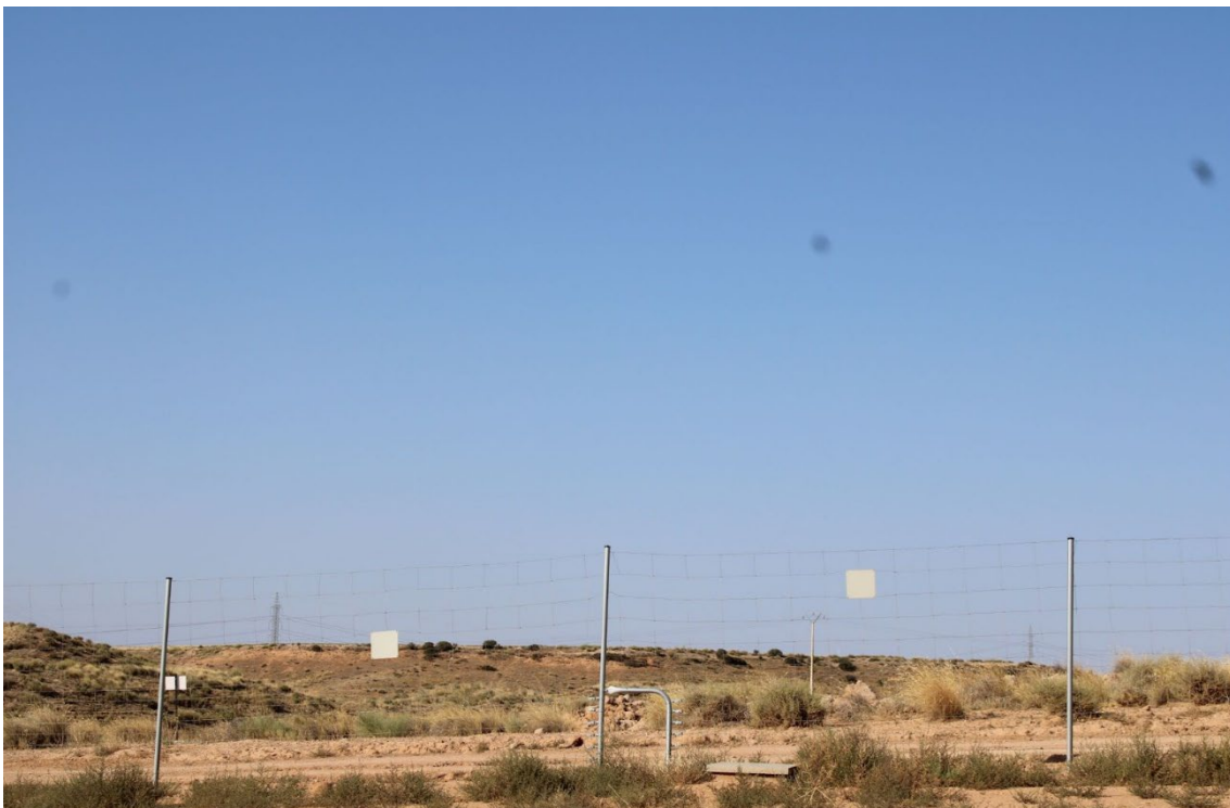
Fotografía 5. Vallado perimetral y paso de fauna en PSFV Pena 2
