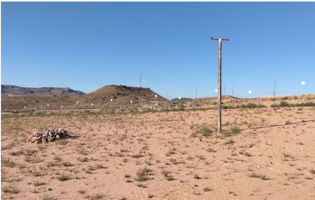
Fotografía 9. Posadero para aves en la PSFV
