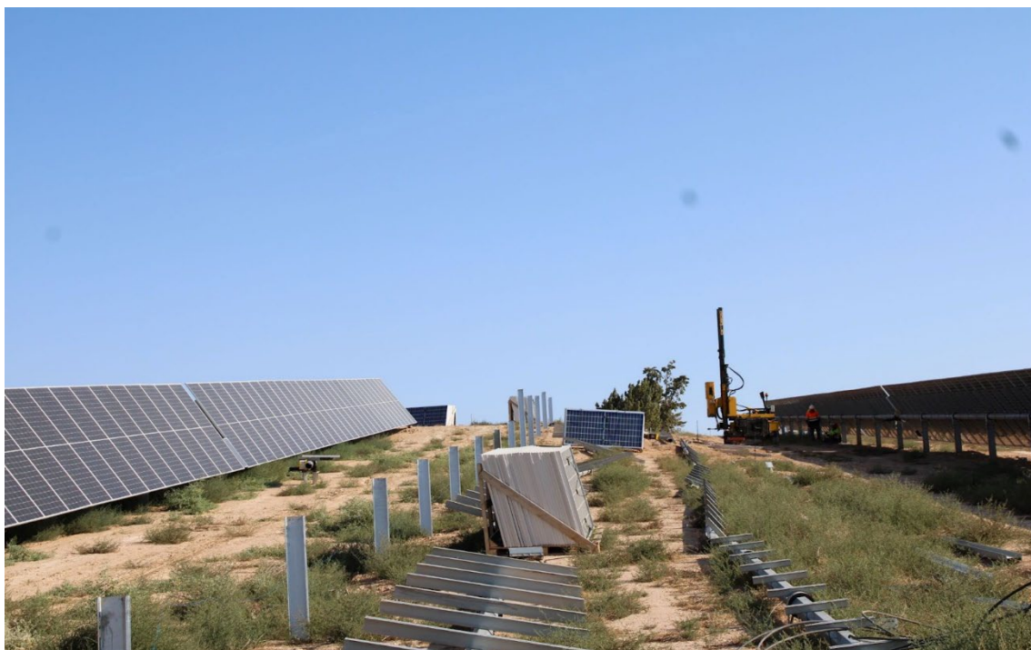
Fotografía 8. Personal trabajando en la PSFV
