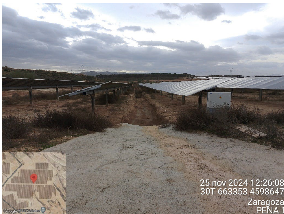
Fotografía 1. Red de drenaje interna de la PSFV
