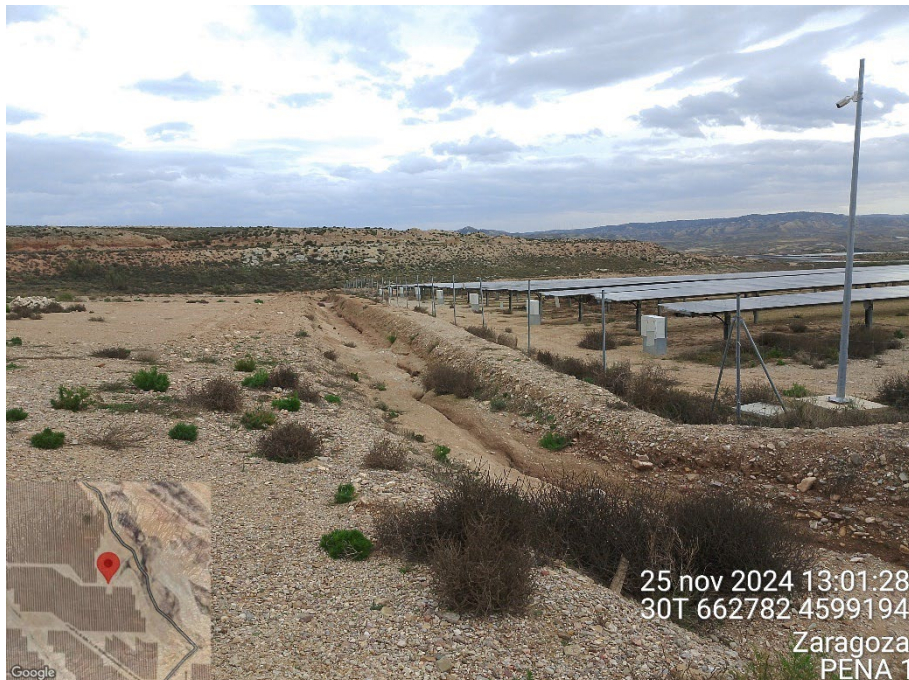
Fotografía 3. Red de drenaje de la PSFV
