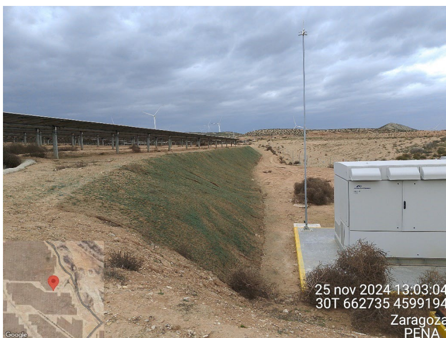
Fotografía 3. Talud con malla de fibra de coco revegetado en la PSFV
