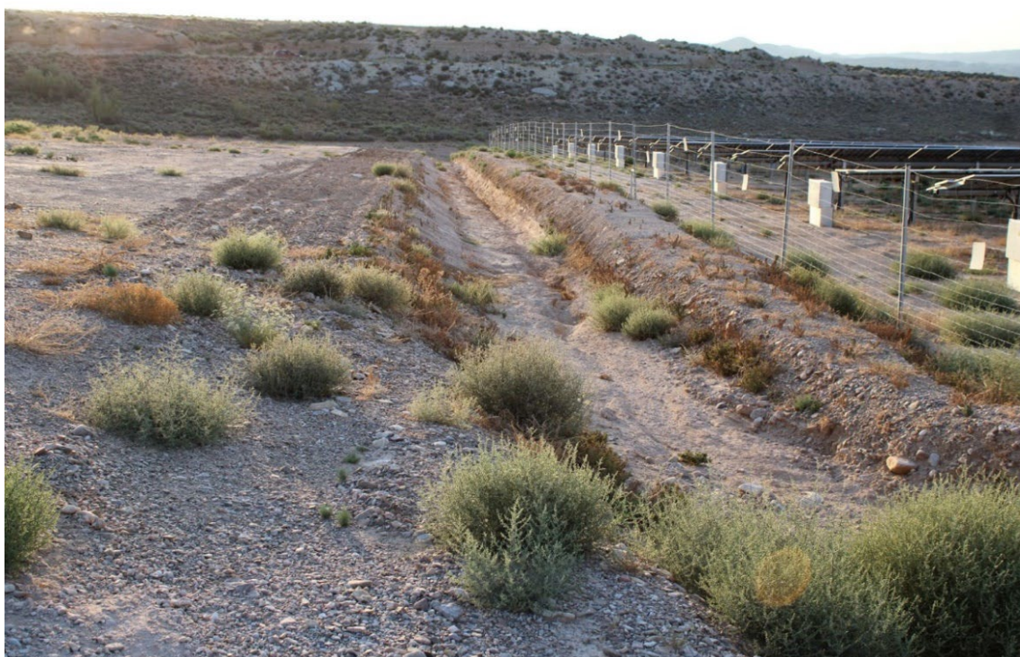
Fotografía 5. Infraestructuras de drenaje en PSFV Pena 1
