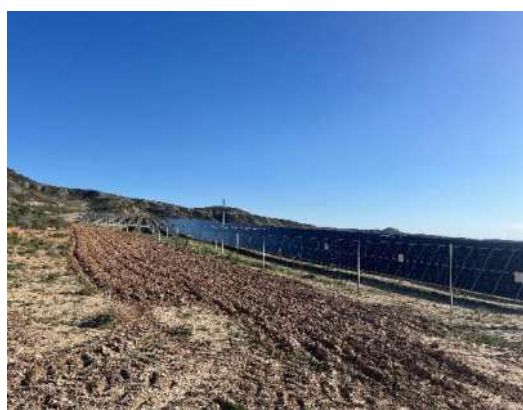
Figura 46 Ahoyado del terreno
