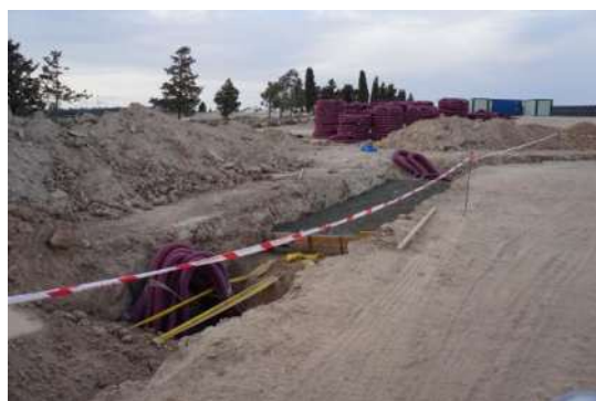
Figura 4 Encofrado de zanja
