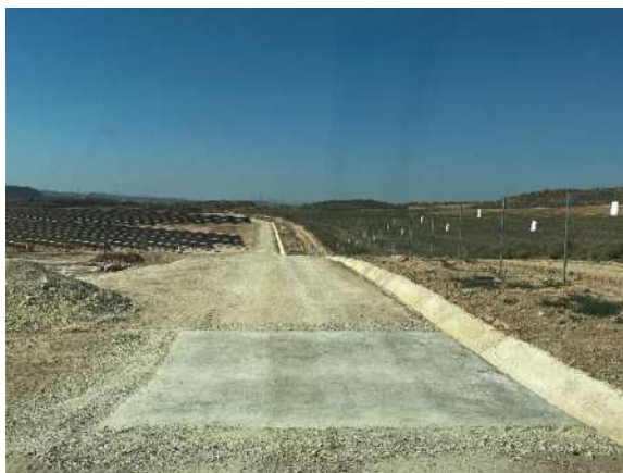
Figura 19 Cimentación del vial interno
