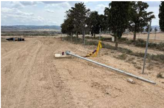
Figura 8 Montaje de los postes de la CCTV
