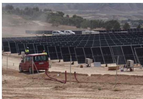
Figura 11 Instalación de cuadros eléctricos
