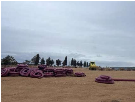
Figura 22 Acopio de material
