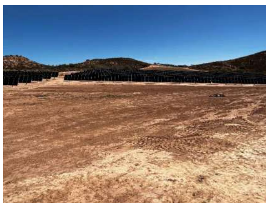
Figura 35 Extendido de tierra vegetal
