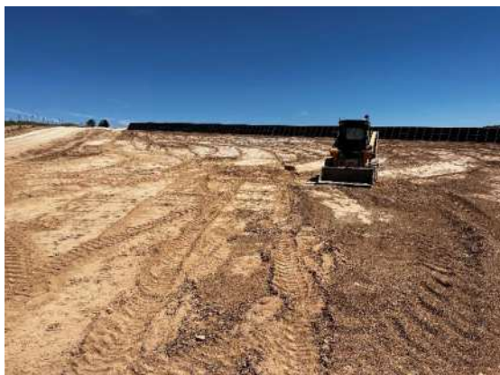
Figura 34 Extendido de tierra vegetal
