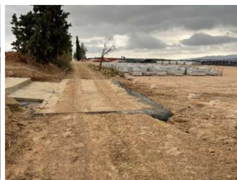
Figura 5 Cimentación del vial interno
