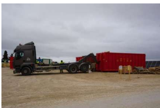
Figura 30 Retirada de residuos industriales
