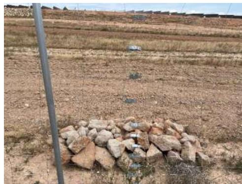
Figura 37 Vallado perimetral bien conservado
