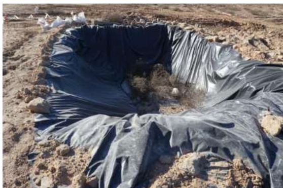
Figura 28 Lavadero de cubas de hormigón
