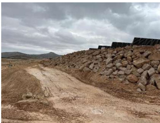
Figura 18 Muro de escollera terminado
