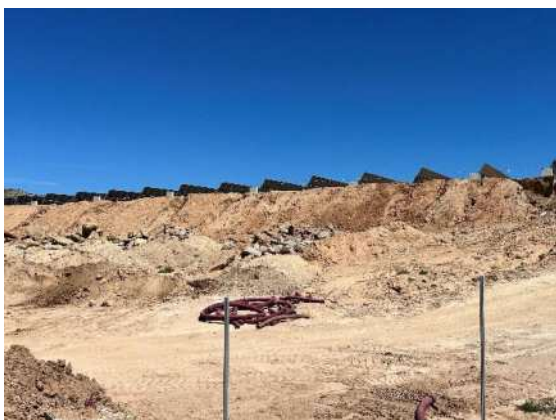
Figura 17 Ladera con potencial erosivo
