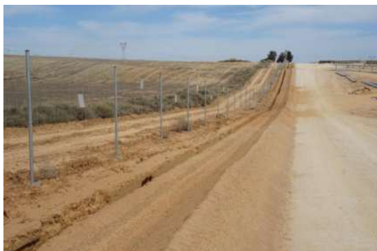
Figura 9 Vallado y zanja para la red eléctrica
