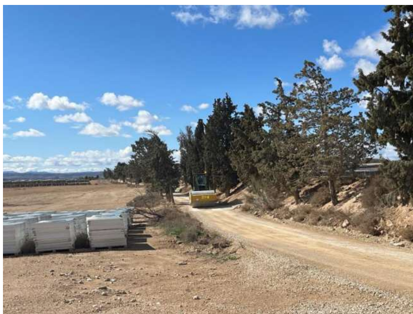
Figura 21 Restauración de los viales
