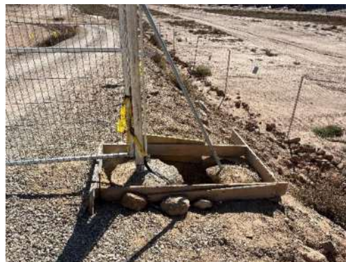
Figura 3 Cimentación de las puertas
