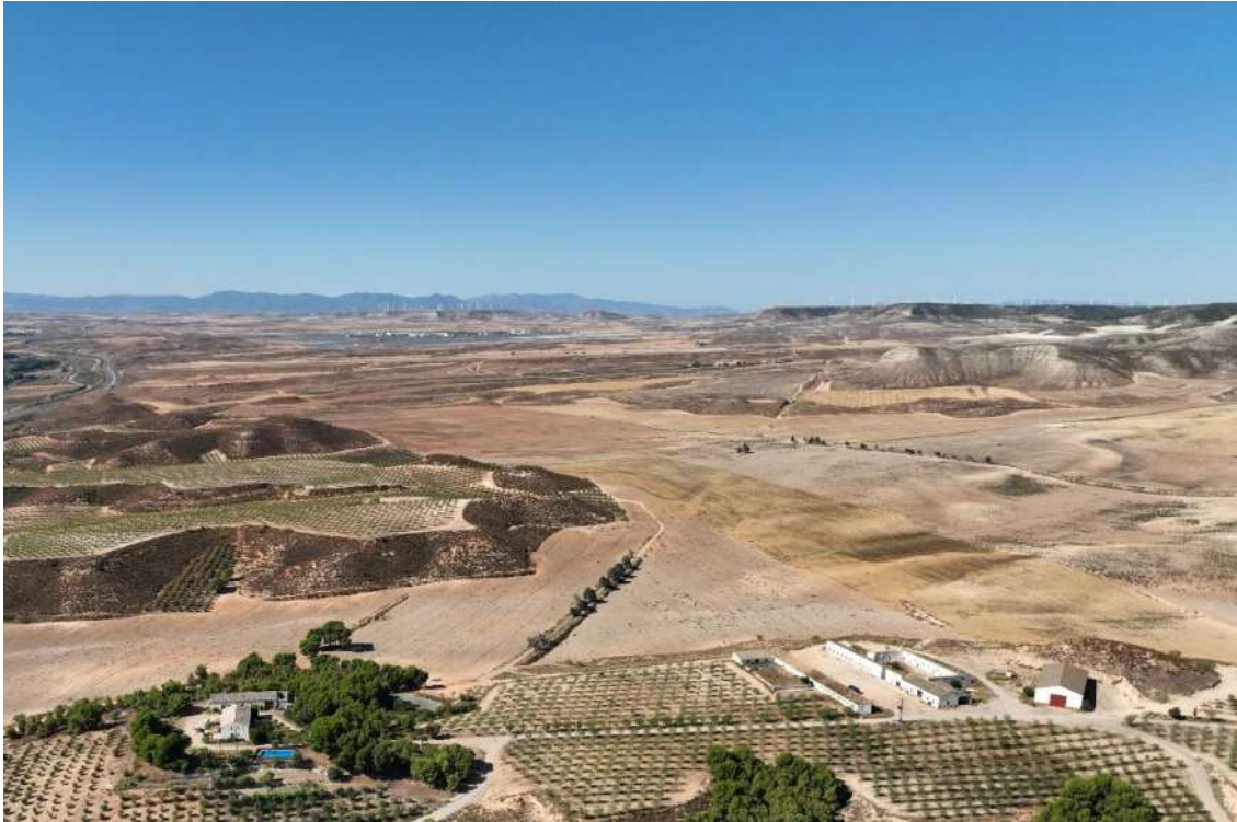
Figura 1 Vista aérea de la planta, septiembre 2022
