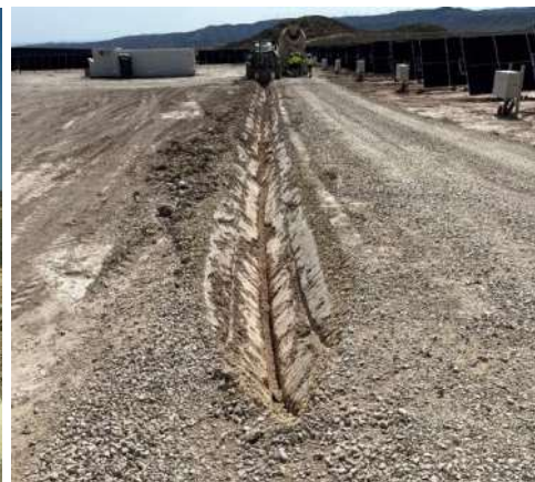
Figura 20 Cimentación de las cunetas
