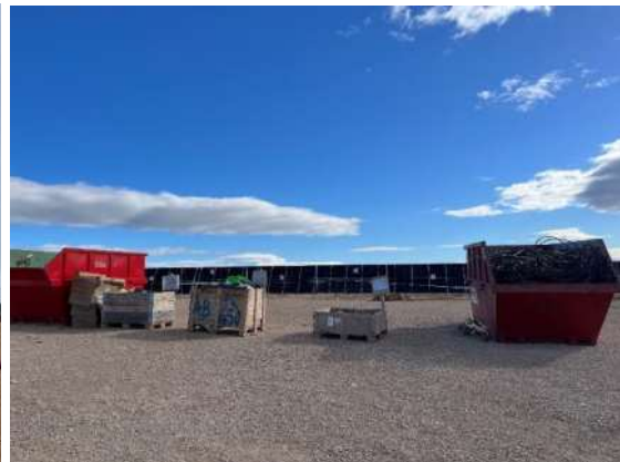
Figura 23 Punto limpio de RNP
