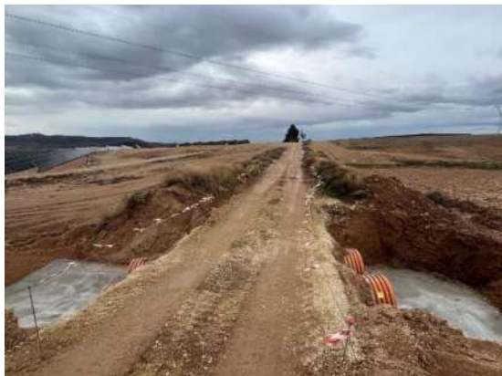
Figura 15 Colocación de tuberías de drenaje
