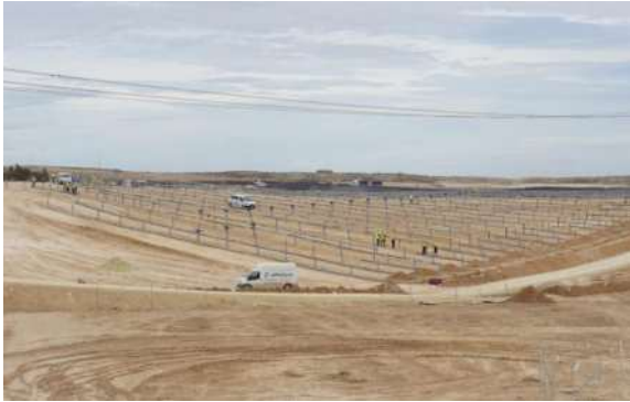
Figura 6 Instalación de seguidores
