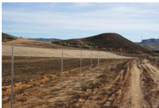
Figura 36 Instalación de los postes del vallado
