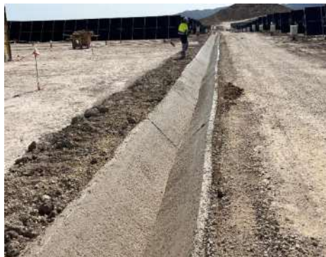
Figura 4 Trabajos de cimentación de cunetas
