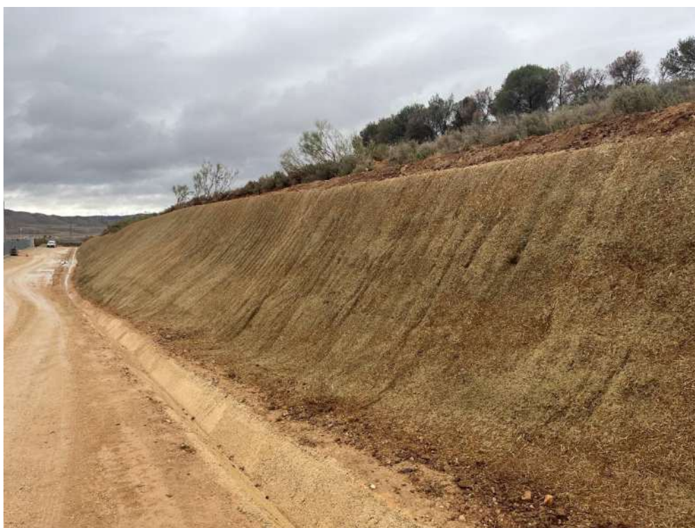
Figura 9 Hidrosiembra en la ladera adyacente de la SET
