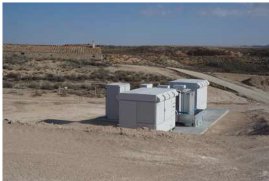
Figura 12 Centro de transformación
