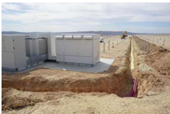
Figura 9 Tendido de cable de baja tensión
