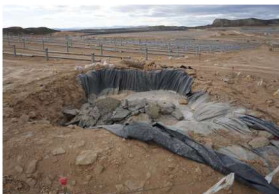
Figura 26 Lavadero de cubas de hormigón
