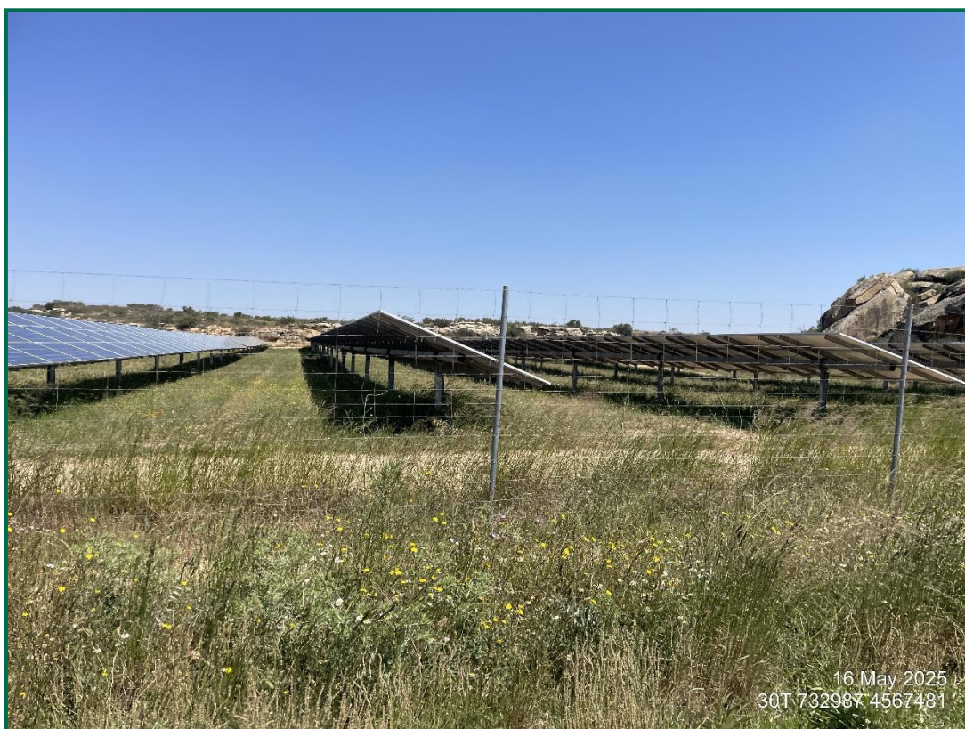
Fotografía 3. Vegetación entre placas actualmente.
