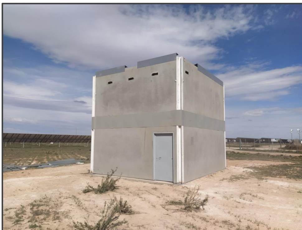
Fotografía 9. Exterior del primillar de nueva construcción.
