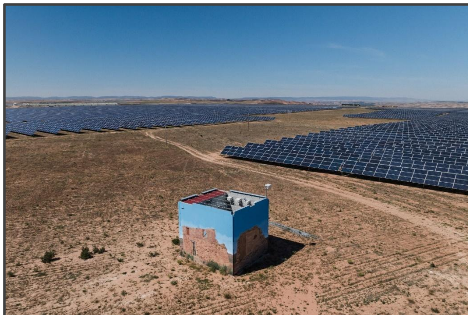
Fotografía 10. Exterior del primillar, pintado.
