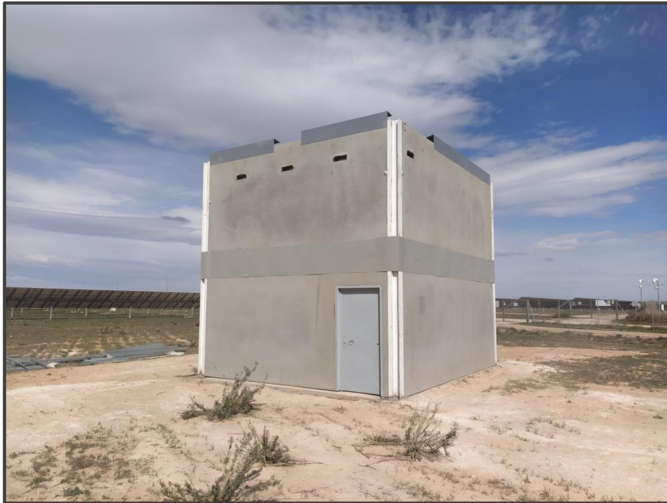
Fotografía 7. Exterior del primillar de nueva construcción.
