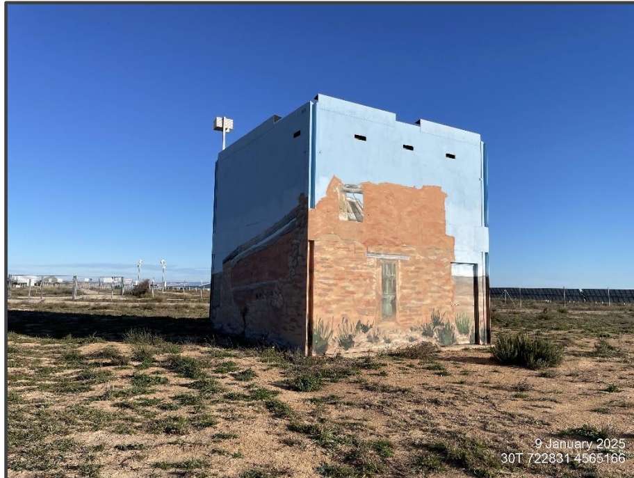
Fotografía 9. Exterior del primillar, pintado.
